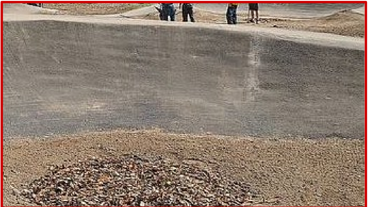
Nieprawidłowe połączenie nawierzchni jezdnej w miejscu przerwy technologicznej
