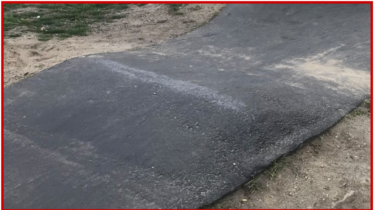
Niepoprawnie wykonany garb – o licznych nierównościach i złym kształcie
