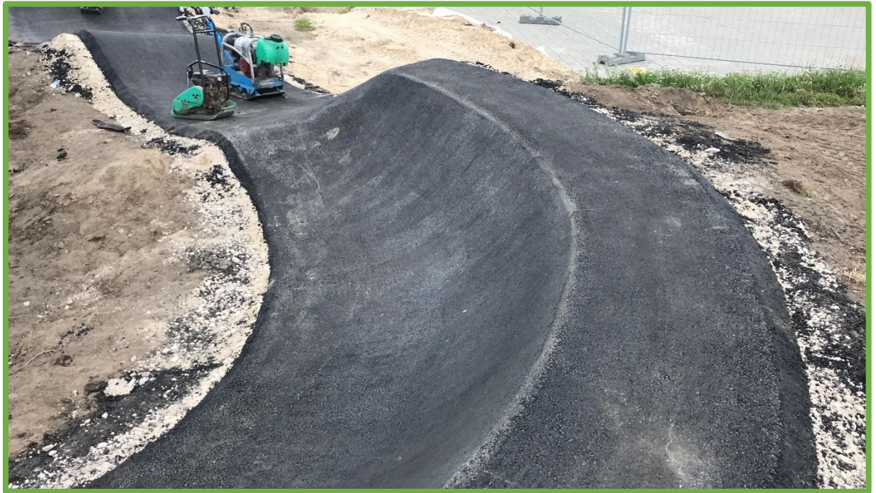
Prawidłowo wykonana nawierzchnia asfaltowa – jednorodna i gładka.
