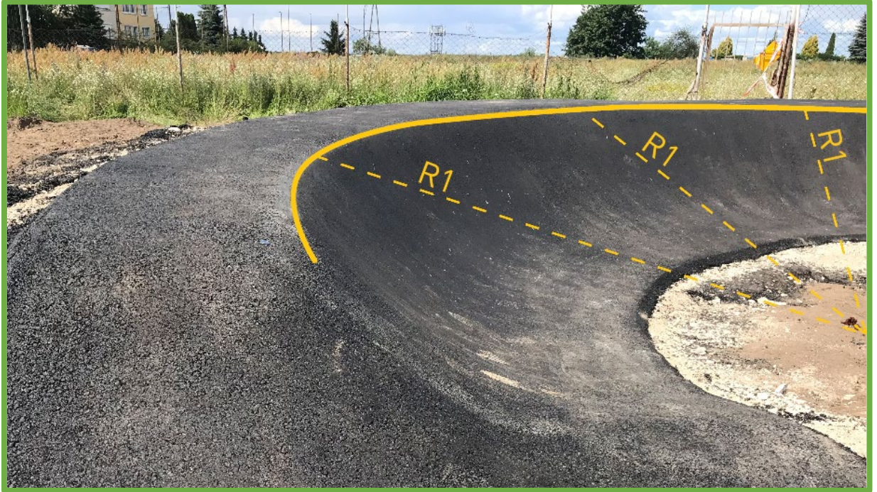
Prawidłowo wykonany zakręt profilowany – o jednostajnym promieniu zakrętu
