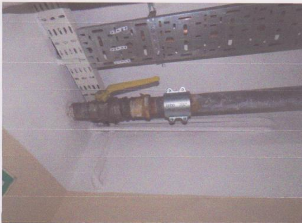
Fot. 12 - Liczne skorodowane odcinki rur instalacji wody bytowej i hydrantowej na poziomie piwnic, w wielu miejscach zamontowane obejmy naprawcze typu gebo świadczące o licznie występujących przeciekach na w/w instalacjach.
