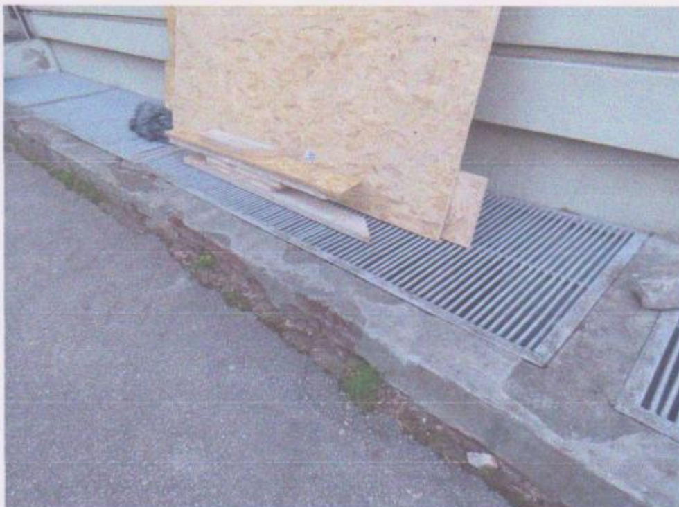
Fot. 2 - Korozja na kratkach studzienek doświetlających okna piwniczne; ubytki tynku na obrzeżach studzienek
