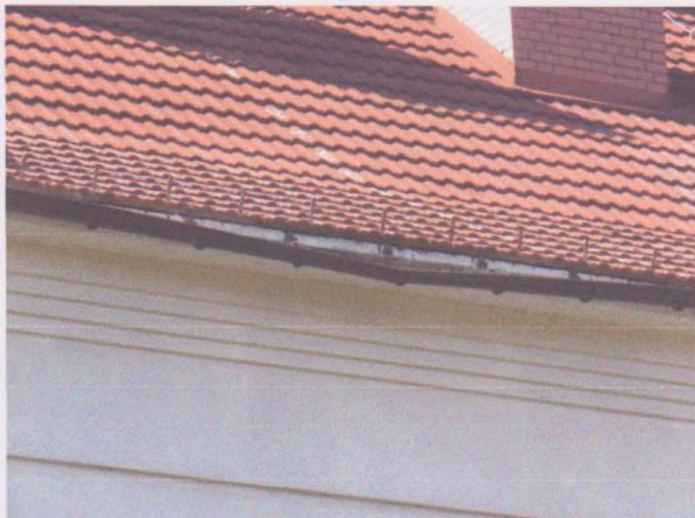
Fot. 8 - W kilku miejscach na gzymsach pod rynną od strony północnej widoczne spękania, ubytki i odspojenia tynku
