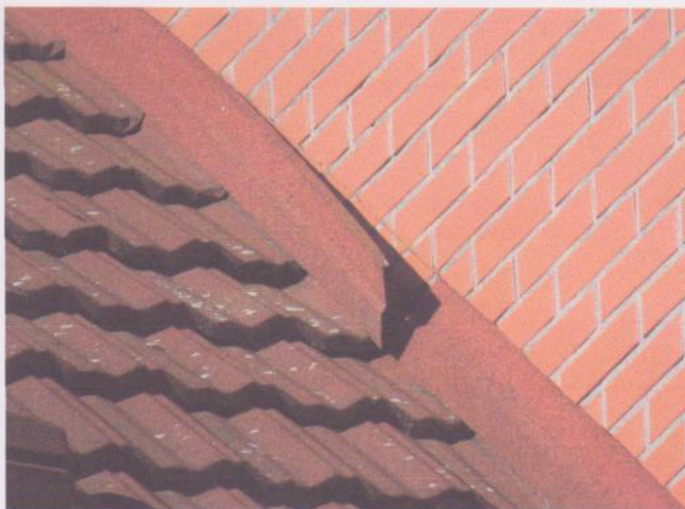
Fot. 4 Oderwany fragment obróbki blacharskiej na styku pokrycie - komin - od strony północnej
