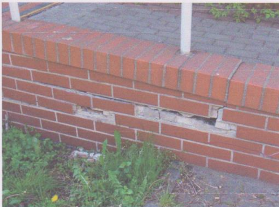
Fot. 10 - Odspojone tynku na schodach zewnętrznych i podjeździe do poradni specjalistycznych (wejście od ulicy)
