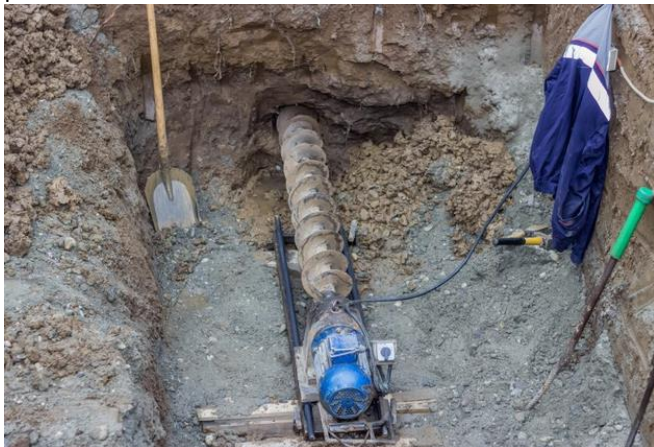
Rys. 30. Wykonywanie przewiertu
