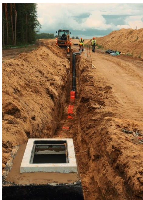
Rys. 34. Zamontowana studzienka kablowa
