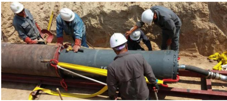
Rys. 28. Przecisk z ubijakiem umieszczonym za rurą stalową
