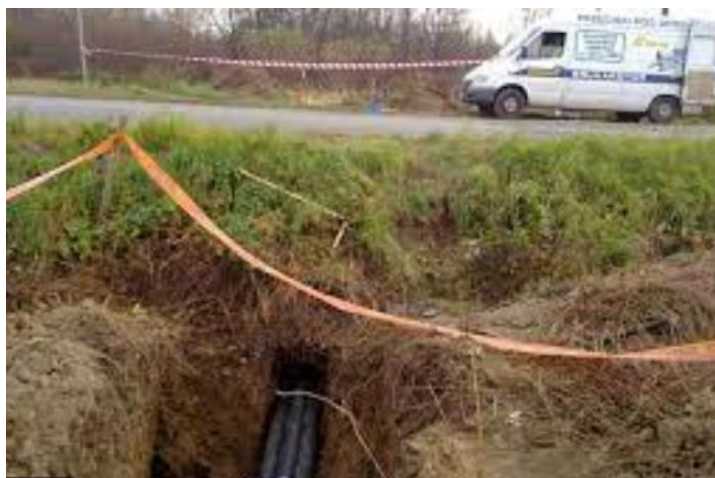
Rys. 31. Kanał kablowy umieszczony metodą przewiertu
