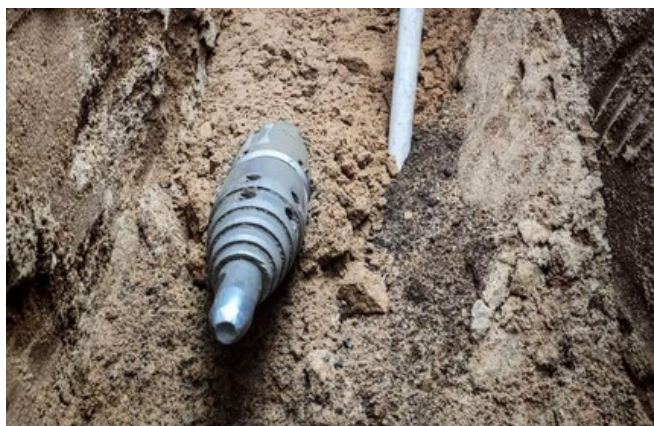
Rys. 27. Kret ciągnący rurę
