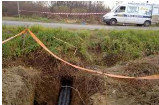
Rys. 31. Kanał kablowy umieszczony metodą przewiertu
