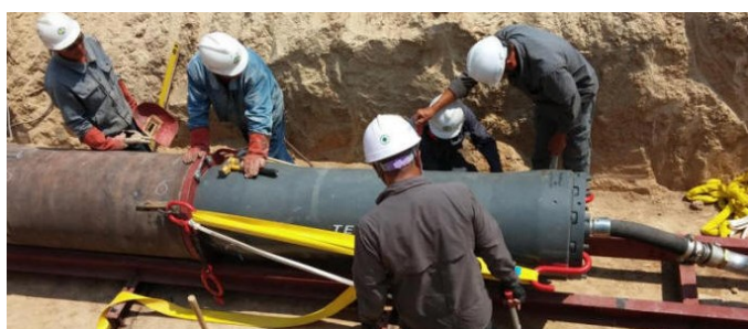
Rys. 28. Przecisk z ubijakiem umieszczonym za rurą stalową
