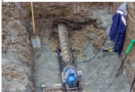
Rys. 30. Wykonywanie przewiertu
