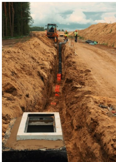
Rys. 34. Zamontowana studzienka kablowa
