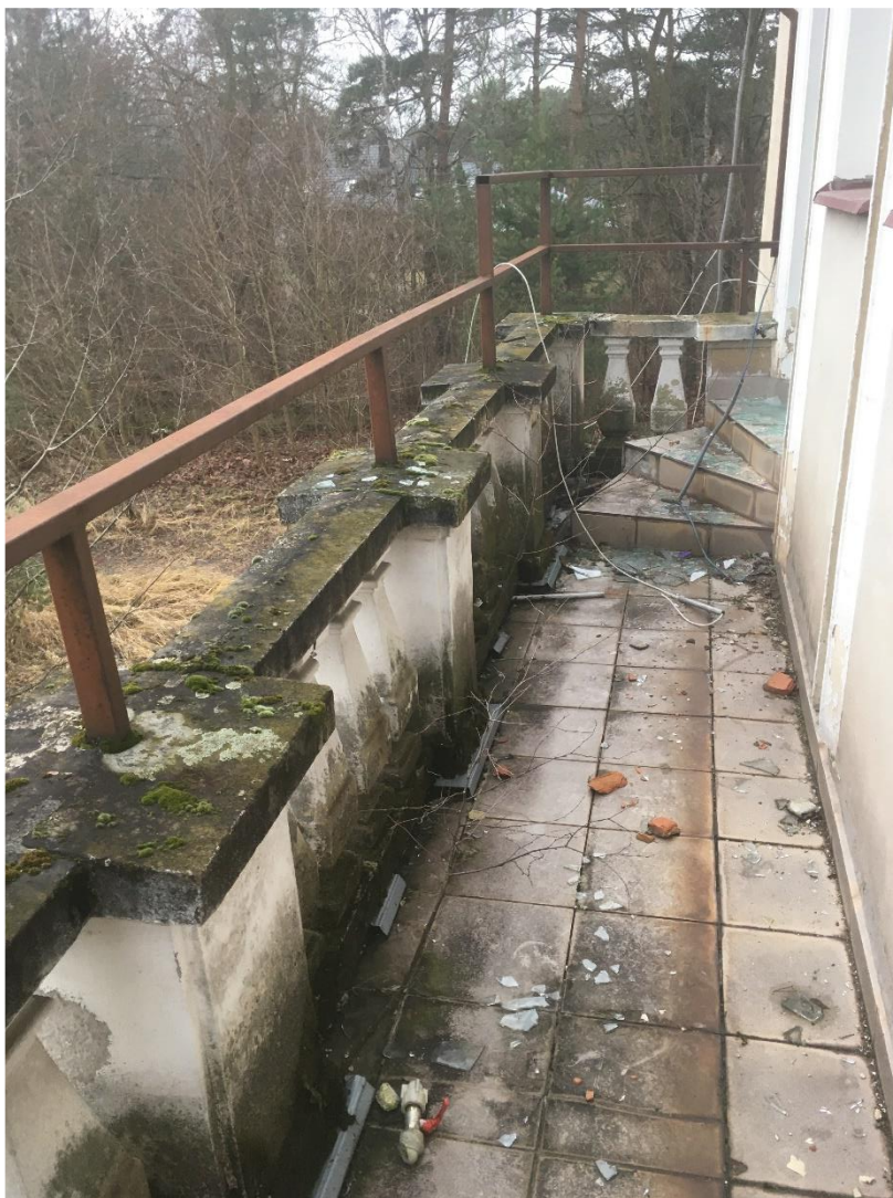
Fot. 40. Balkon na elewacji południowej, nawierzchnia wtórna, balustrada oryginalna.
