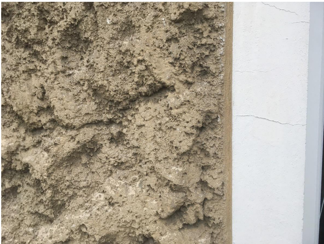
Fot. 52. Budynek II, tynk strukturalny, warstwa malarska wtórna.
