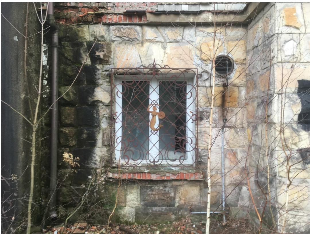
Fot. 32. Budynek II, przy szybie windowym, widoczne skutki poważnego zawilgocenia na styku brył. Widoczna kratka z Syrenką.
