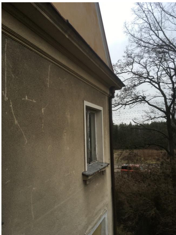
Fot. 20. Budynek I, gładko tynkowana ściana, widoczny profil gzymsu koronującego.
