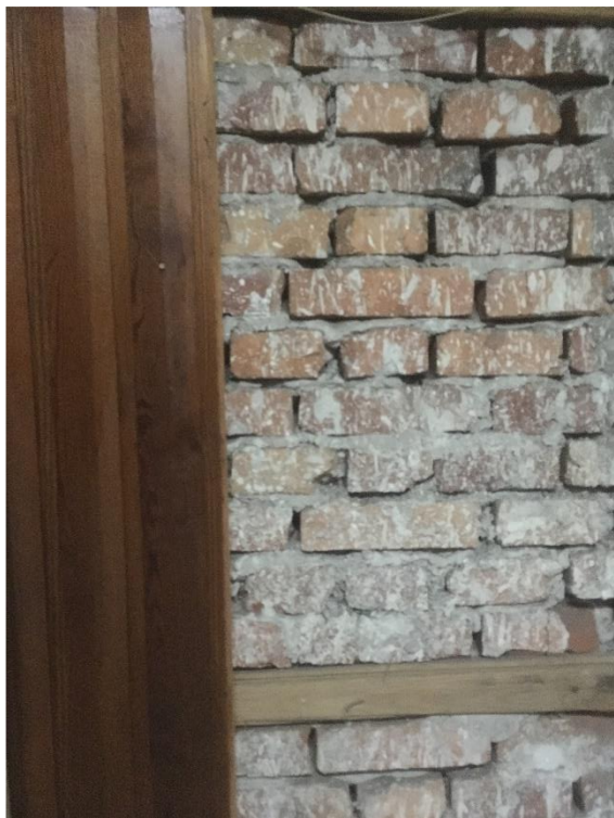
Fot. 90. Budynek I, kondygnacja druga, odsłonięty mur oryginalny, widoczny dobry stan zachowania.
