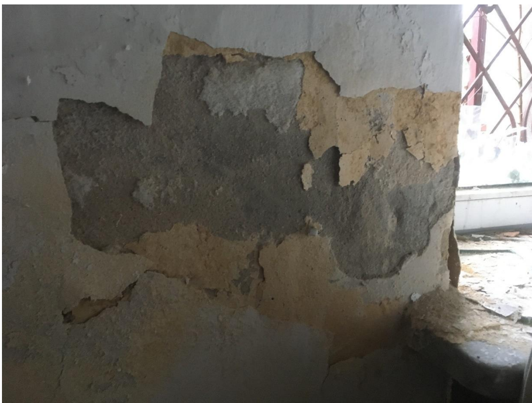
Fot. 83. Budynek II, na wysokości szybu windowego, degradacja tynku na skutek zastosowania zaprawy cementowej.
