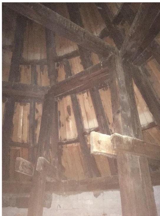
Fot. 103 i 104. Więźba dachowa wieży, stan zachowania dobry.
