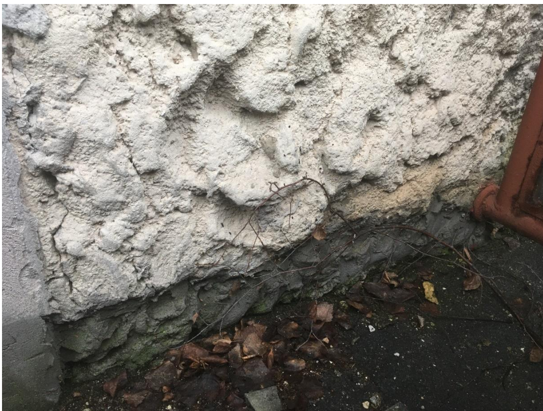
Fot. 53. Budynek II, tynk strukturalny, warstwa malarska wtórna, u dołu widoczne uzupełnienia.
