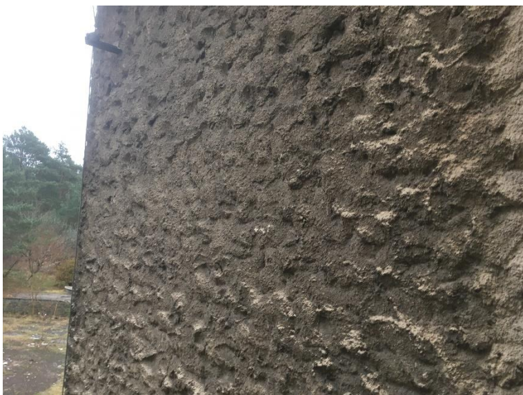
Fot. 35. Powierzchnia tynku strukturalnego na budynku II.
