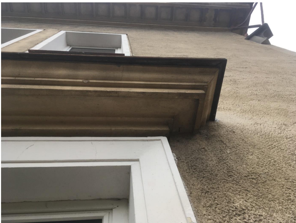
Fot. 39. Profil gzymsu międzykondygnacyjnego. U góry widoczne kasetony pod okapem dachu.
