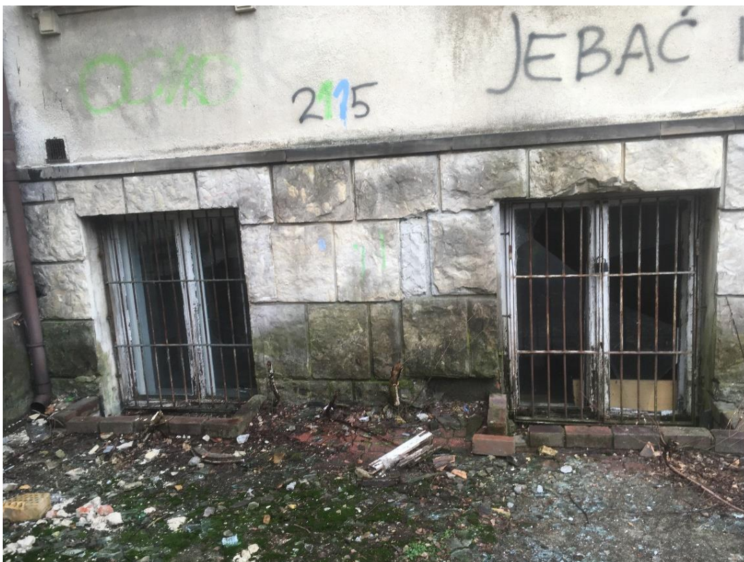
Fot. 28. Budynek I, skutki zawilgocenia fundamentów w związku z penetracją wody od strony podłoża. Ciemne przebarwienia i warstwy porostów świadczą o długotrwałym i systematycznym działaniu wody na mur fundamentu i przyziemia.
