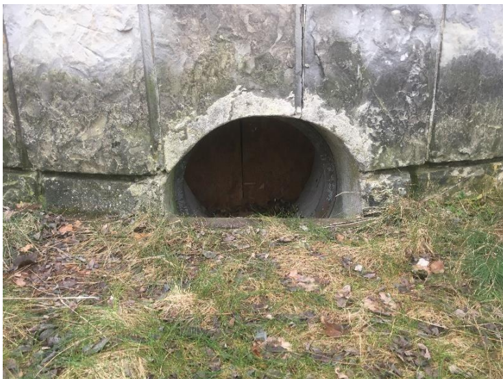
Fot. 26. Wieża, otwór wentylacyjny, wtórne warstwy cementowe.
