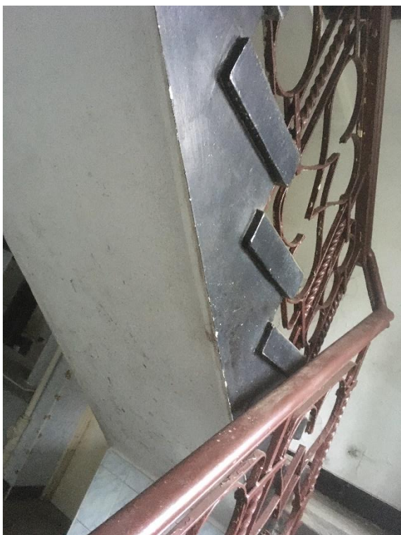
Fot. 66 i 67. Klatka schodowa w budynku II po stronie wschodniej, po lewej konstrukcja schodów, po prawej spoczniki pokryty dwukolorowym lastryko.
