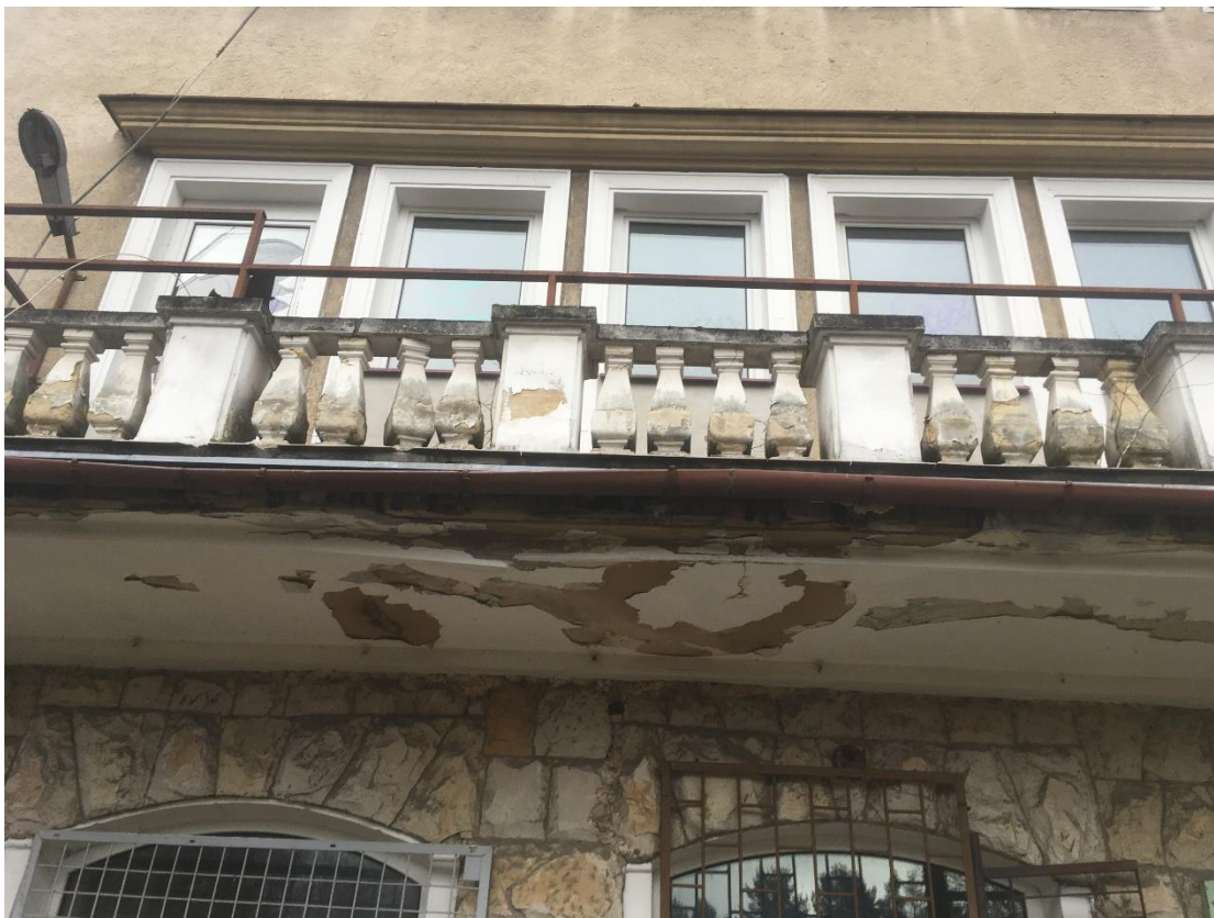
Fot. 44. Balkon na elewacji południowej, degradacja płyty balkonu związana z destrukcyjnym działaniem wody.
