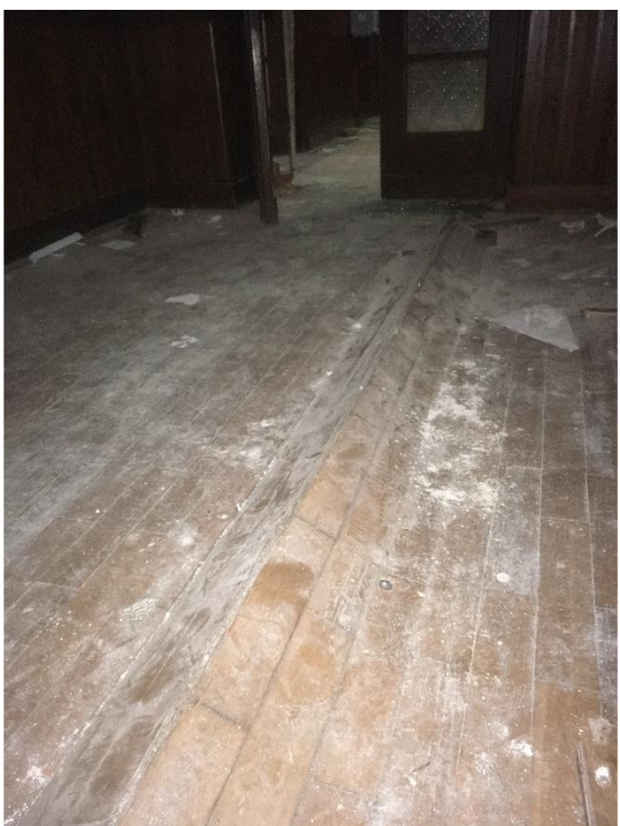
Fot. 97 i 98. Budynek II, parkiety, widoczne uszkodzenia i deformacje.
