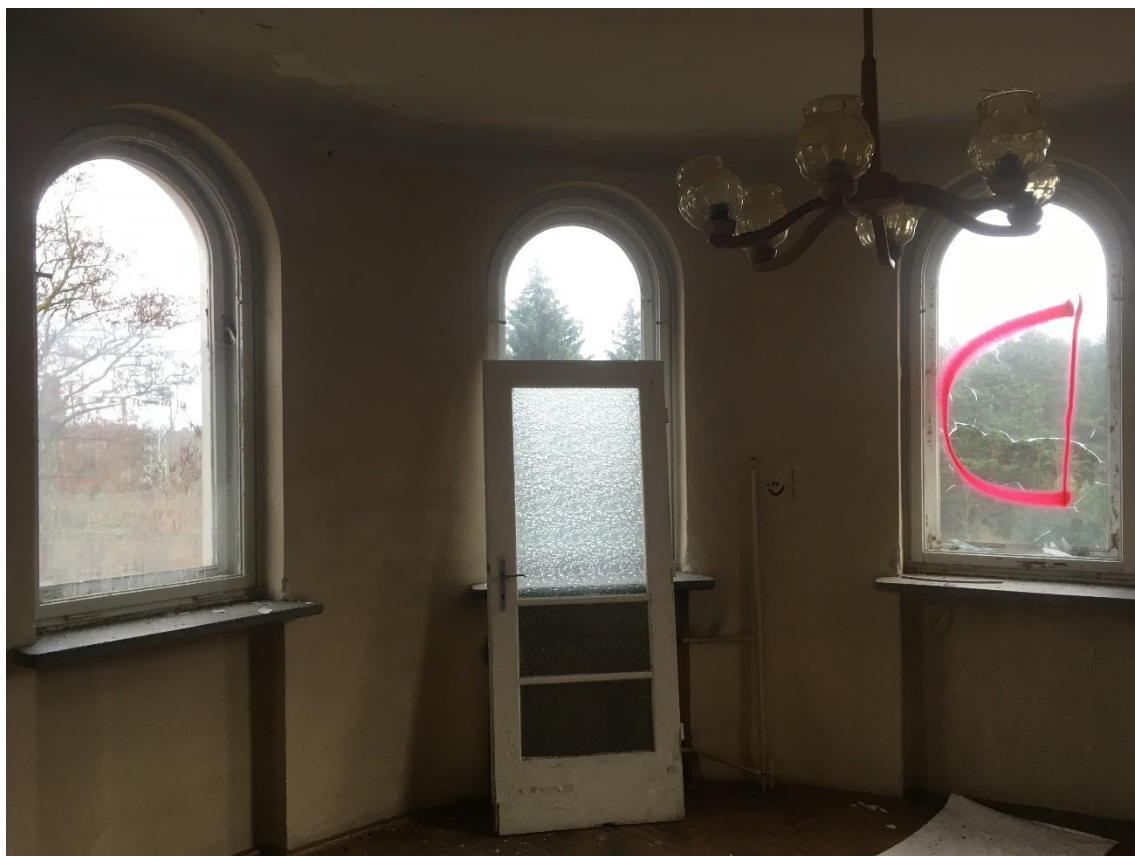
Fot. 69. Wieża, trzecia kondygnacja, zachowane okna, podwójne, zamknięte łukiem półpełnym.
