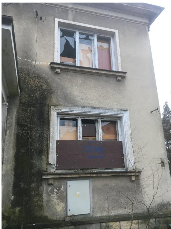
Fot. 16. Ganek, skutki zaciekania wody z tarasu.
