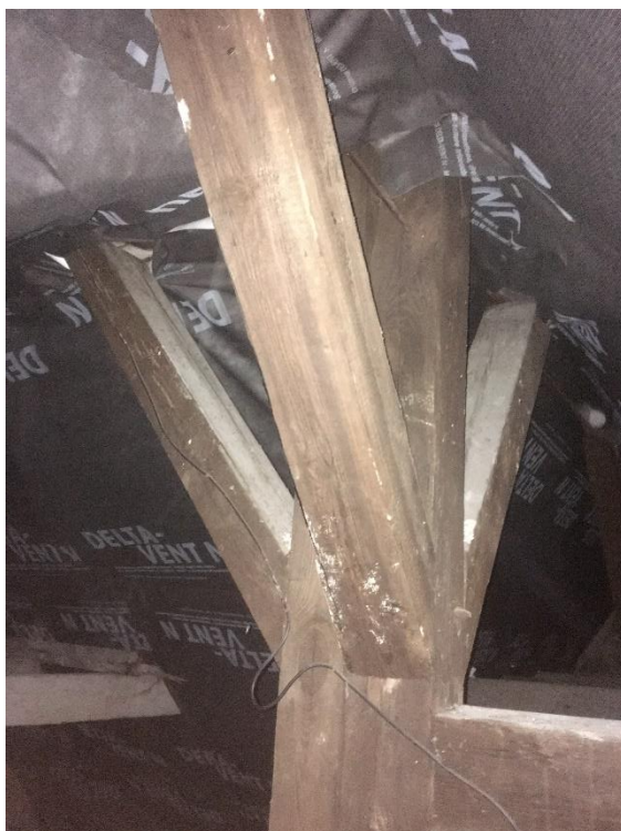
Fot. 99 i 100. Więźba dachowa, słupy i wiązary, widoczny dobry stan zachowania.
