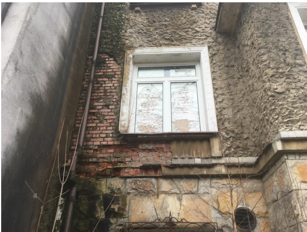
Fot. 33. Styk szybu windowego ze ścianą budynku II, skutki długotrwałego i poważnego zawilgocenia, widoczne ubytki tynku, degradacja cegły, częściowo utracona dekoracja podokienna w formie panelu geometrycznego o daszkowatym ukształtowaniu.
