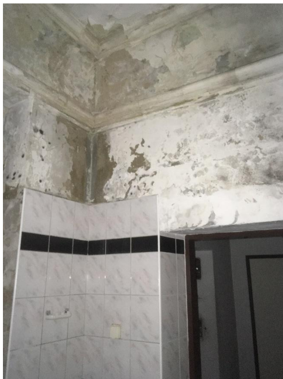
Fot. 77 i 78. Budynek II, wnętrza z dekoracją sztukatorską- widoczny stan zachowania. Boazeria i glazura są wtórne.
