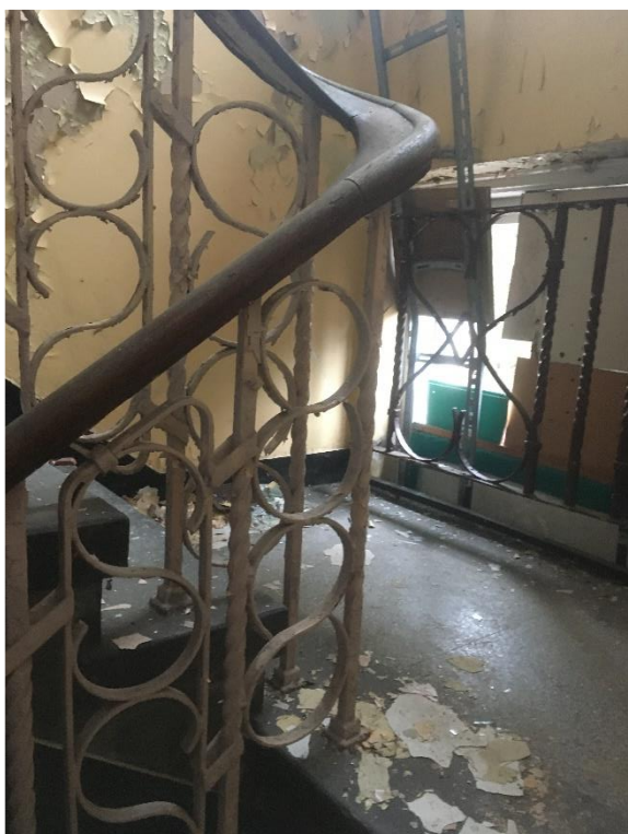
Fot. 61 i 62. Budynek I, klatka schodowa, oryginalna nawierzchnia z lastryko i balustrada z pochwytym. Na poziomie podłogi widoczne okienka doświetlające.
