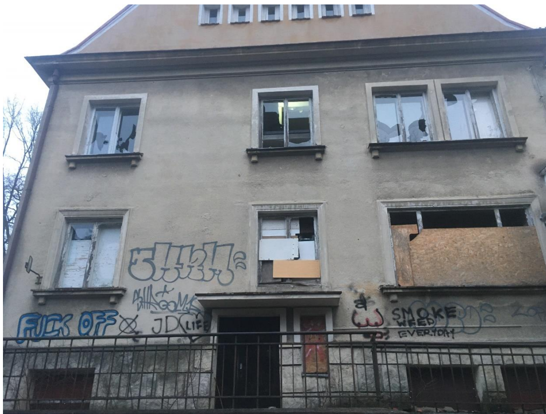
Fot. 9. Budynek I, strona zachodnia, widoczna różnica w opracowaniu opasek okiennych.
