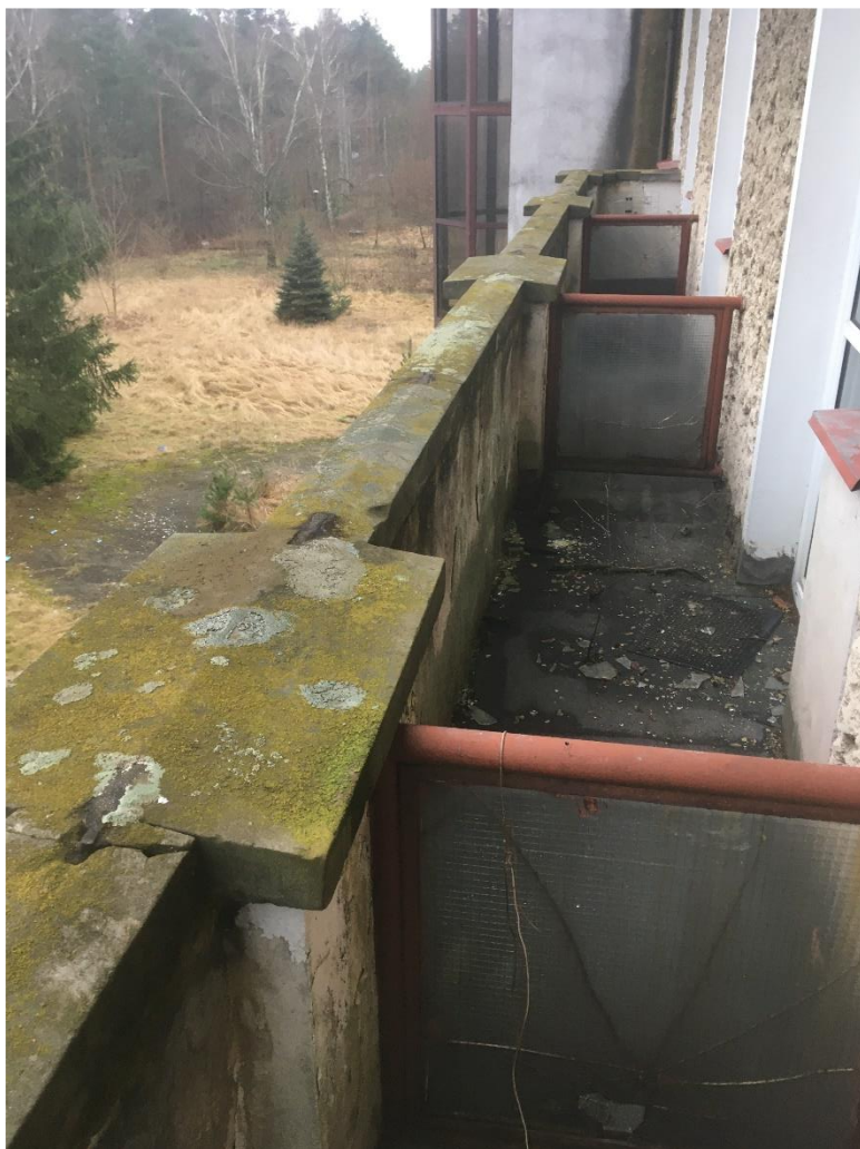
Fot. 46. Taras na elewacji wschodniej, ryzalit budynku II. Balustrada pełna oryginalna, murowana i tynkowana.
