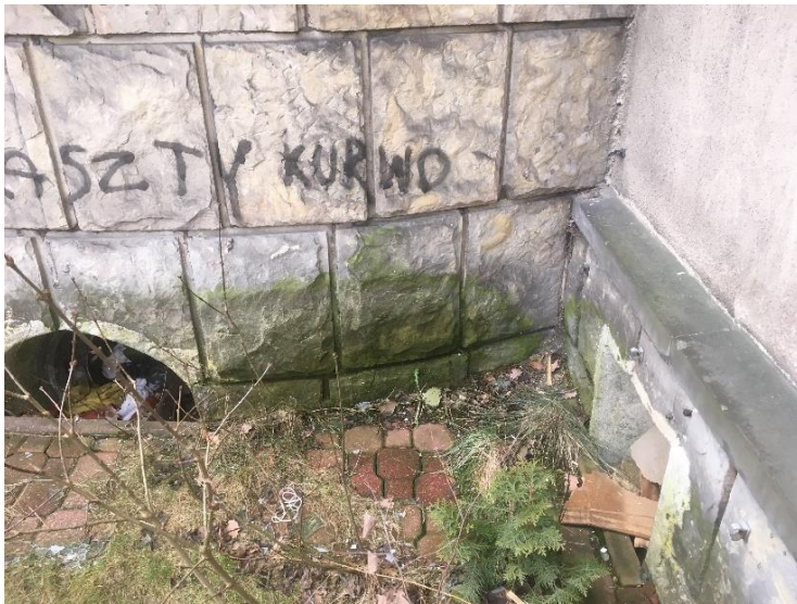
Fot. 25. Styk wieży i budynku I, pierwsza kondygnacja, widoczne skutki zawilgocenia fundamentów.
