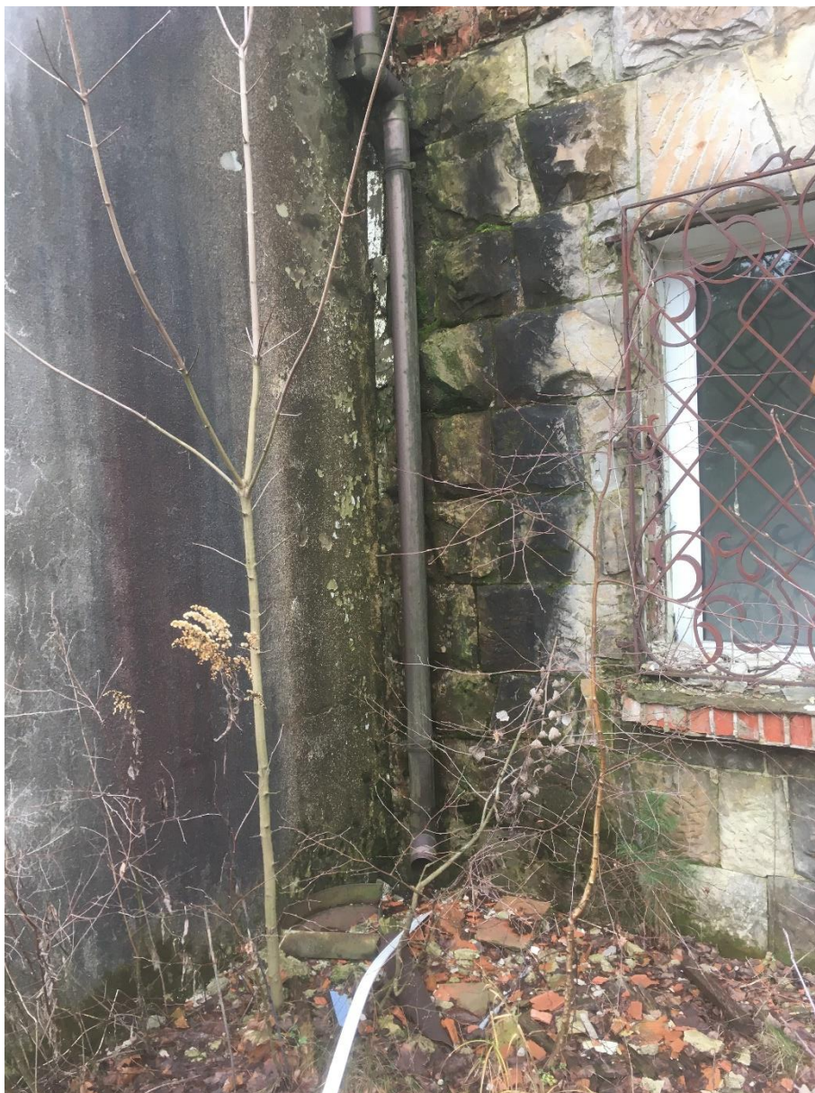
Fot. 34. Styk szybu windowego z budynkiem II, skutki długotrwałego i poważnego zawilgocenia, wynikającego z zaciekania wody opadowej ( wadliwy, nieszczelny spust).
