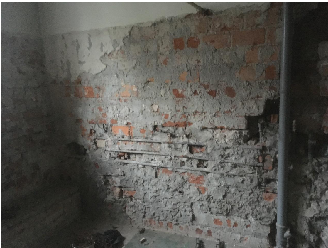
Fot. 88. Budynek II, kondygnacja pierwsza, widoczna izolacja pozioma.
