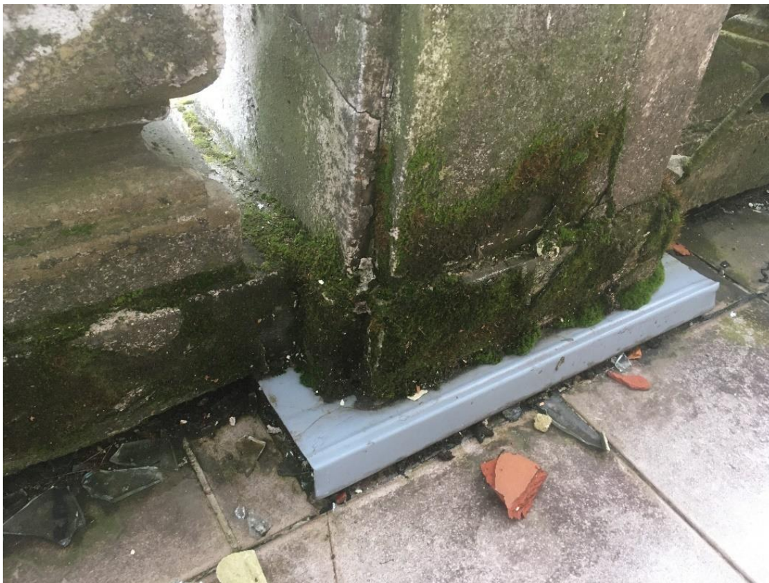
Fot. 43. Dolna część balustrady. Widoczna dylatacja ponad wtórną nawierzchnią z płytek.
