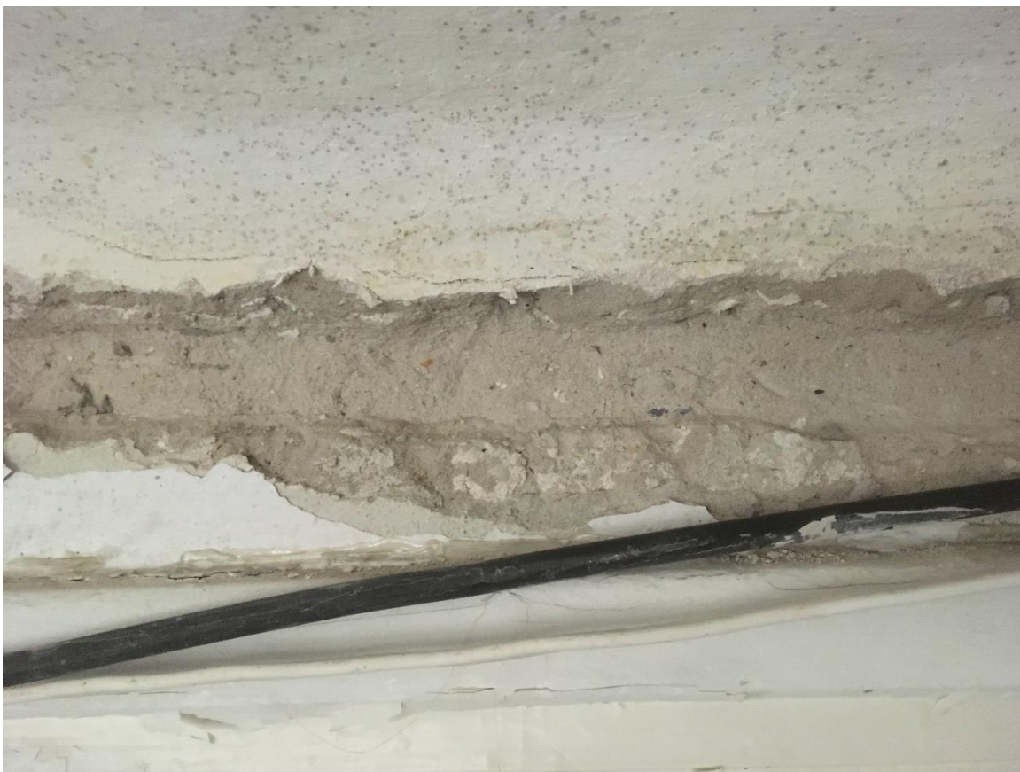
Fot. 91. Budynek I, kondygnacja druga, widoczny tynk oryginalny, spoisty, drobnoziarnisty, najprawdopodobniej wapienno-cementowy. Nawarstwienia farby z dużym prawdopodobieństwem wskazują na biały jako kolor pierwotny.
