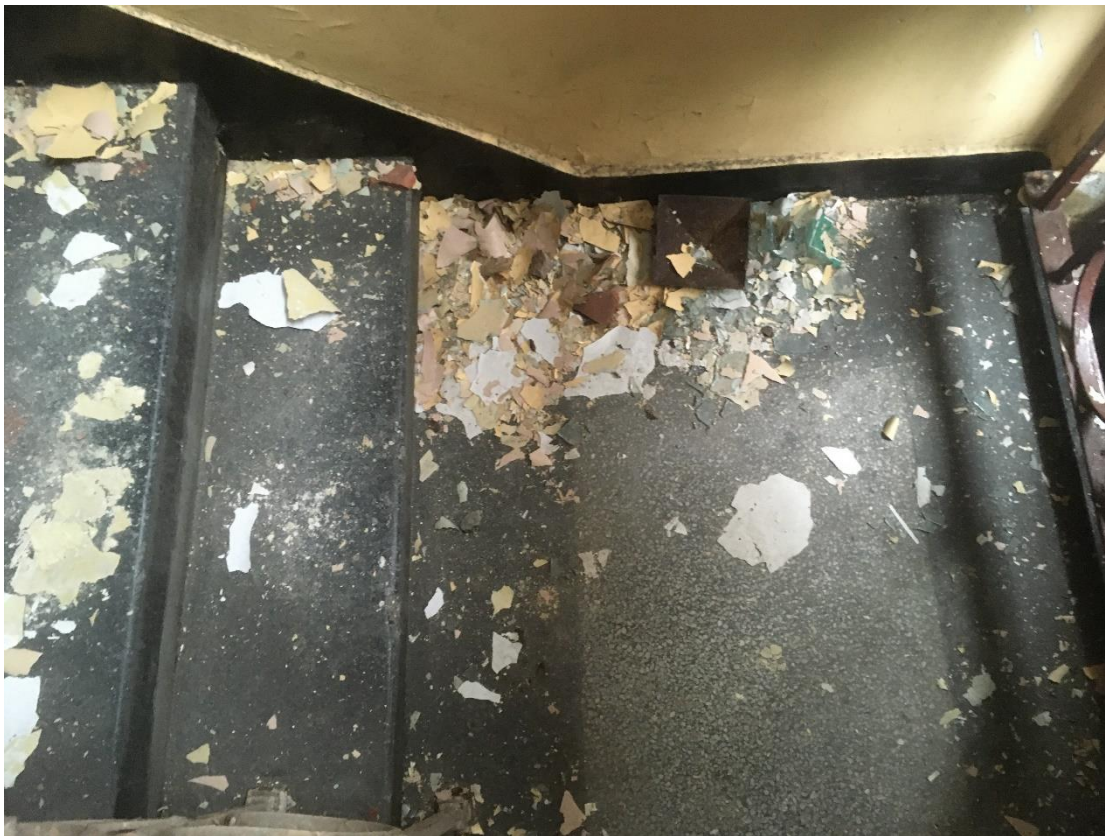
Fot. 64. Klatka schodowa w budynku I, nawierzchnia z lastryko.
