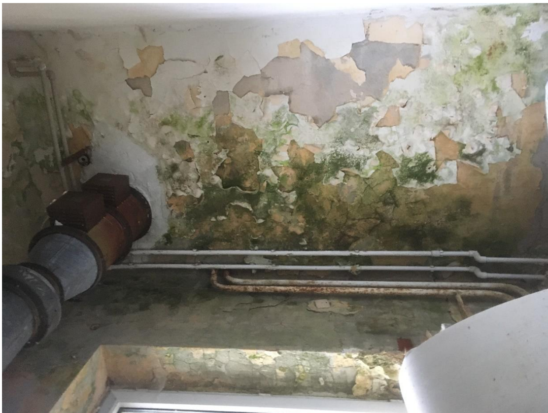
Fot. 82. Budynek II, część centralna, na wysokości szybu windowego, widoczne poważne zawilgocenie, nawarstwienia porostów i degradacja powierzchni.
