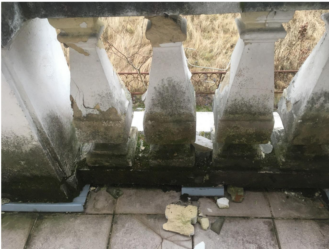
Fot. 42. Balustrada balkonu na elewacji południowej, tralki z zaprawy. Widoczne uzupełnienia formy i degradacja powierzchni zaprawy.
