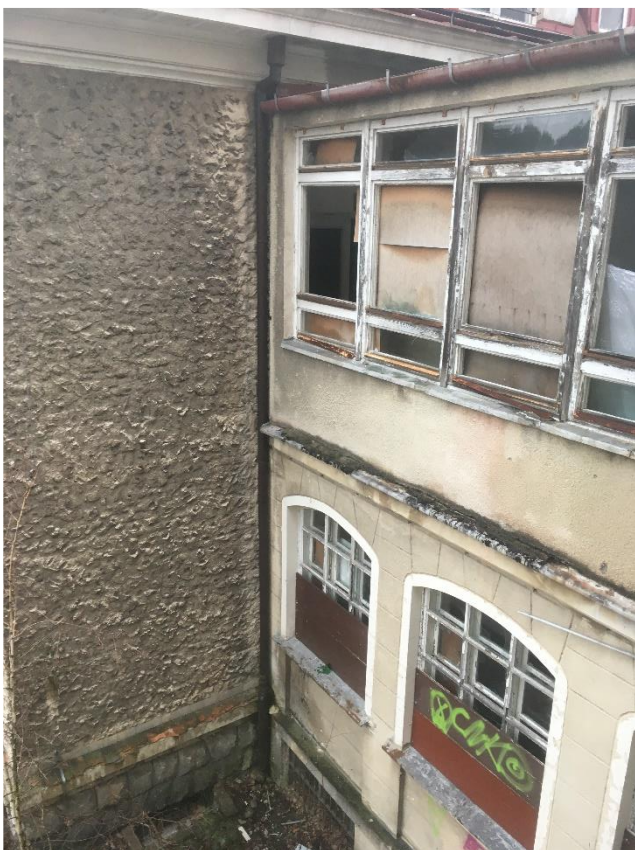
Fot. 22. Łącznik, strona wschodnia, widoczna zagłębiona w grunt kondygnacja pierwsza, kondygnacja druga pokryta tynkiem z dekoracją imitującą boniowanie, gzyms, powyżej wtórna, współczesna kondygnacja trzecia. Po lewej widoczny fragment budynki II, pokryty tynkiem strukturalnym.
