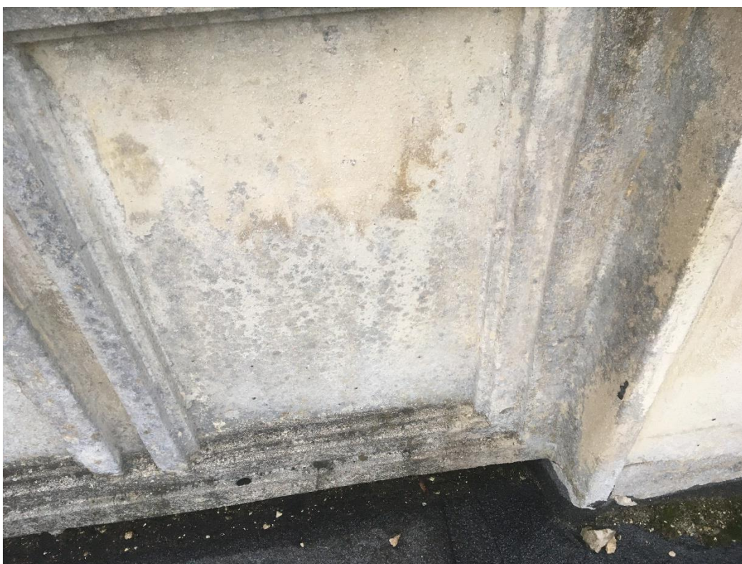
Fot. 49. Balustrada, dekoracja płycinowa wykonana w zaprawie. Na powierzchni widoczne zabrudzenia, zacieki oraz mikroorganizmy.
