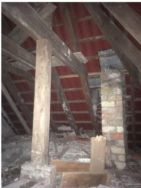
Fot. 99 i 100. Więźba dachowa, słupy i wiązary, widoczny dobry stan zachowania.
