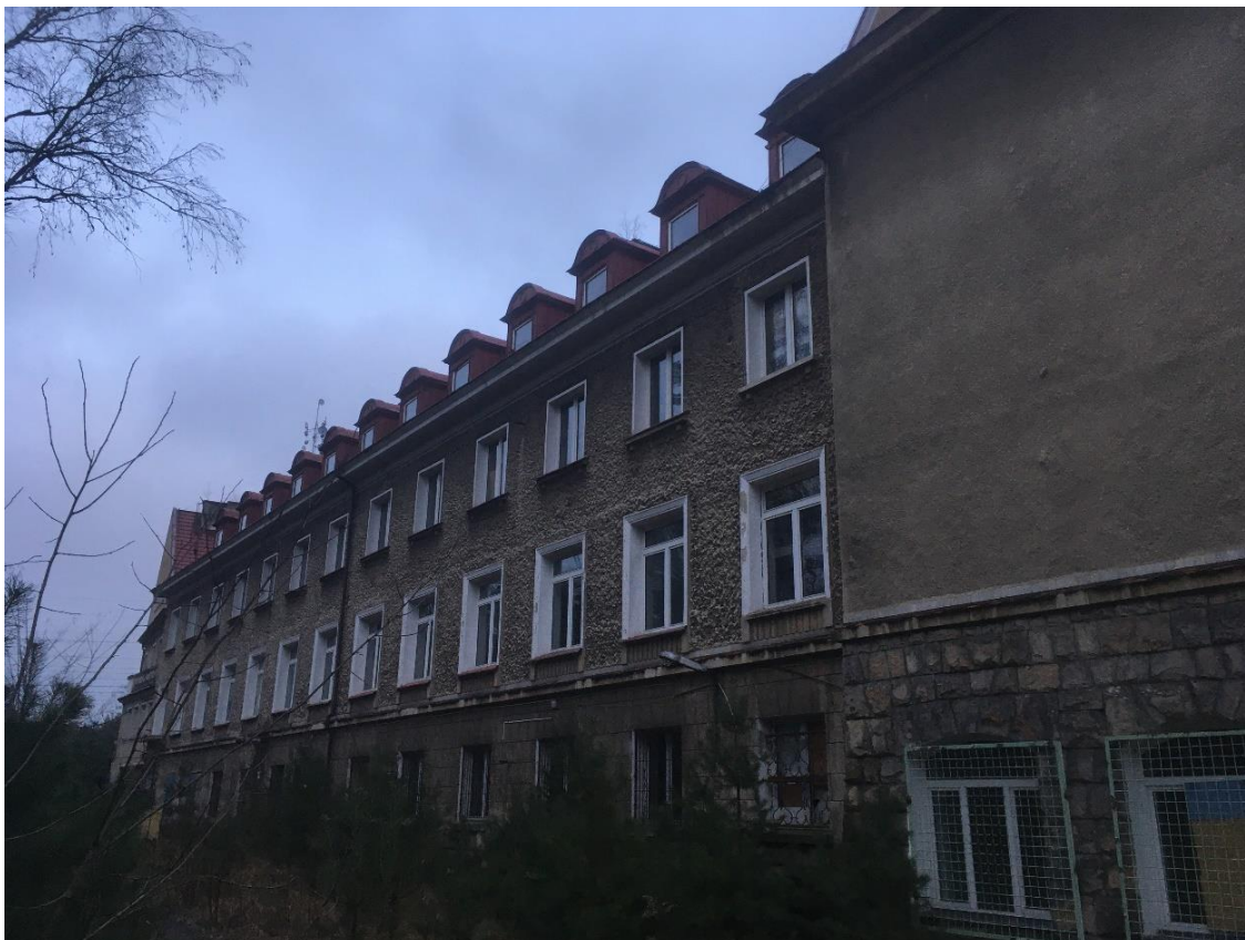
Fot. 7. Strona zachodnia, budynek II, styk partii pokrytych tynkiem strukturalnym i gładkim, w poziomie pierwszej kondygnacji styk okładziny kamiennej i tynku z imitacją okładziny.
