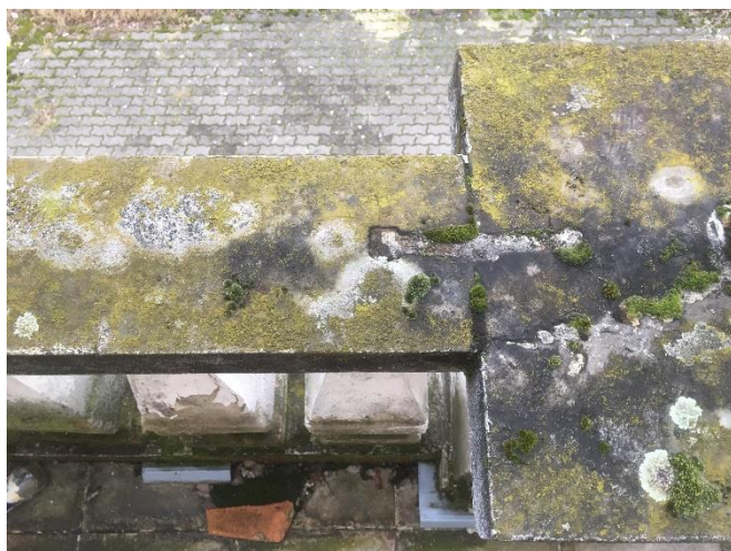
Fot. 41. Nakrywa balustrady balkonu na elewacji południowej. Widoczna degradacja zaprawy i nawarstwienia porostów.
