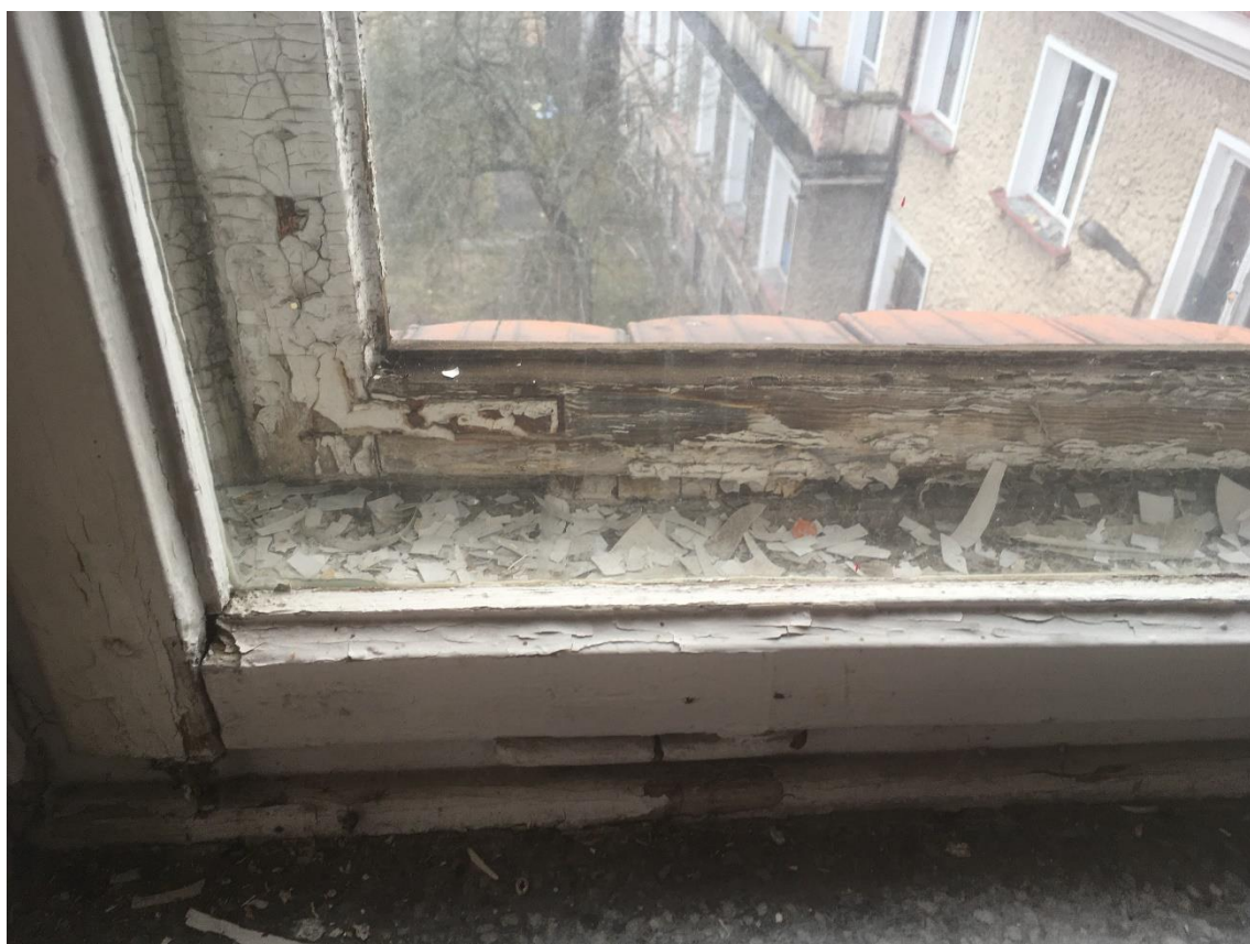
Fot. 70. Okno w wieży, trzecia kondygnacja, stan zachowania ramiaków
