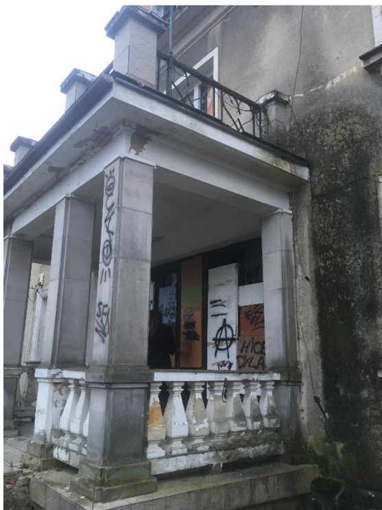
Fot. 13 i 14. Ganek wejściowy, stan zachowania, wtórna nawierzchnia z płytek ceramicznych.
