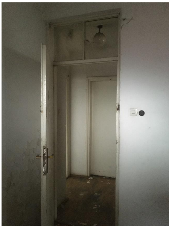
Fot. 71 i 72. Drzwi w budynku II, widoczne nadświetla, po prawej stronie- zamalowane.
