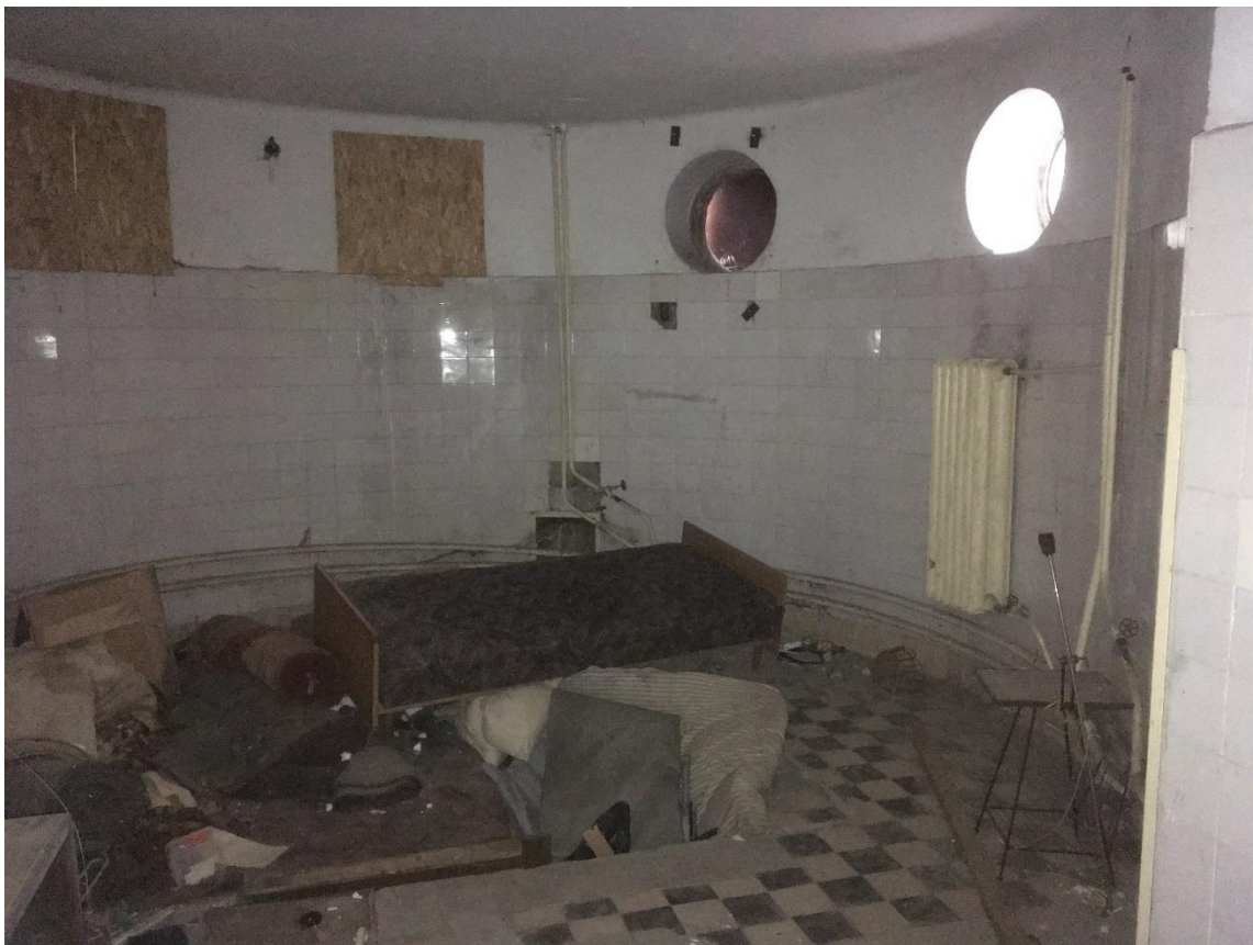
Fot. 58. Wieża, kondygnacja pierwsza, pomieszczenie z posadzką z płytek, wyłożone glazurą. W górnej części pomieszczenia widoczne otwory wentylacyjne.
