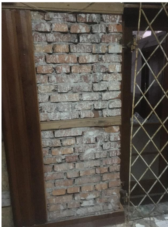
Fot. 55. Budynek I, hol wejściowy, odsłonięty mur oryginalny.
