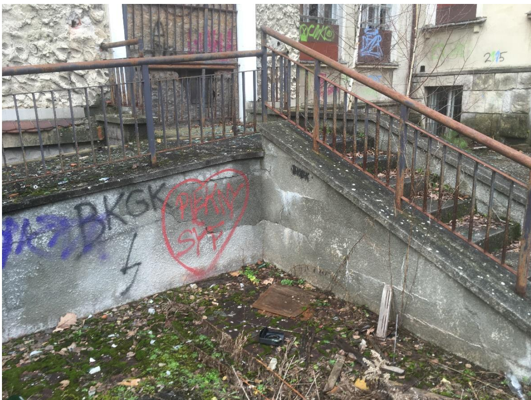
Fot. 29. Strona wschodnia, budynek II, schody i podjazd, konstrukcja częściowo wtórna, szczelnie pokryta wtórnymi warstwami zaprawy cementowej.
