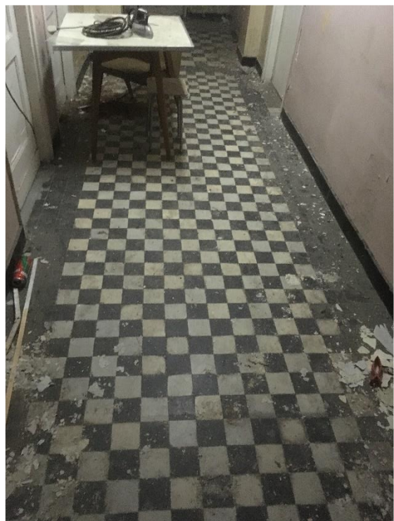
Fot. 56 i 57. Budynek I, posadzka pierwszej kondygnacji. Po prawej widoczne uzupełnienie mniejszymi płytkami.
