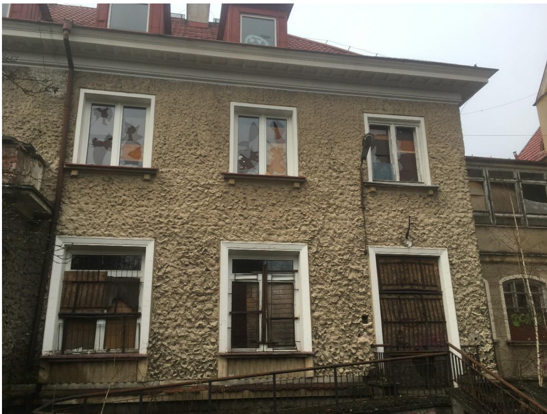
Fot. 30. Budynek II, strona wschodnia, widoczna różnica w opracowaniu opasek okiennych drugiej i trzeciej kondygnacji.
