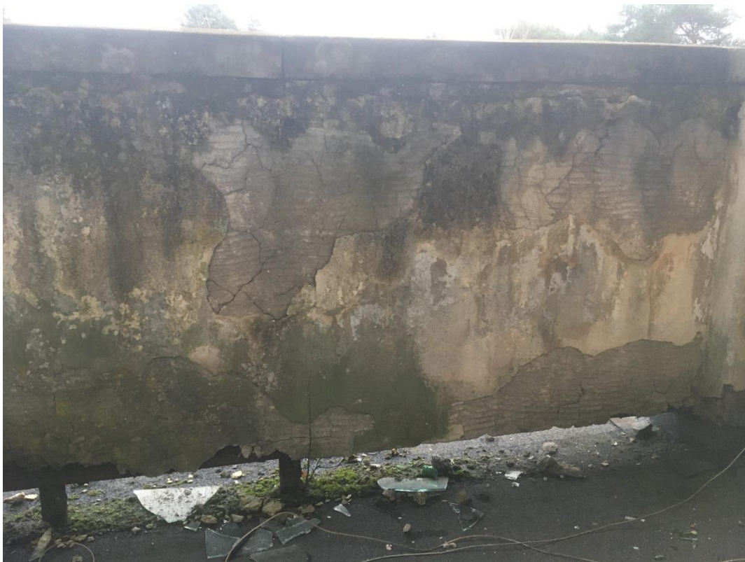
Fot. 48. Balustrada, elewacja wschodnia, budynek II. Rozległe zawilgocenie, warstwy wtórne, nawarstwienia mikroorganizmów. Widoczne ubytki i degradacja powierzchni.
