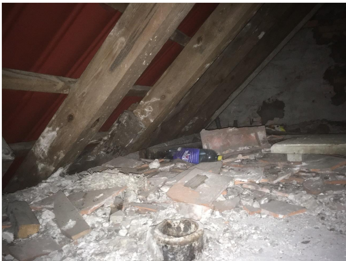
Fot. 101. Więźba dachowa, krokwie, widoczne zabrudzenia, stan zachowania dobry.
