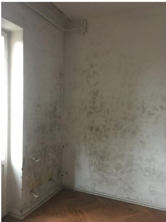
Fot. 84 i 85. Budynek II, stan zachowania ścian w pomieszczeniach.
