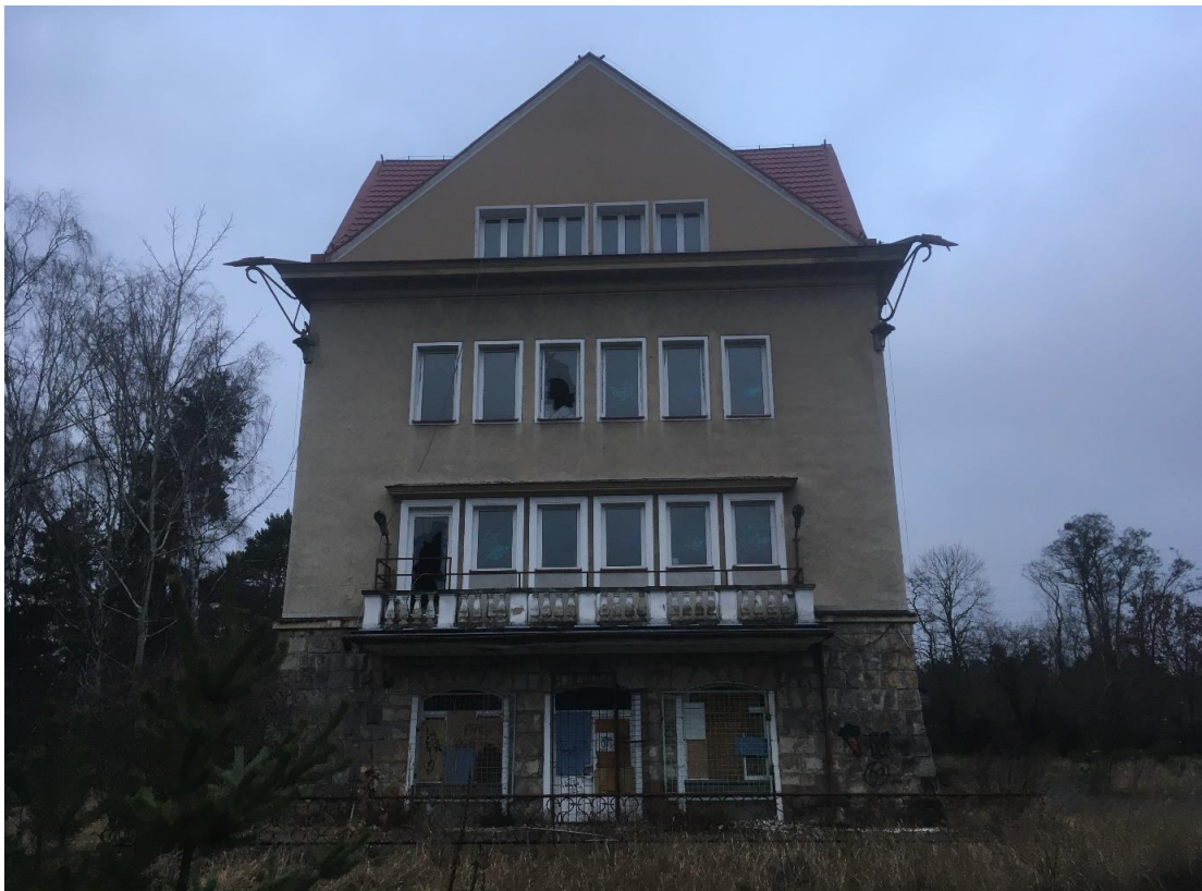
Fot. 5. Strona południowa, kondygnacja parterowa pokryta okładziną kamienną i balkon na pierwszym piętrze. Narożniki z dekoracyjnymi elementami metalowymi.
