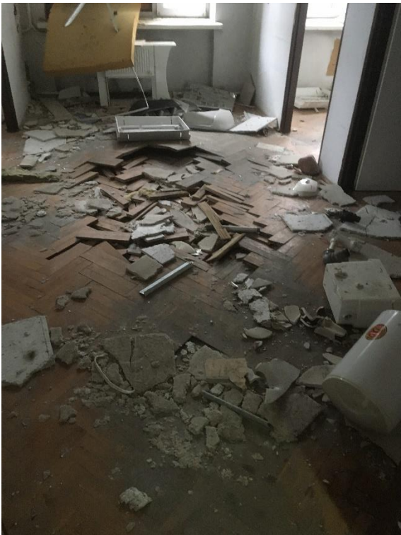
Fot. 97 i 98. Budynek II, parkiety, widoczne uszkodzenia i deformacje.
