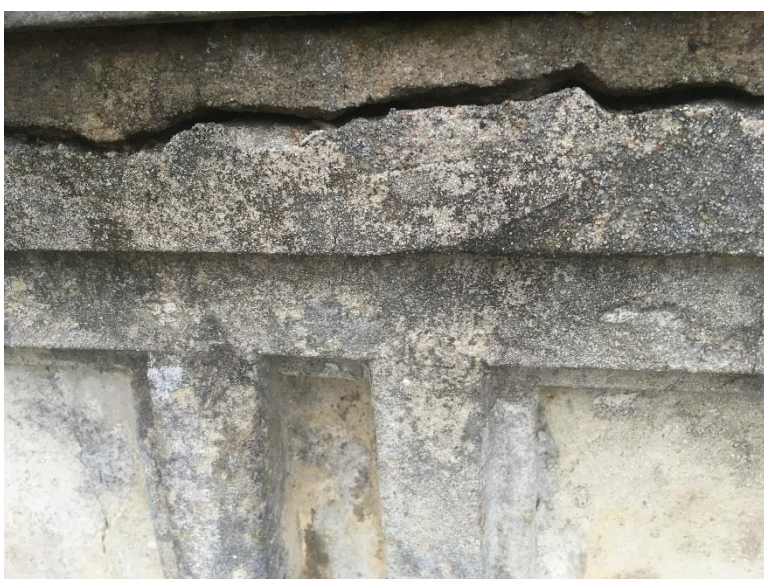
Fot. 47. Detal balustrady wykonany w zaprawie. Widoczne pęknięcie i zabrudzenia powierzchni.
