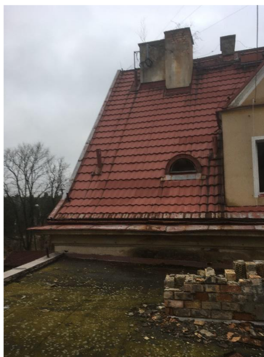
Fot. 19. Budynek I, styk dachu ze stropodachem łącznika, widoczne skutki zaciekania wody opadowej.
