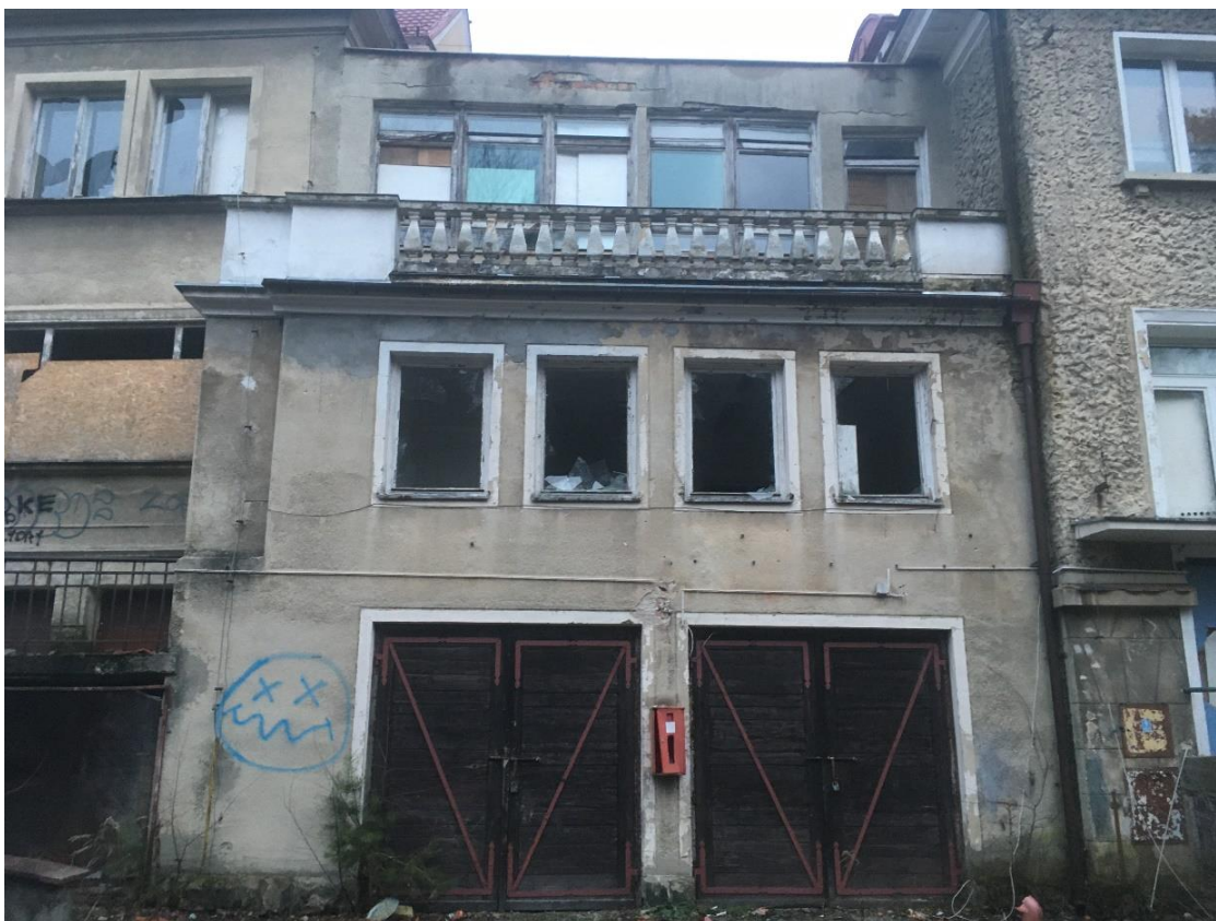
Fot. 8. Łącznik, strona zachodnia, widoczny taras ponad druga kondygnacją, kondygnacja trzecia wtórna, cofnięta w celu zrównania z licem budynku I.
