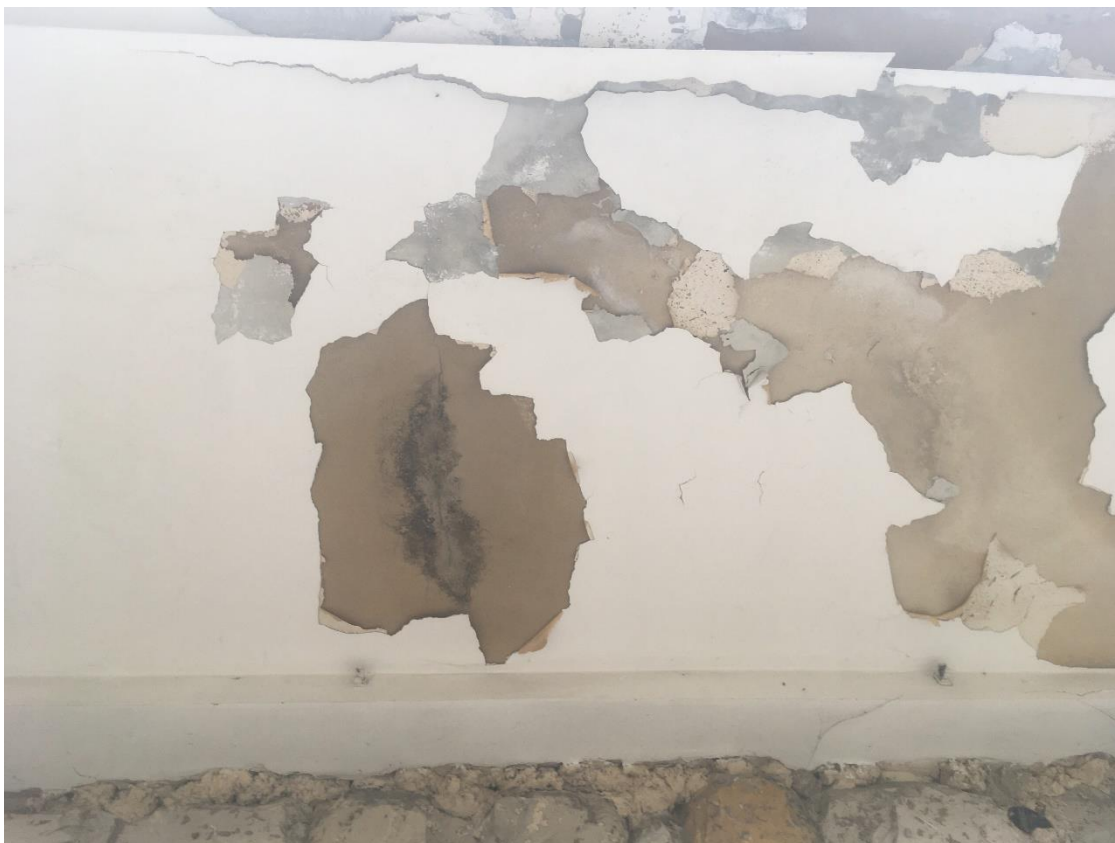
Fot. 45. Płyta balkonu, detal. Widoczne warstwy cementowe, które uszczelniając powierzchnię przyczyniły się do degradacji płyty balkonu.
