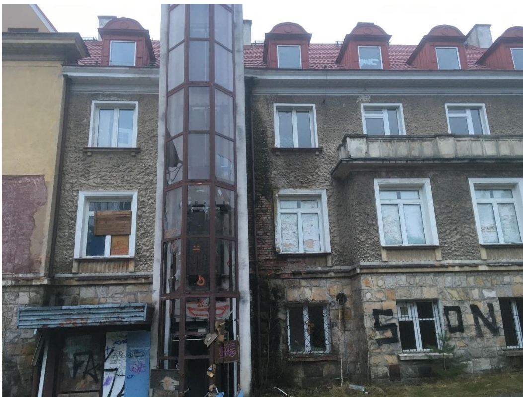
Fot. 51. Budynek II, część centralna, pierwsza kondygnacja wykończona okładzina kamienną.
