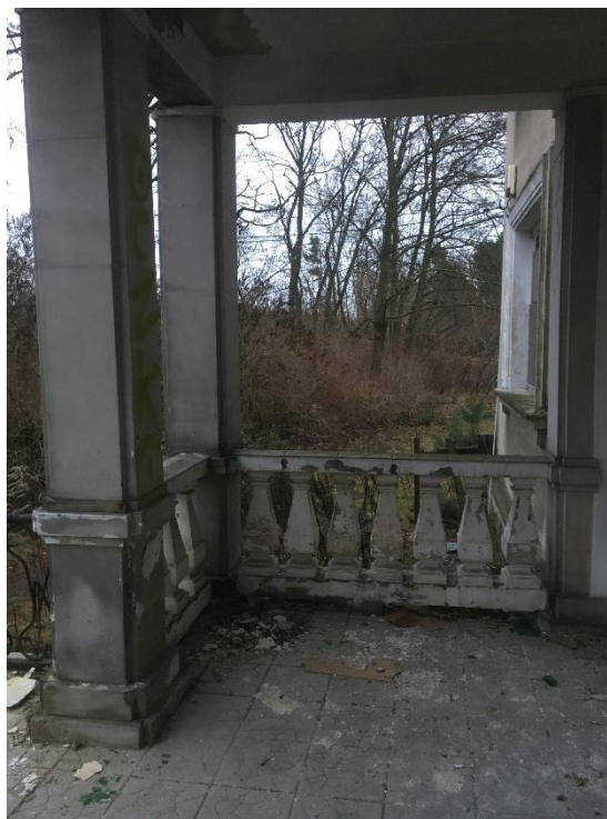
Fot. 13 i 14. Ganek wejściowy, stan zachowania, wtórna nawierzchnia z płytek ceramicznych.
