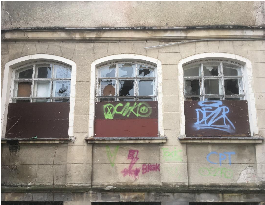
Fot. 23. Łącznik, strona wschodnia, druga kondygnacja, okna zamknięte łukiem odcinkowym, podwójne, z prostą opaską. W tynku wykonano imitację boniowania.
