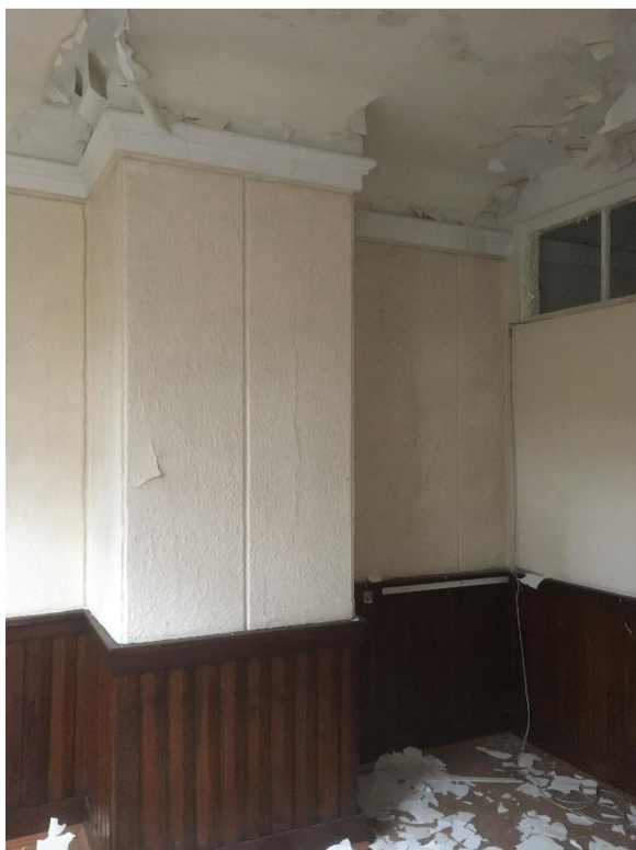
Fot. 77 i 78. Budynek II, wnętrza z dekoracją sztukatorską- widoczny stan zachowania. Boazeria i glazura są wtórne.
