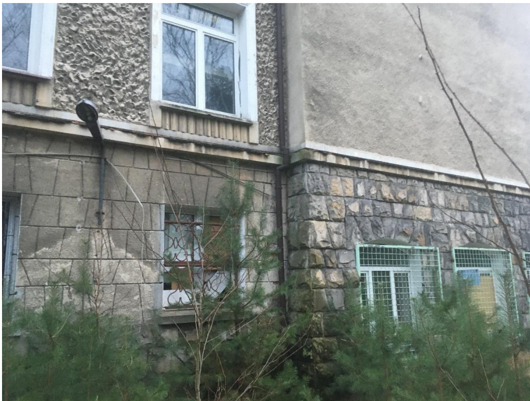
Fot. 50. Styk części południowej z centralną, budynek II. Kondygnacja I w partii centralnej rozwiązana analogicznie do łącznika- imitacja okładziny kamiennej w tynku.
