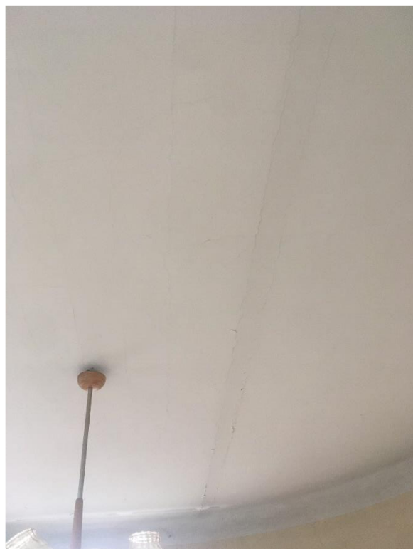
Fot. 86 i 87. Wieża, kondygnacja druga, widoczne spękania na suficie, prawdopodobnie powtarzające przebieg belek stropowych ( być może skorodowanych).
