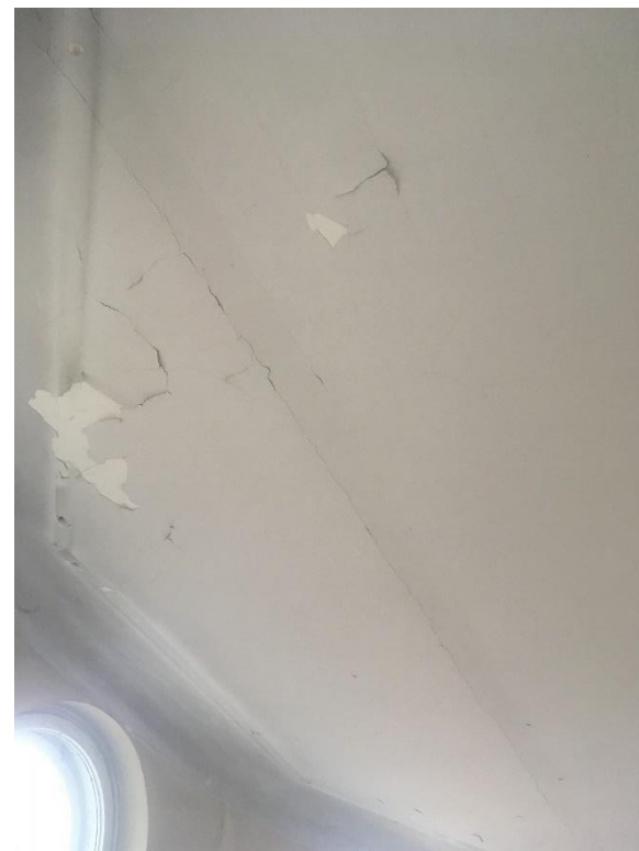
Fot. 86 i 87. Wieża, kondygnacja druga, widoczne spękania na suficie, prawdopodobnie powtarzające przebieg belek stropowych ( być może skorodowanych).
