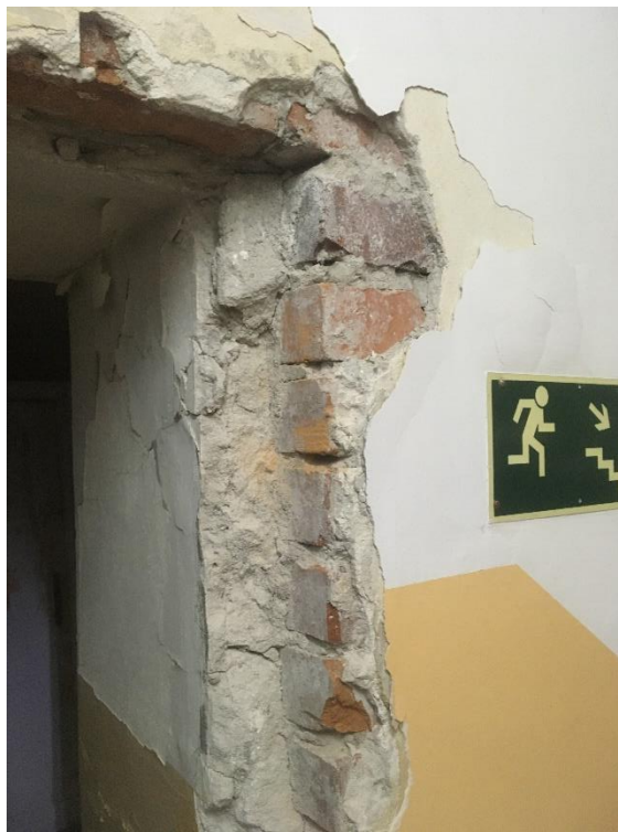
Fot. 90. Budynek I, kondygnacja druga, odsłonięty mur oryginalny, widoczny dobry stan zachowania.
