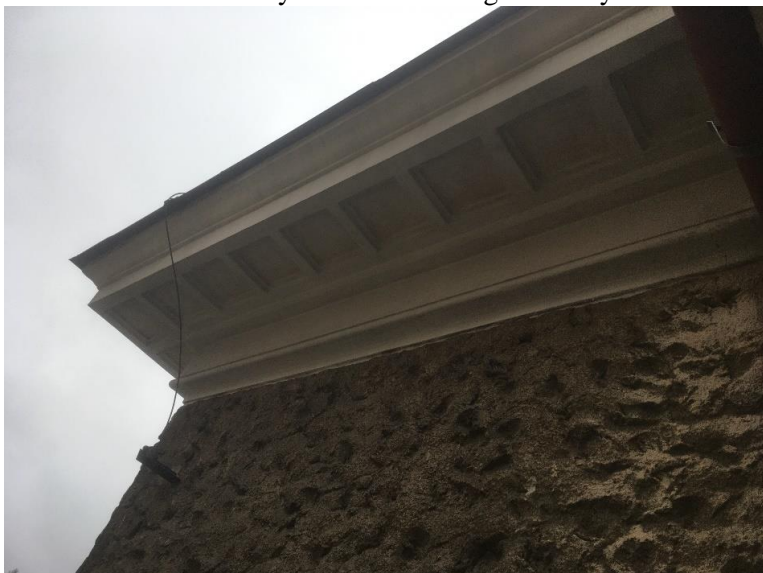
Fot. 36. Okap dachu budynku II, dekoracyjne kasetony i gzyms.
