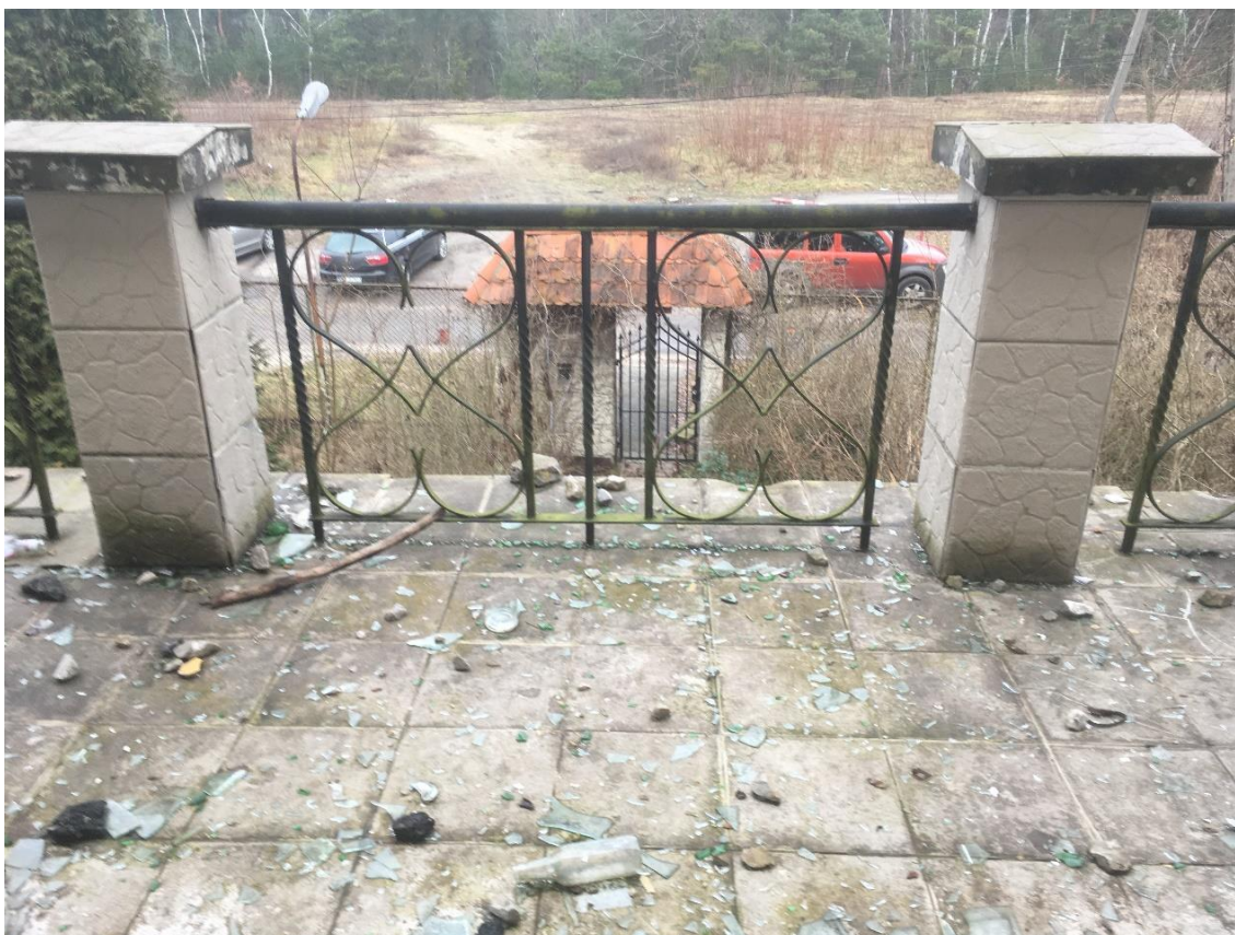
Fot. 15. Taras nad gankiem wejściowym, nawierzchnia z płytek ceramicznych i oryginalna balustrada, wtórnie obłożona tymi samymi płytkami.
