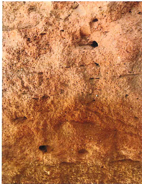
Fot. 70-72 Otwory wylotowe owadów żerujących w cegle i spoinach.
