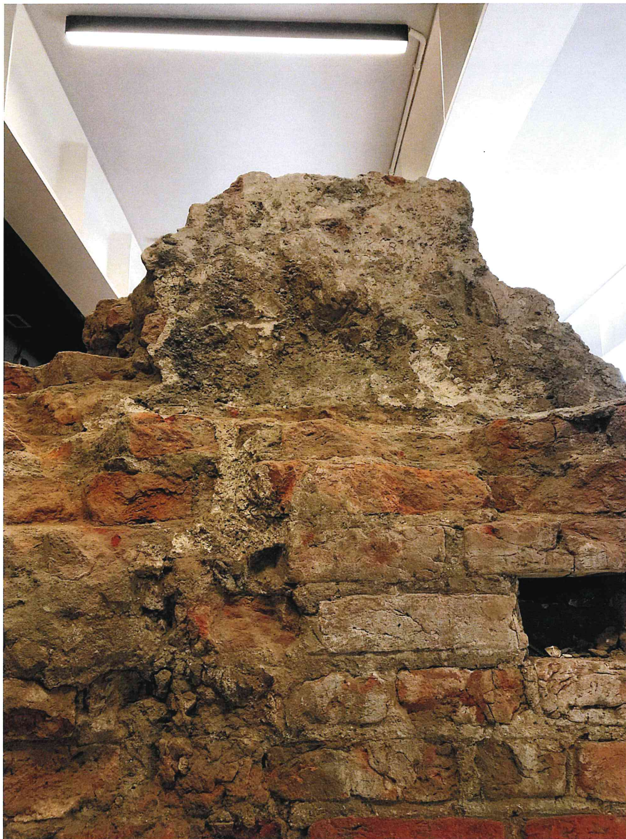
Fot. 100 Narożnik EW, z fragmentem zalania oryginalną zaprawą wapienną do wnętrza muru.
