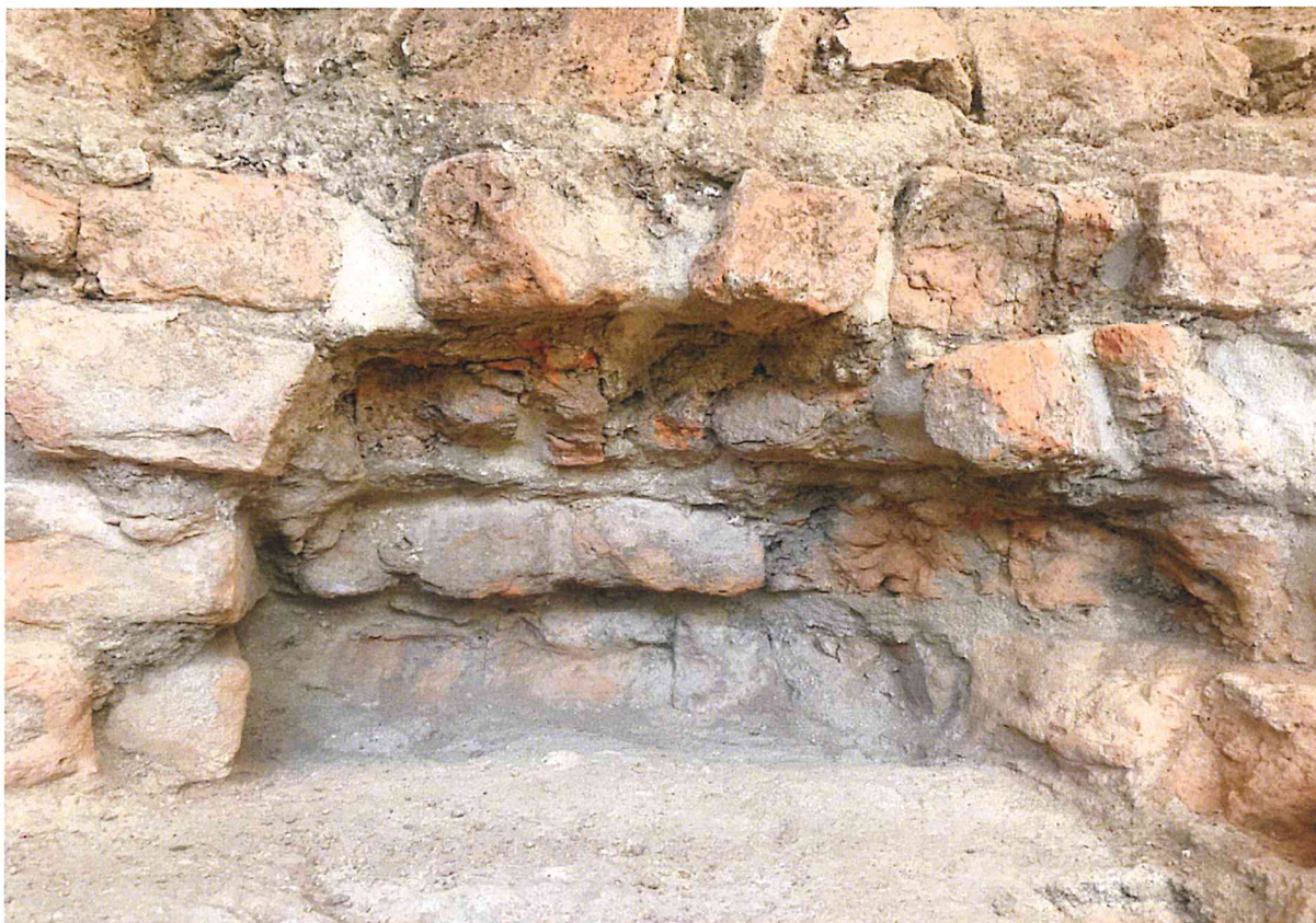
Fot. 64 i 65 Zagłębienie z licu ściany BC z widocznymi liszajami.
