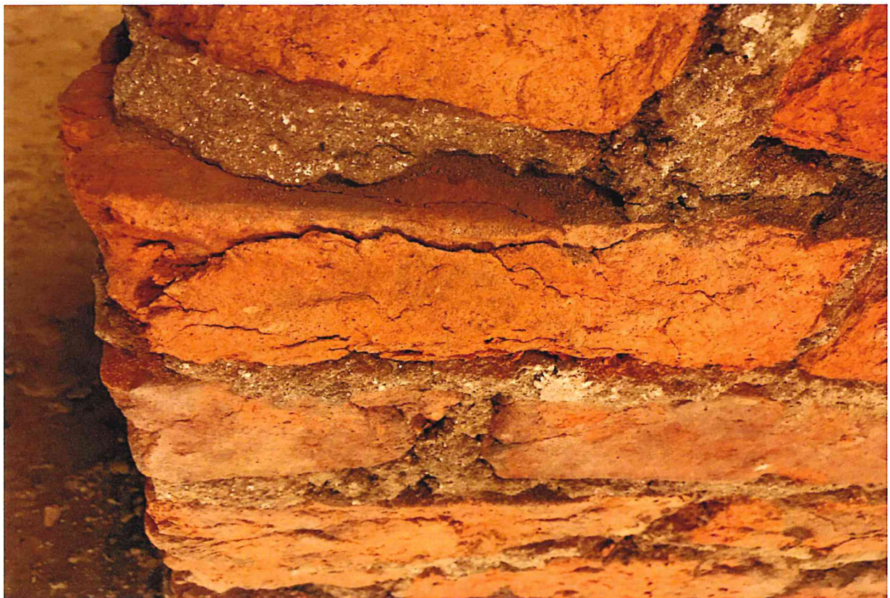
Fot. 98 i 99 spękania i złączania cegieł na skarpach.
