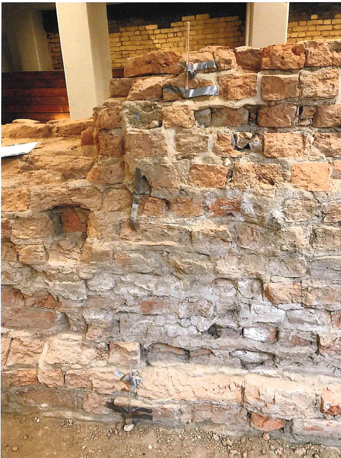
Fot. 101 Fragment muru AD od wewnątrz, wypadania cegieł pomimo podmurowania kilku z nich zaprawą podtrzymującą.
