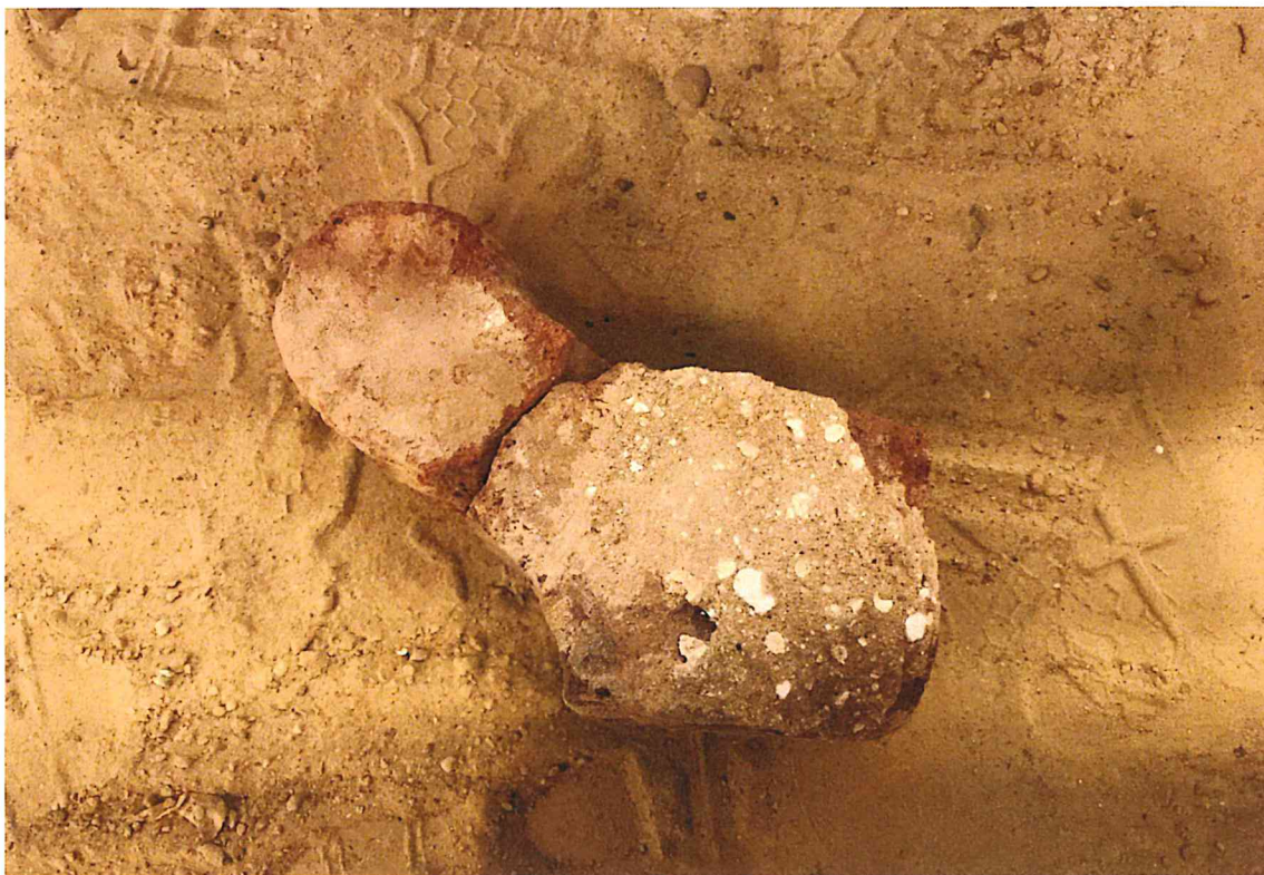
Fot. 87 Pozostałości po prawdopodobnie profilowanych ościeżach drzwiowych, zbyt małe przekroje na żebra sklepienne.
