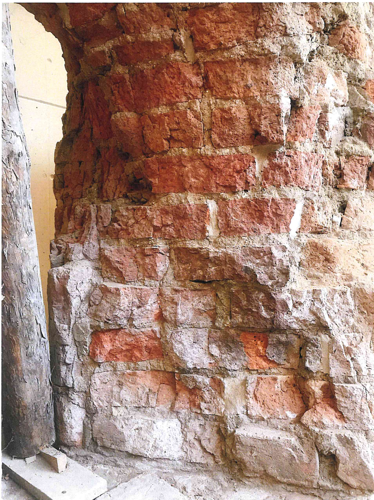
Fot. 63 Złuszczenia warstw cegieł.
