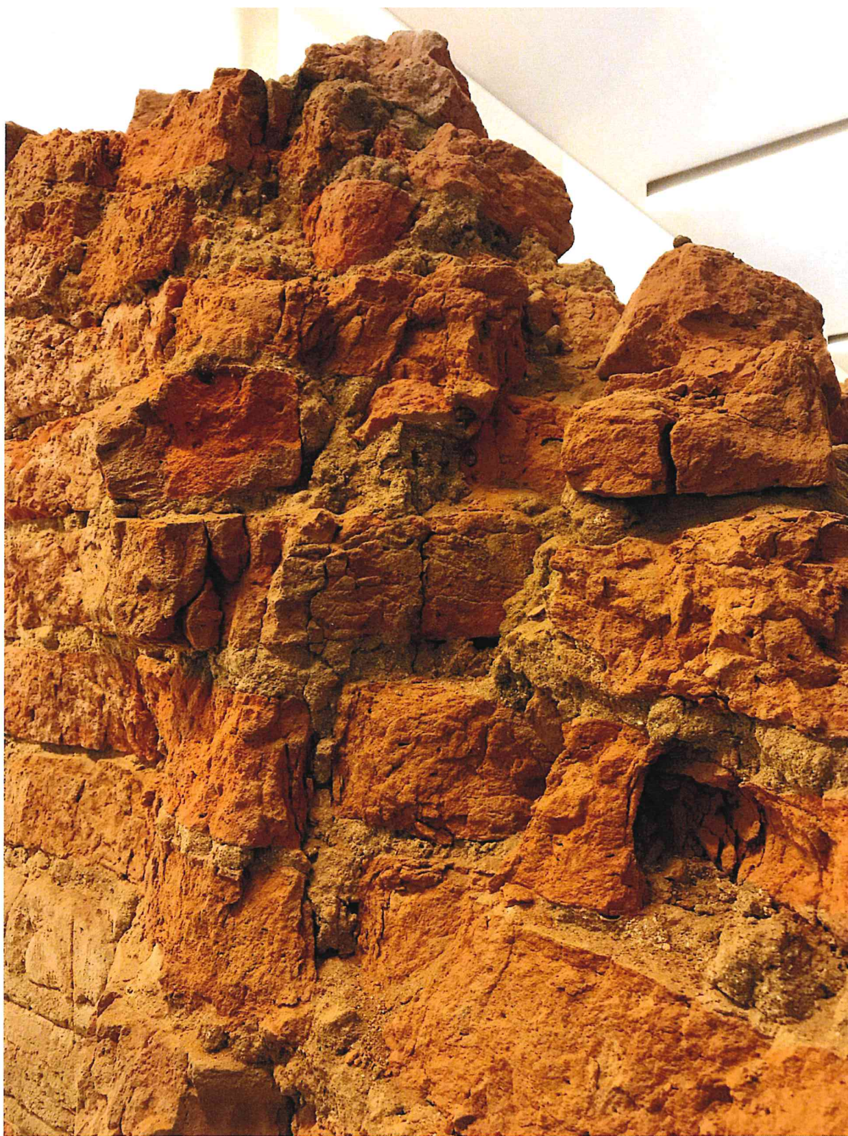
Fot. 97 Spękania pionowe w murze w górnej partii.
