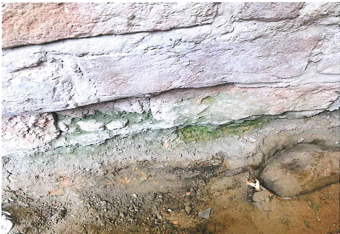
Fot. 90 Mikroorganizmy w dolnej partii muru tuż przy wejściu, od strony wewn. muru.
