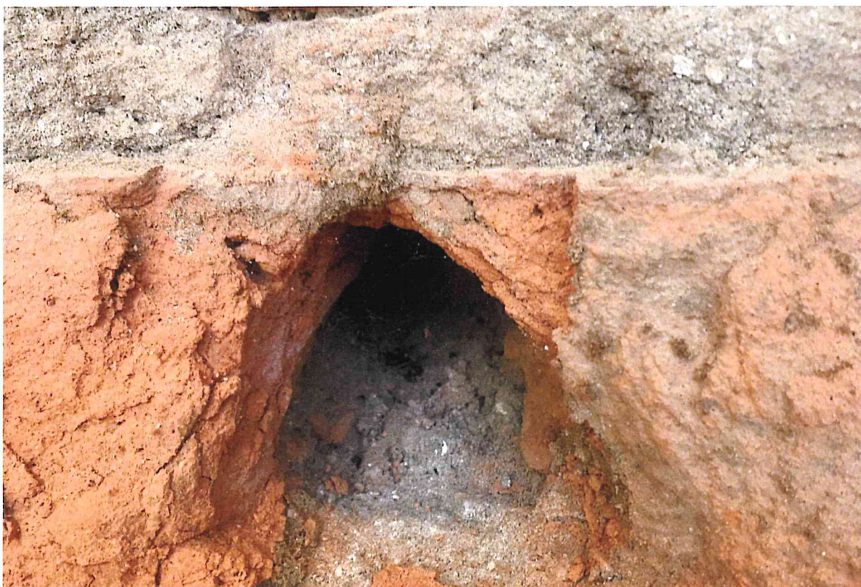
Fot. 66 i 67 Zagłębienie w licu ściany AD z widocznymi mikroorganizmami.
