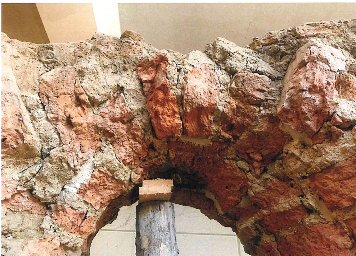
Fot. 61 Zwieńczenie spękanego nadłucza okna na ścianie BC.
