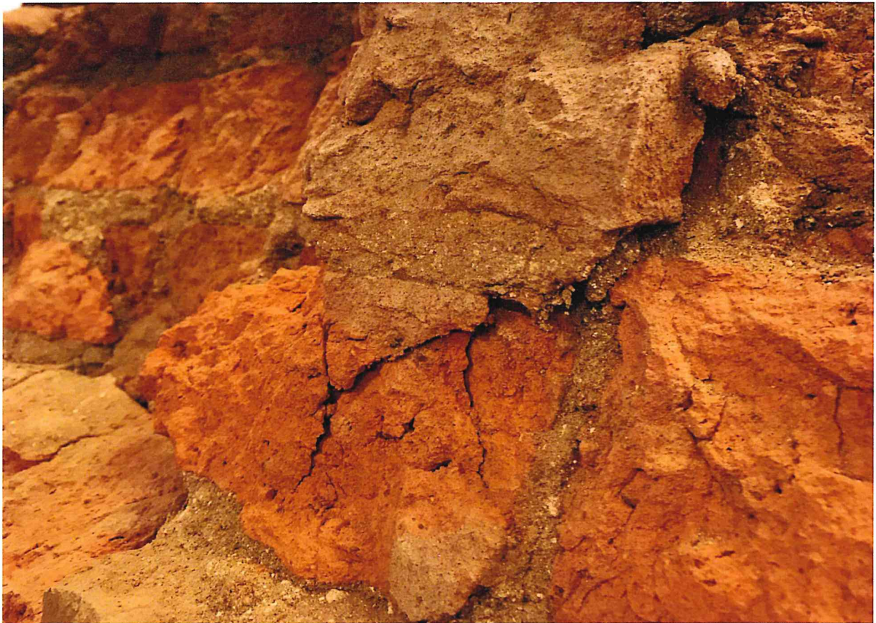
Fot. 98 i 99 spękania i złączania cegieł na skarpach.
