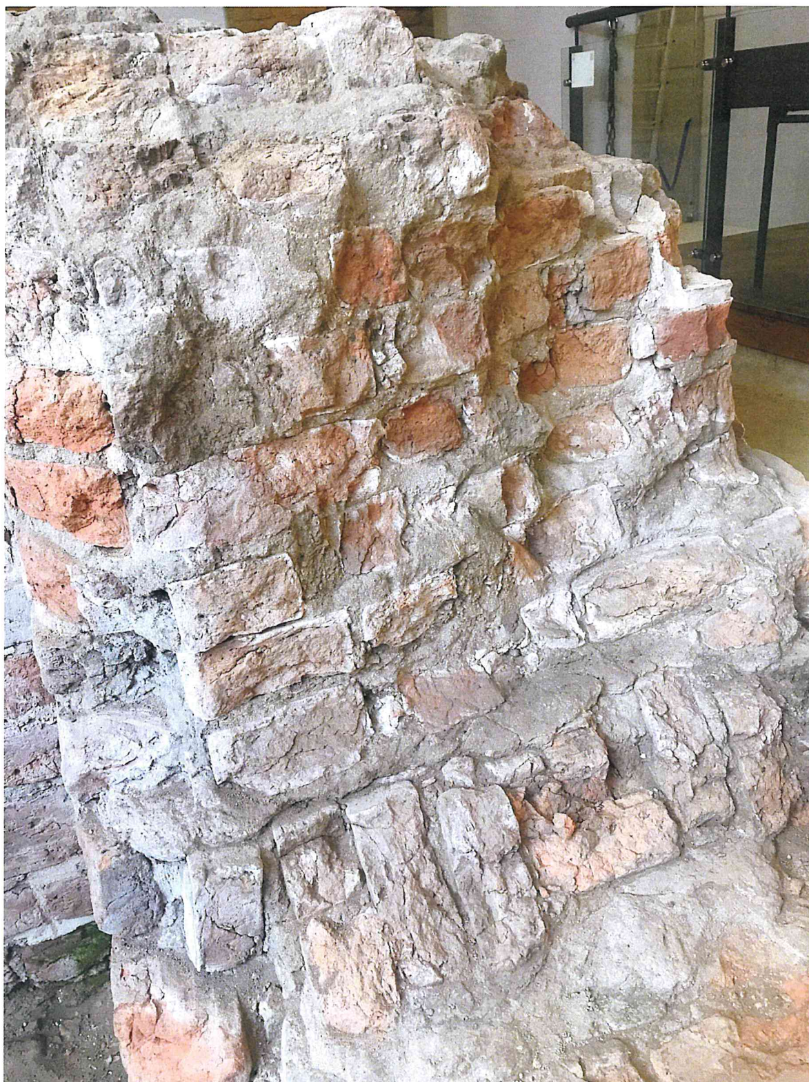
Fot. 83 Lekkie zasolenia i zabielenia krawędzi.
