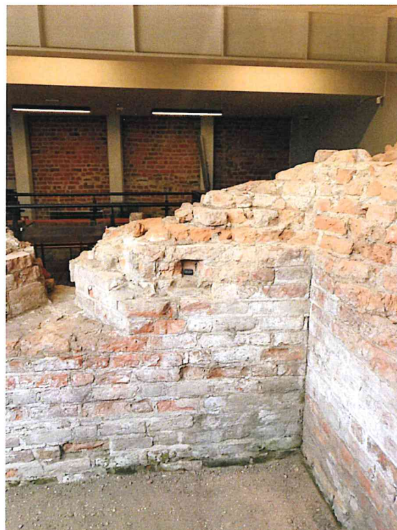
Fot. 76-79 (nr 1, 2,3,4), stanowiska pomiaru wilgotności i temperatury, na zewn. muru i wewnątrz ( w zagłębieniu otworów szachulcowych).
