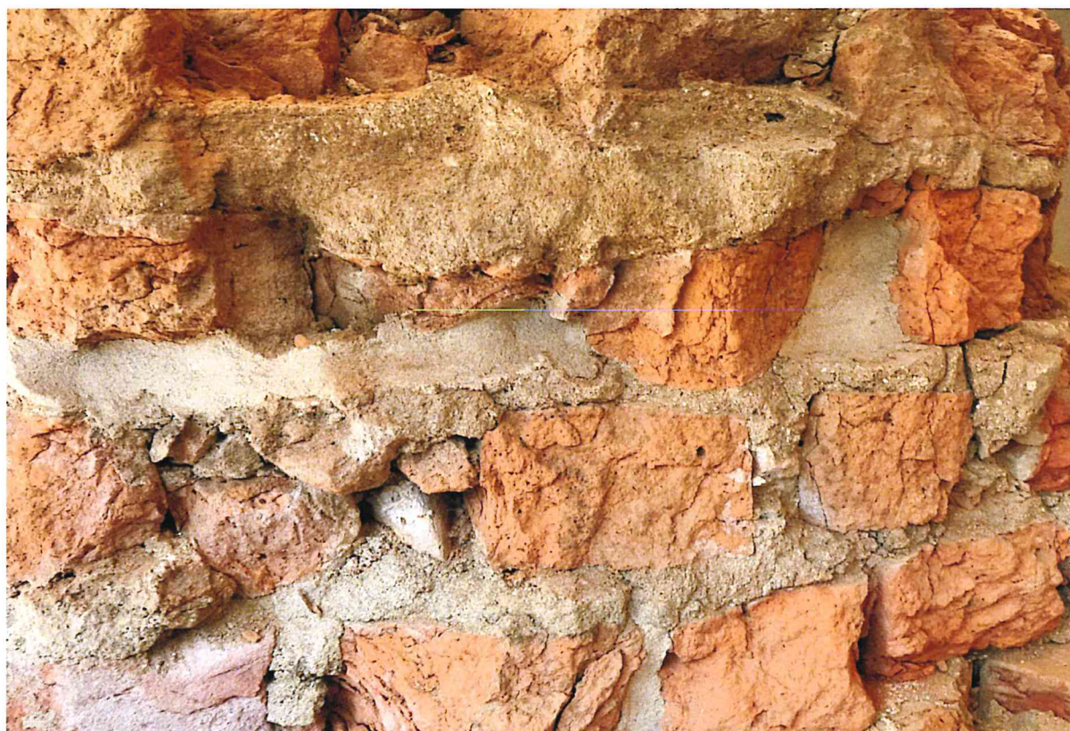
Fot. 95 i 96 Poprzednie zabiegi poklejenia zaprawą cegieł.
