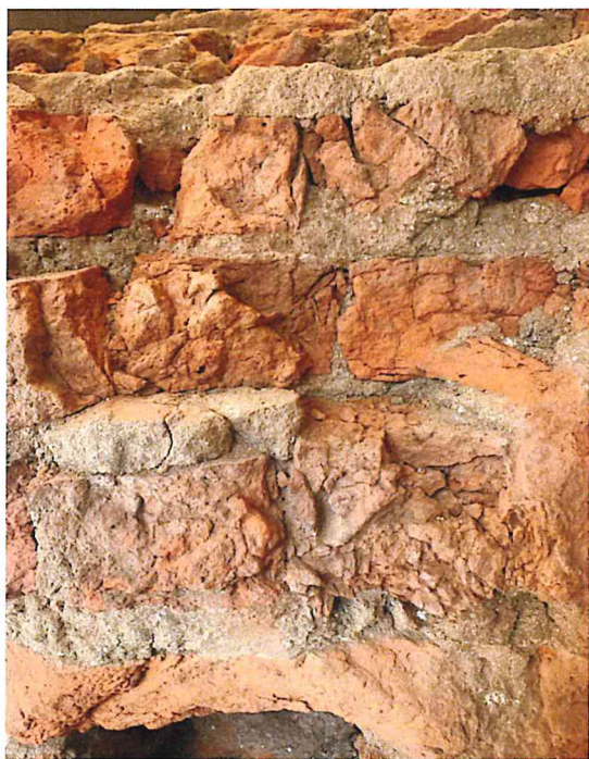
Fot. 70-72 Otwory wylotowe owadów żerujących w cegle i spoinach.
