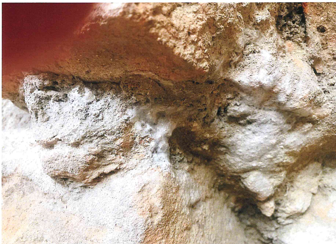
Fot. 64 i 65 Zagłębienie z licu ściany BC z widocznymi liszajami.
