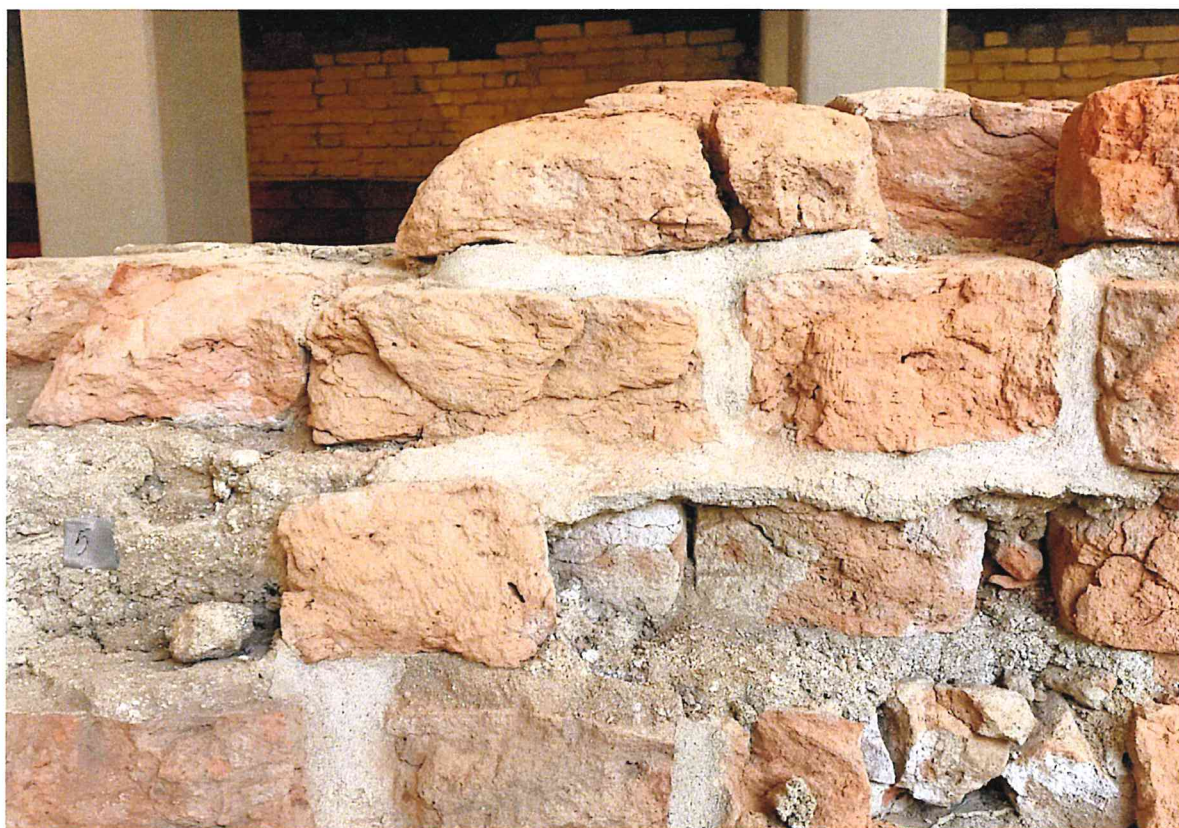
Fot. 95 i 96 Poprzednie zabiegi poklejenia zaprawą cegieł.
