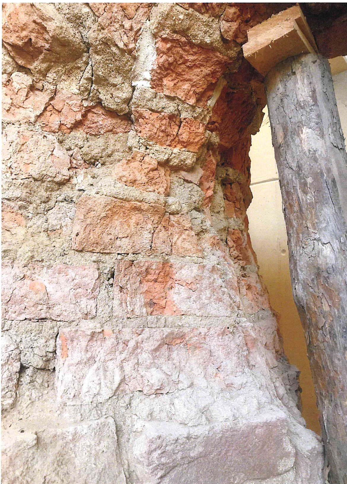
Fot. 62 Złuszczenia i rozwarstwienia cegieł i zaprawy nadłucza.
