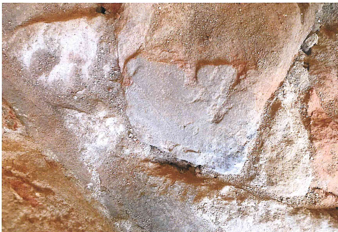
Fot. 57 Szkliwo znalezione na części cegieł.
