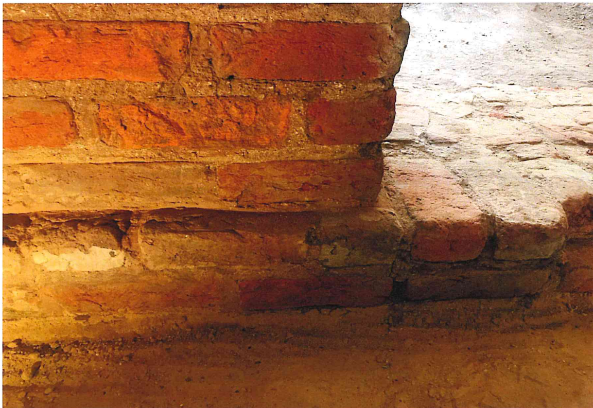
Fot. 60 W dolnych częściach przy wejściu widoczne szkliwo na licu ceglanym.
