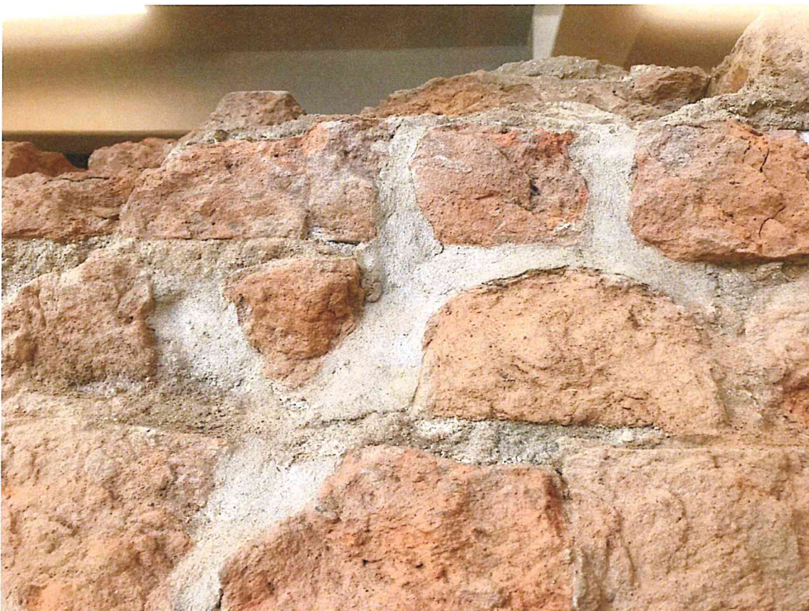
Fot. 81 Wtórne uzupełnienia spoiny podczas ostatnich prac konserwatorskich.
