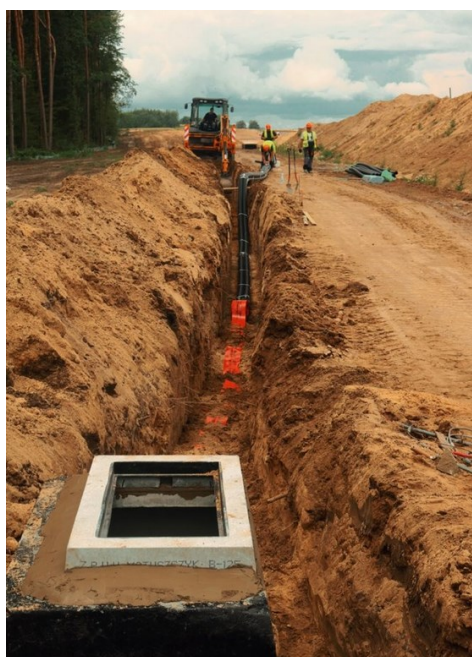
Rys. 34. Zamontowana studzienka kablowa
