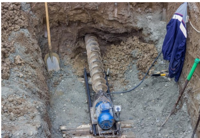
Rys. 30. Wykonywanie przewiertu
