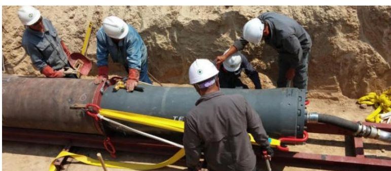
Rys. 28. Przecisk z ubijakiem umieszczonym za rurą stalową
