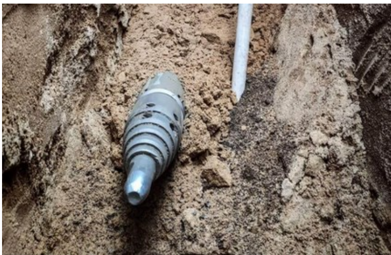
Rys. 27. Kret ciągnący rurę
