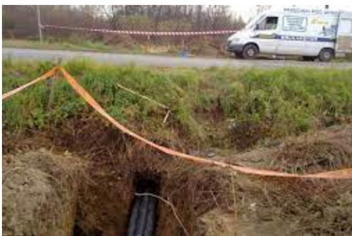
Rys. 31. Kanał kablowy umieszczony metodą przewiertu
