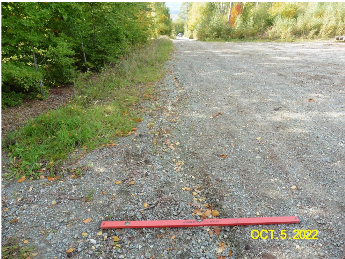
Foto 1. Widok wypłukanych wzdłużnie uszkodzeń- przy poboczu drogi
