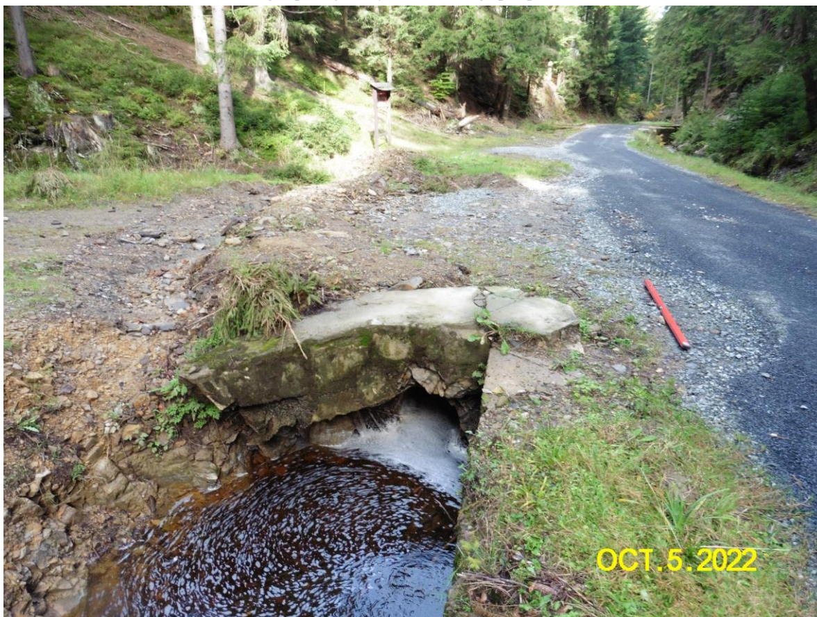
Foto 3. Uszkodzenie wlotu przepustu
