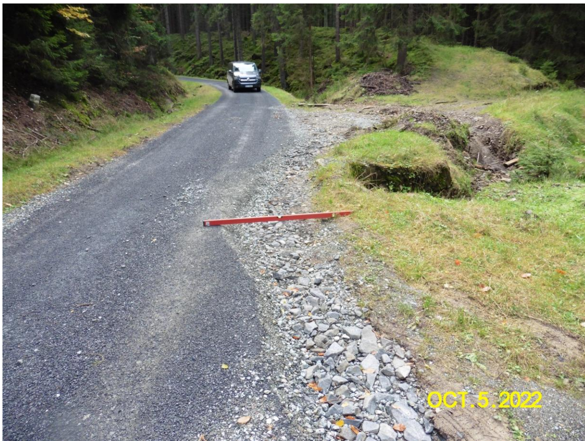
Foto 2. Uszkodzenie drogi z prawej strony i uszkodzonego przepustu
