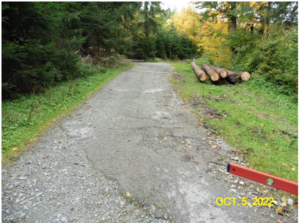
Foto 3. Uszkodzenia nawierzchni i przy poboczu, w dalszej części drogi
