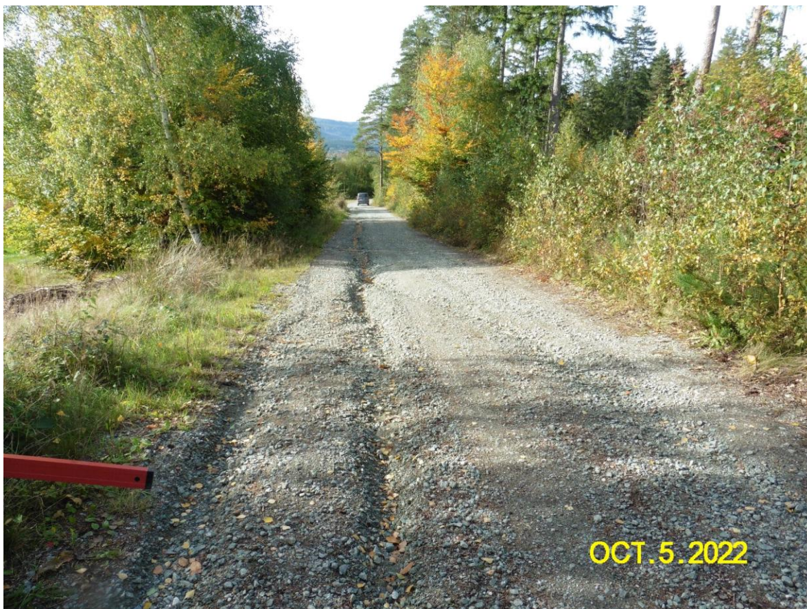
Foto 3. Widok uszkodzeń wymytych przez wody opadowe- wzdłuż drogi, w dalszej części
