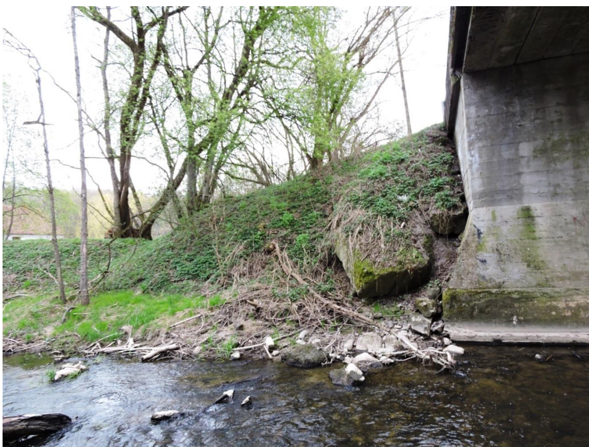
Foto.Nr.6. Widok prawobrzeżnej skarpy stożka od strony WD z fragmentami zniszczonego muru oporowego.
