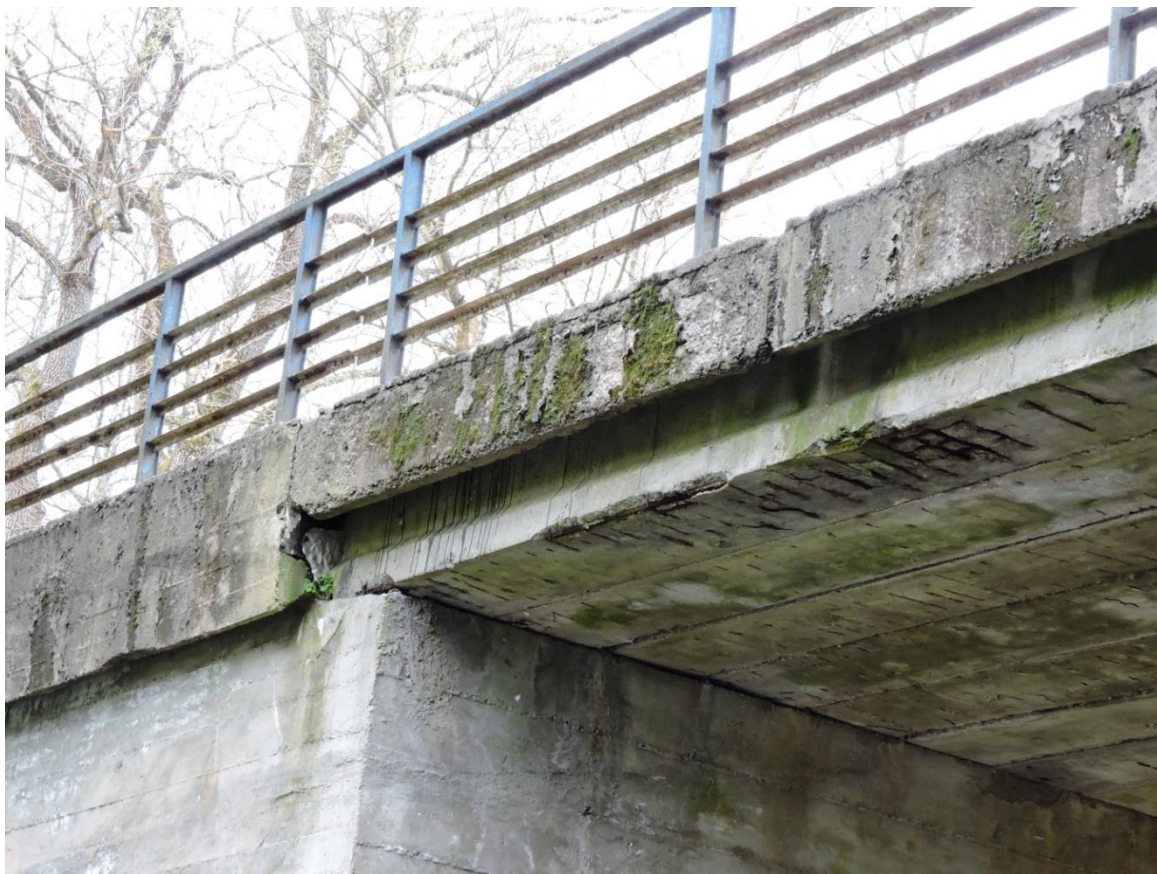
Foto.Nr.5. Widok krawędzi płyty mostu od strony WD. Ubytki betonu. Korozja zbrojenia. Wegetacja roślin (mech).
