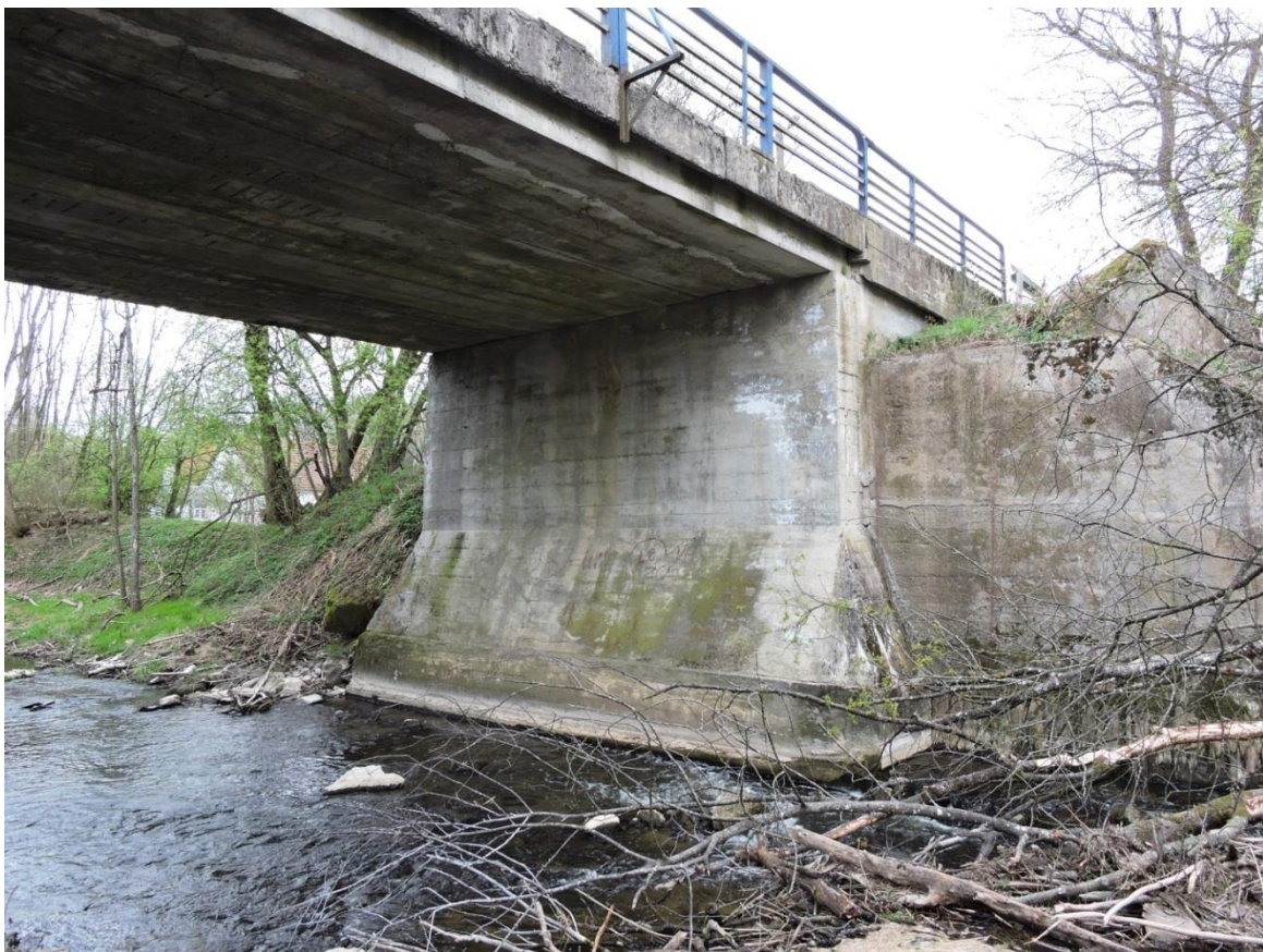
Foto.Nr.3. Widok prawobrzeżnej przyczółka z murem oporowym. Koryto rzeki zanieczyszczone naniesionym materiałem biologicznym (gałęzie i konary drzew)
