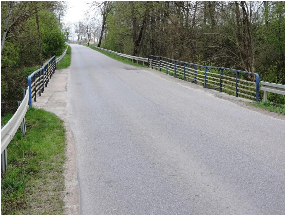
Foto. Nr.1. Widok mostu w planie drogi nr. 1394N. Deformacja liniowa i wysokościowa poręczy ochronnych.
