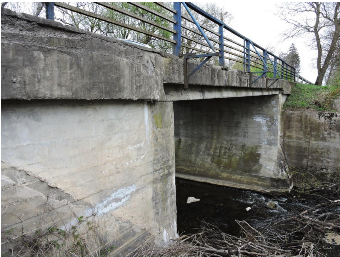
Foto.Nr.9. Widok odsłoniętego lewobrzeżnego skrzydła mostu od strony WG. Korozja i ubytki betonu w belce gzymsowej. Osady i wykwity na ścianie skrzydełka i ścianie przyczółka.
