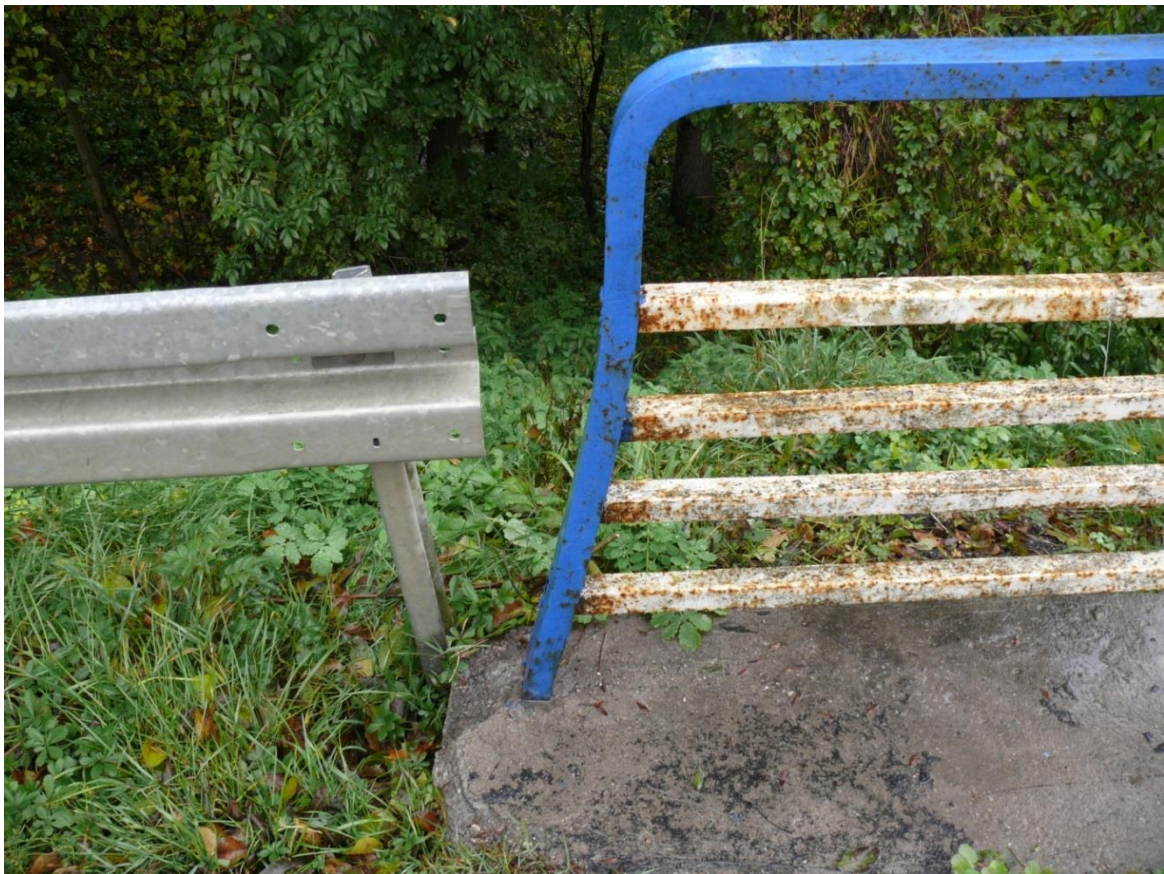
Foto.Nr.11. Deformacja poręczy i zniszczenie zabezpieczeń antykorozyjnych pochwytu i przeciągów.
