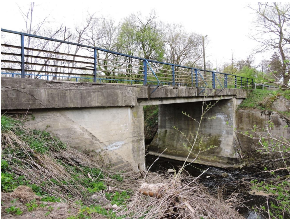
Foto.Nr.2. Widok mostu z boku od strony WG. Wegetacja roślin w tym wegetacja roślin (mech) na ścianie przyczółka.
