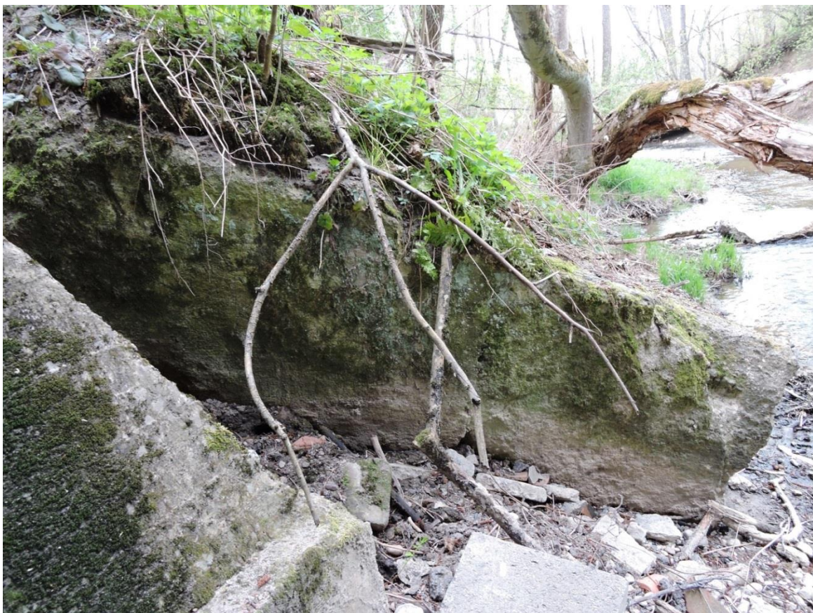
Foto.Nr.7. Widok lewobrzeżnej skarpy stożka od strony WD z fragmentami zniszczonego muru oporowego.
