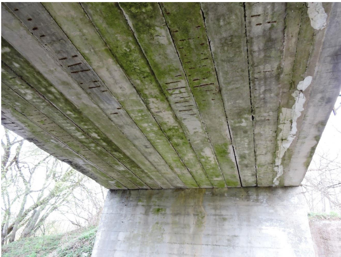
Foto.Nr.4. Widok płyty mostu od spodu o przekroju 15 belek prefabrykowanych typu „Gromnik”. Przecieki na spodzie płyty świadczące o braku skuteczności izolacji. Korozja odsłoniętego zbrojenia wegetacja roślin(mech). Osady i wykwity świadczące o nieszczelności izolacji w strefie dylatacji
