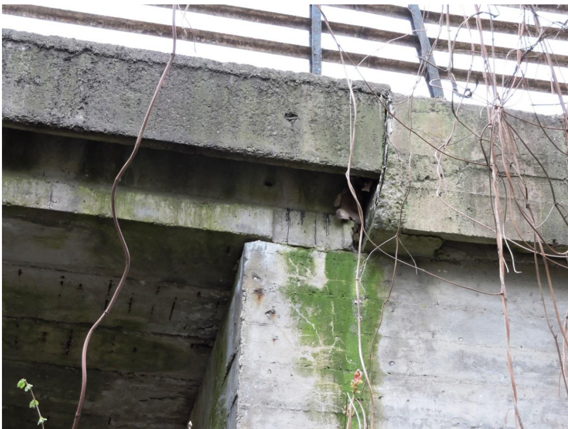
Foto.Nr.10. Korozja i ubytki betonu w spodzie płyty mostu. Wegetacja roślin (mech) na ścianie skrzydełka. Widok skrzydełka lewobrzeżnego od strony WD.
