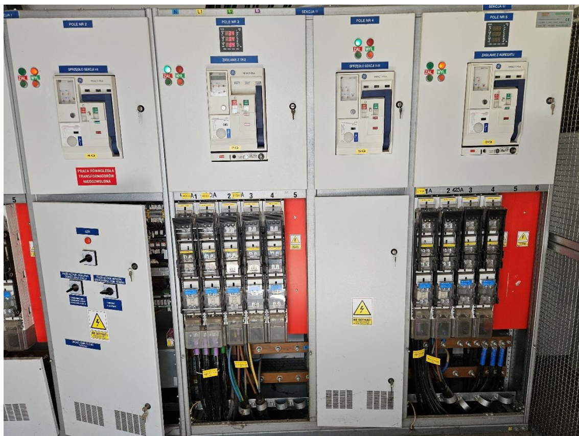
Zdj. nr 2 widok na panel z awarią zasilania automatycznego załączania zasilania awaryjnego z agregatu
