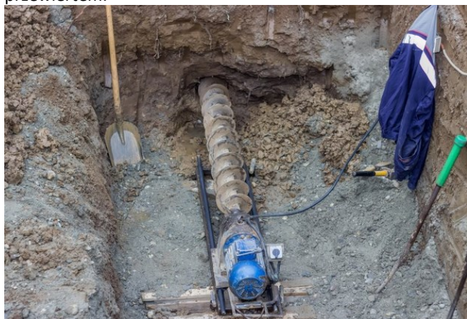
Rys. 30. Wykonywanie przewiertu
