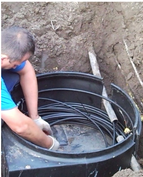
Rys. 37. Końce przeciętej rury osłonowej zostały wprowadzone do zasobnika. Na dnie zasobnika ułożono zwinięty zapas kabla
