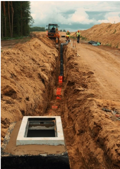
Rys. 34. Zamontowana studzienka kablowa
