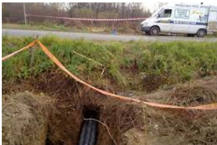
Rys. 31. Kanał kablowy umieszczony metodą przewiertu
