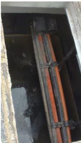
Rys. 34. Zamontowana studzienka kablowa
