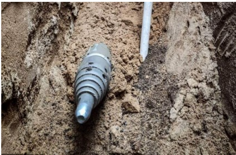
Rys. 27. Kret ciągnący rurę
