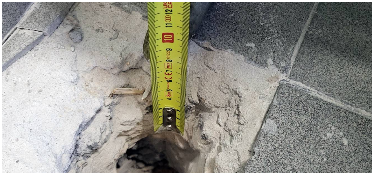
Fot.8. Odkrywka nr 2 – w stropie projektowanej Sali Hybrydowej – grubość warstwy nadbetonu
