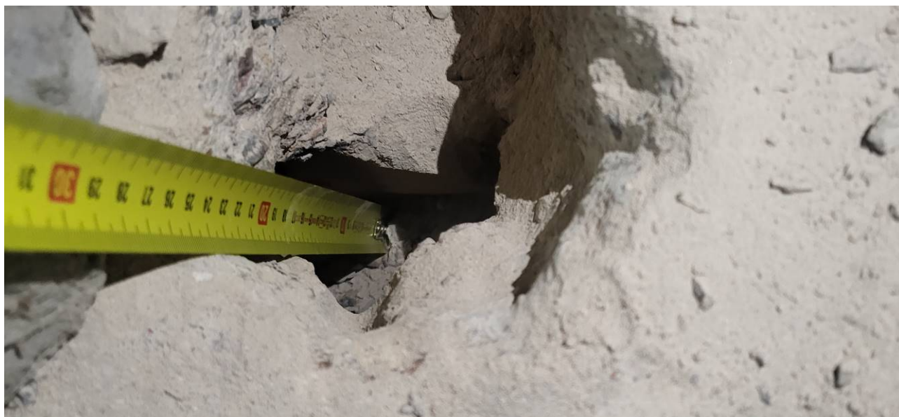
Fot.4. Odkrywa nr 1 – w stropie projektowanej Sali Hybrydowej – grubość stropu
