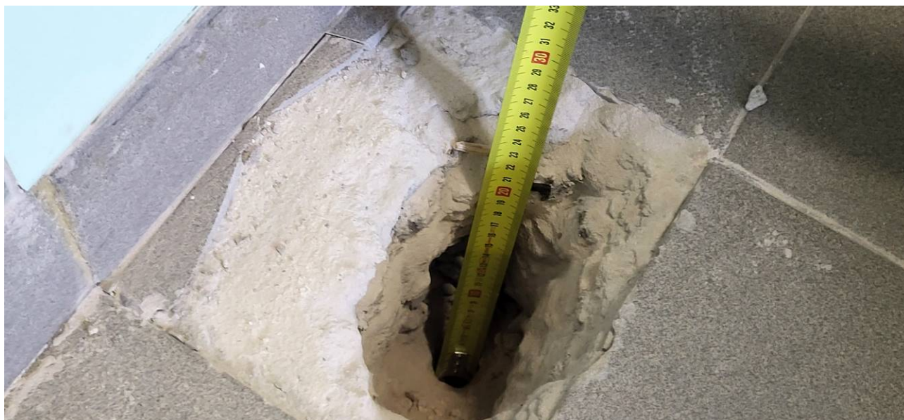
Fot.7. Odkrywka nr 2 – w stropie projektowanej Sali Hybrydowej – grubość stropu
