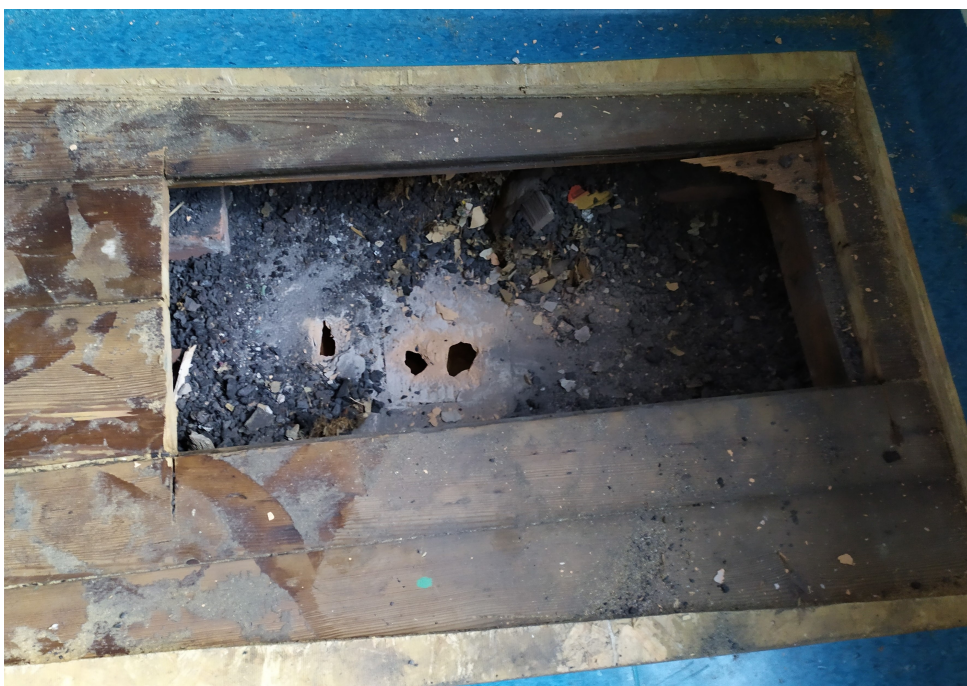
Zdjęcie nr 4. Posadzka w pomieszczeniu I piętra (podłoga nad parterem) – stan istniejący – odkrywka.
