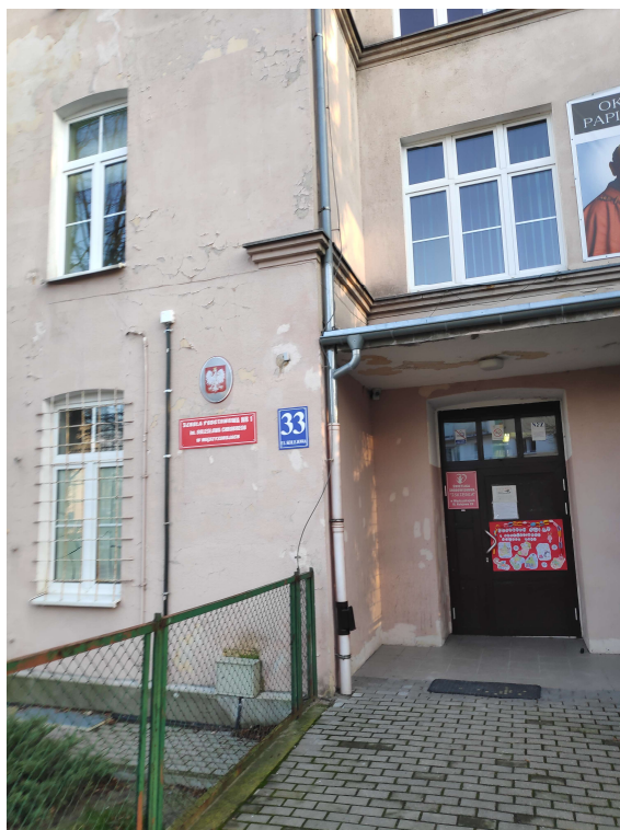
Zdjęcie nr 2. Stan tynków na ścianach zewnętrznych – zawilgocenia i zarysowania, złuszczenia na znacznej powierzchni ściany. Widoczna korozja biologiczna.
