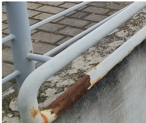
Rdzewiejące powierzchnie balustrad.
