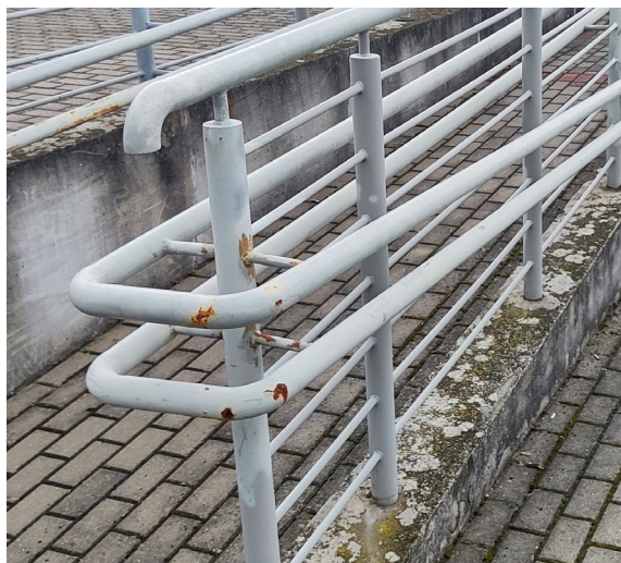
Rdzewiejące powierzchnie balustrad.
