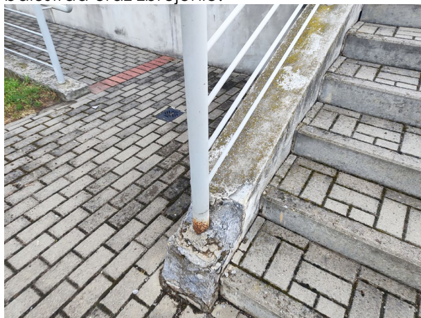
Złuszczenia oraz ubytki w betonie, odstaniające słupki w murze oraz zbrojenie.
