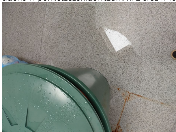
Woda stojąca w pomieszczeniu szatni nr 2.
