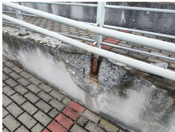
Złuszczenia oraz ubytki w betonie, odstaniające słupki w murze oraz zbrojenie.
