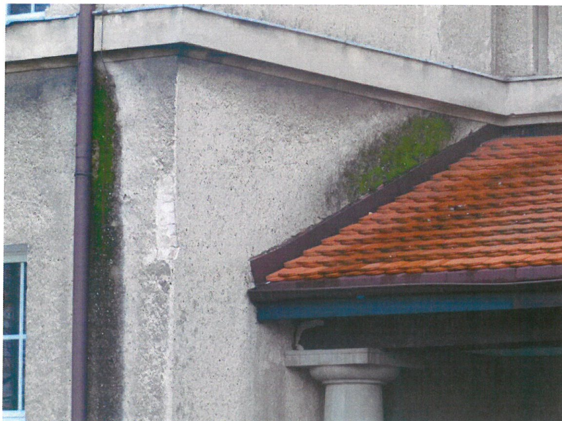
Fot. 4. Zadaszenie nad wejściem, Widoczna korozja biologiczna przy opierzeniach i wzdłuż rury spustowej
