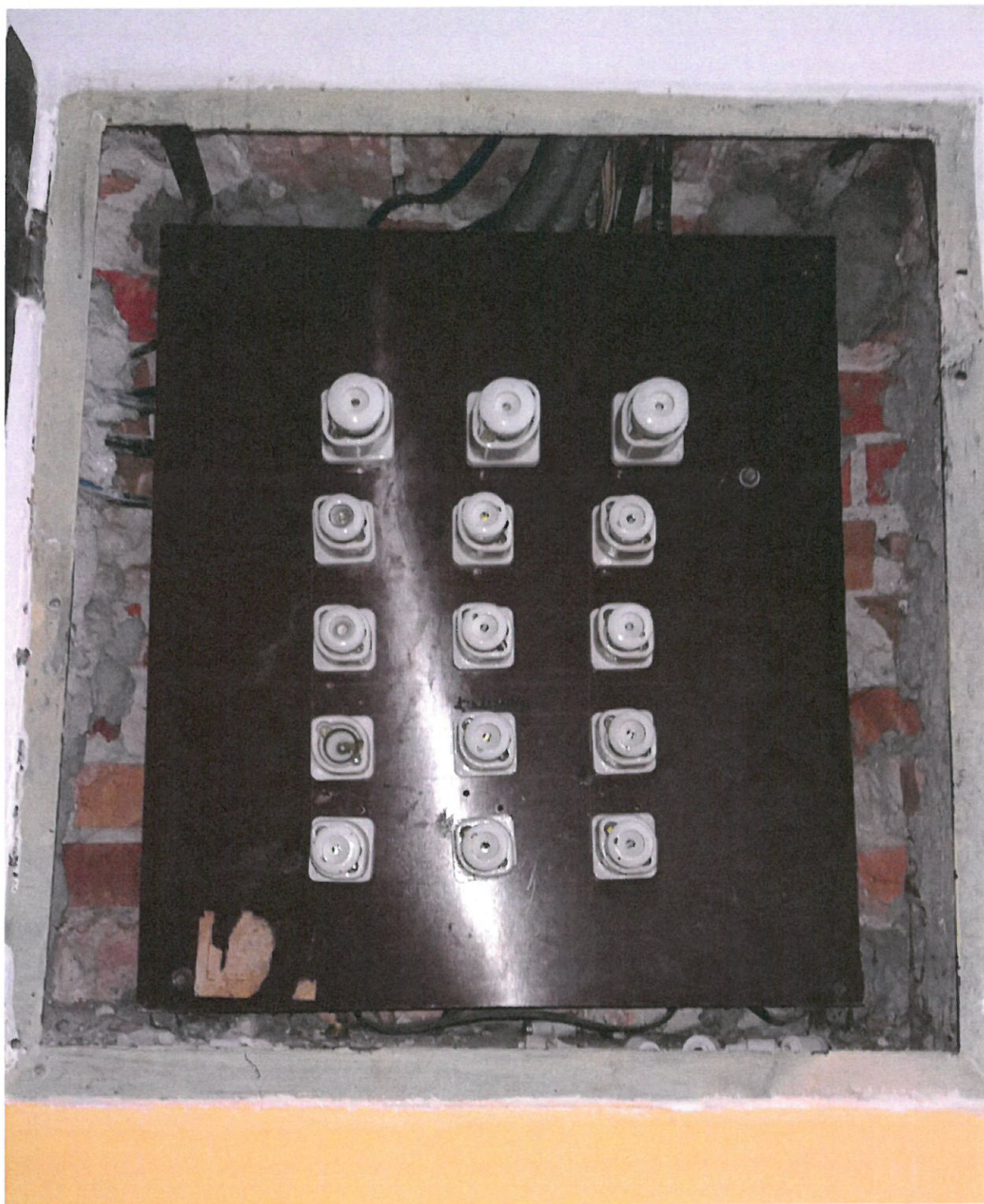
Widok istniejącej rozdzielni TB piętro przeznaczanej do wymiany
