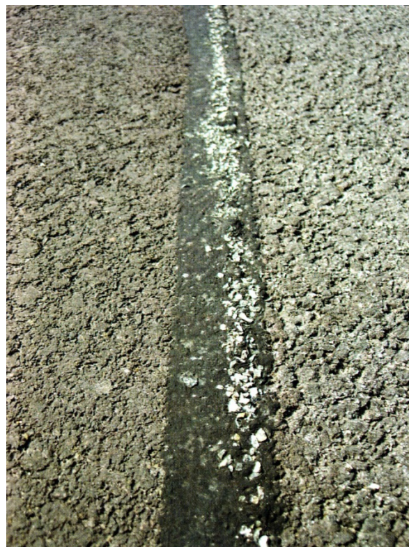
Rys. 4. Wykonanie złącza podłużnego metodą „gorące przy zimnym” bez zastosowania materiału uszczelniającego złącze, np. bez taśmy topliwiej
