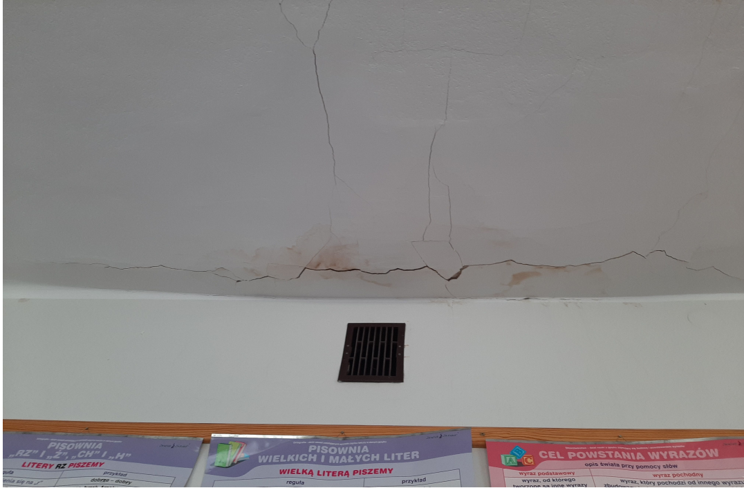
Fot. 1: Widok sufitu ponad I piętrzem w miejscu awarii belek stropowych. Widoczne zarysowanie równoległe do belek stropowych oraz rysa równoległa do wymianu.
