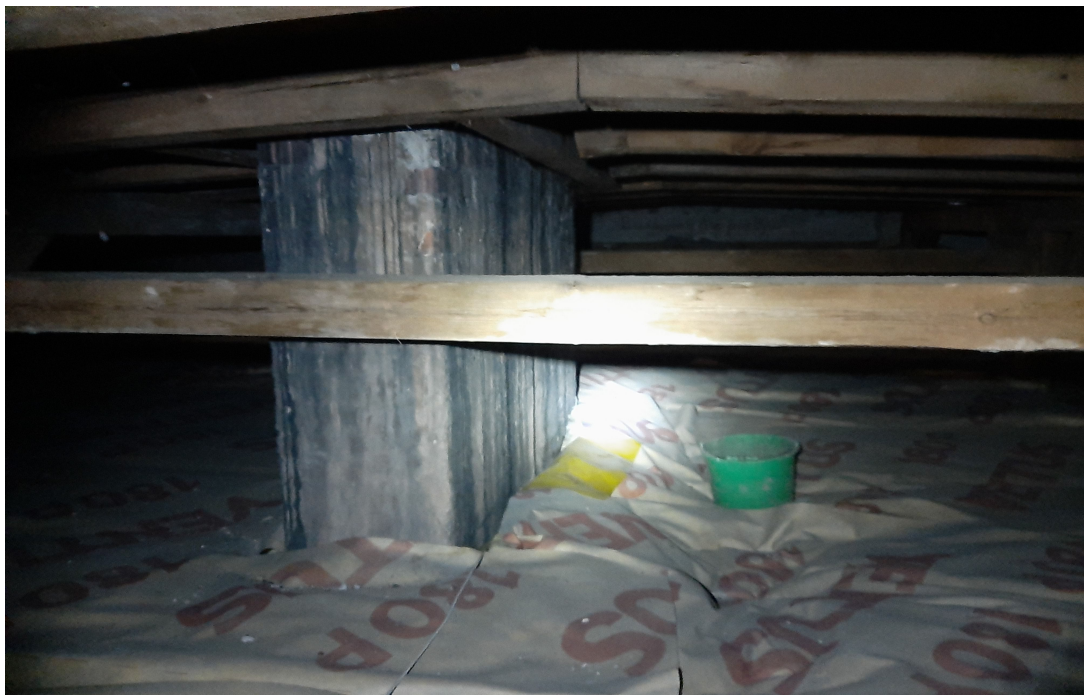
Fot. 2: Widok komina w poddaszu nieużytkowym budynku, nieszczelny dach skutkuje erozją belek drewnianych stropu ponad I piętrzem
