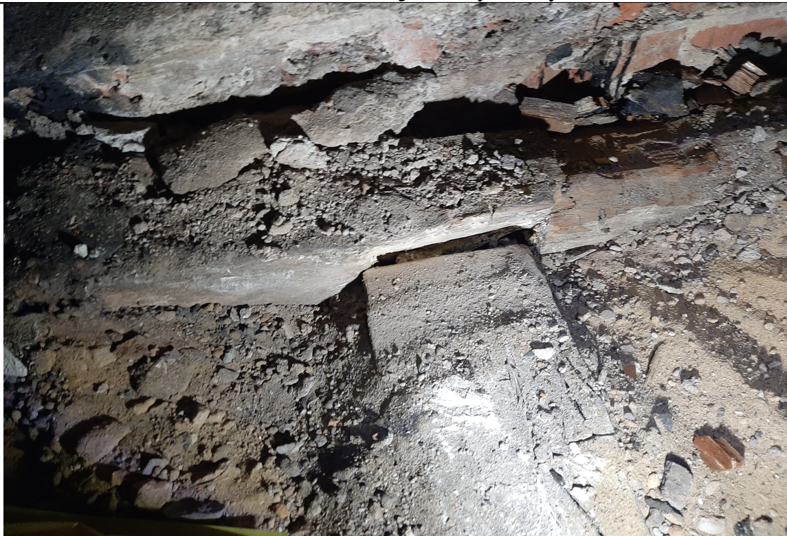
Fot. 3: Widoczne zerwanie zamka pomiędzy belką stropową, a prostopadłym wymianem, widoczne odkształcenie oraz ugięcie belki oraz wymianu.
