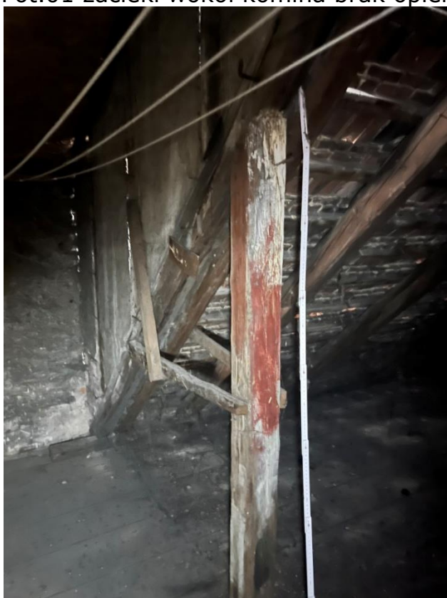
Fot.02 zniszczenia muru pruskiego i słupka wsporczego z krokwiemi
