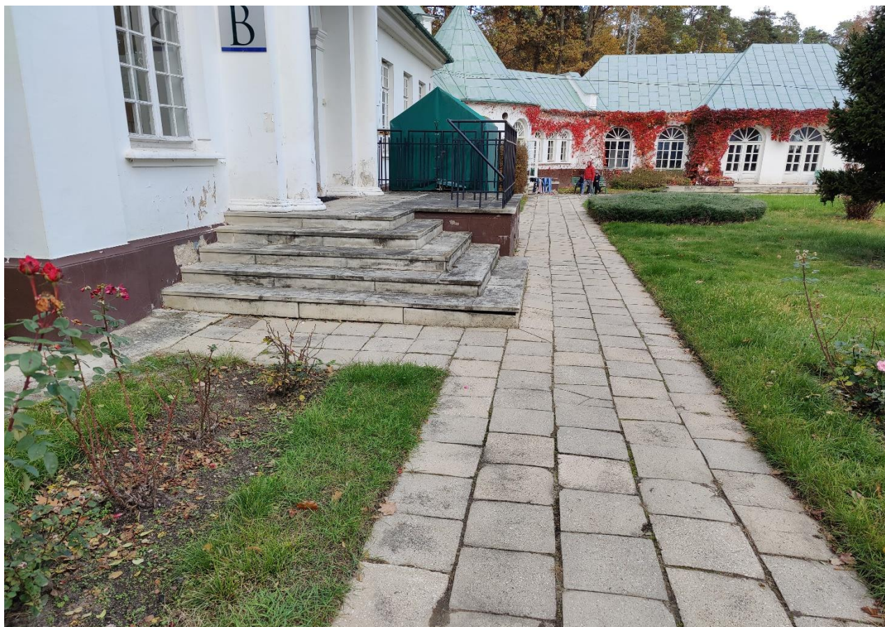
Fot. 1. Nierówności i spękania nawierzchni ciągów pieszo jezdnych.
