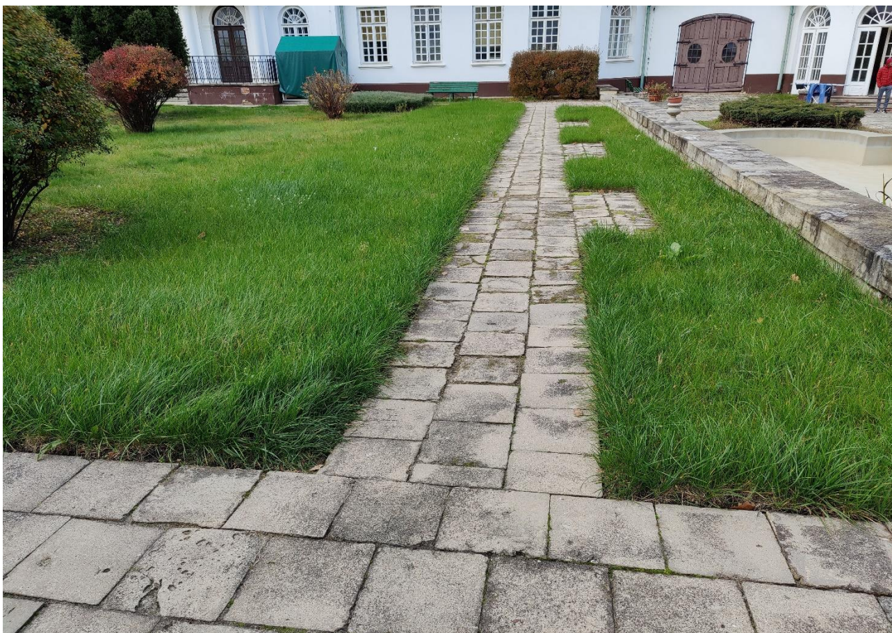
Fot. 4. Nierówności i spękania nawierzchni ciągów pieszo jezdnych.
