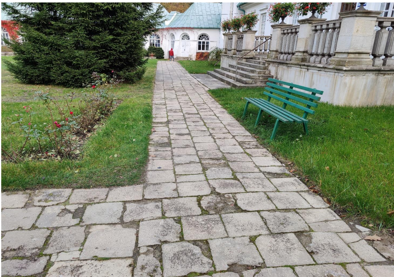
Fot. 5. Nierówności i spękania nawierzchni ciągów pieszo jezdnych.
