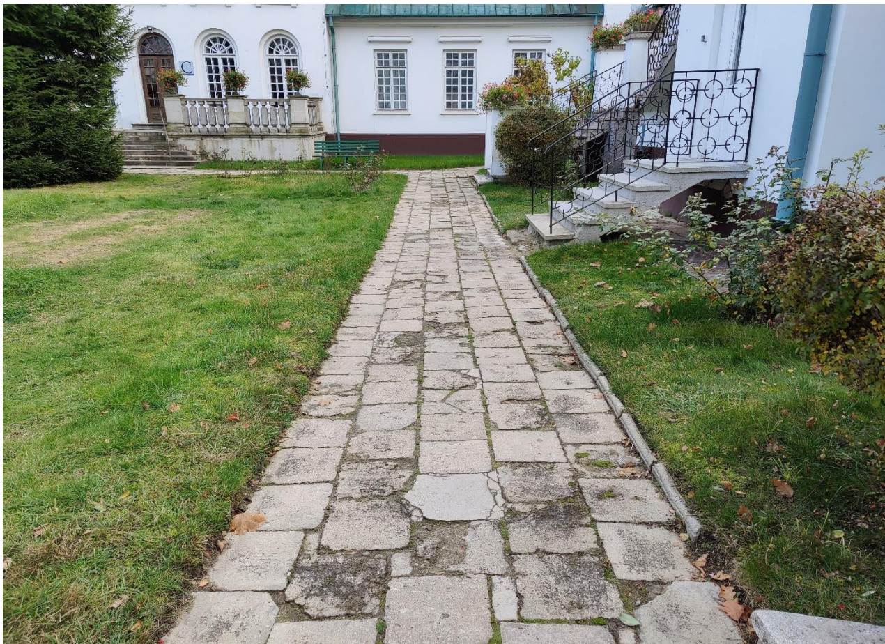
Fot. 2. Nierówności i spękania nawierzchni ciągów pieszo jezdnych.
