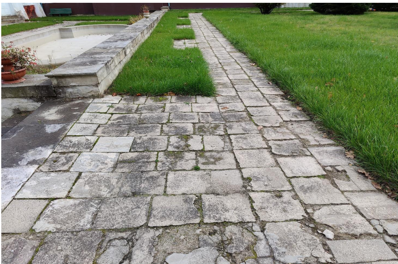
Fot. 7. Nierówności i spękania nawierzchni ciągów pieszo jezdnych.
