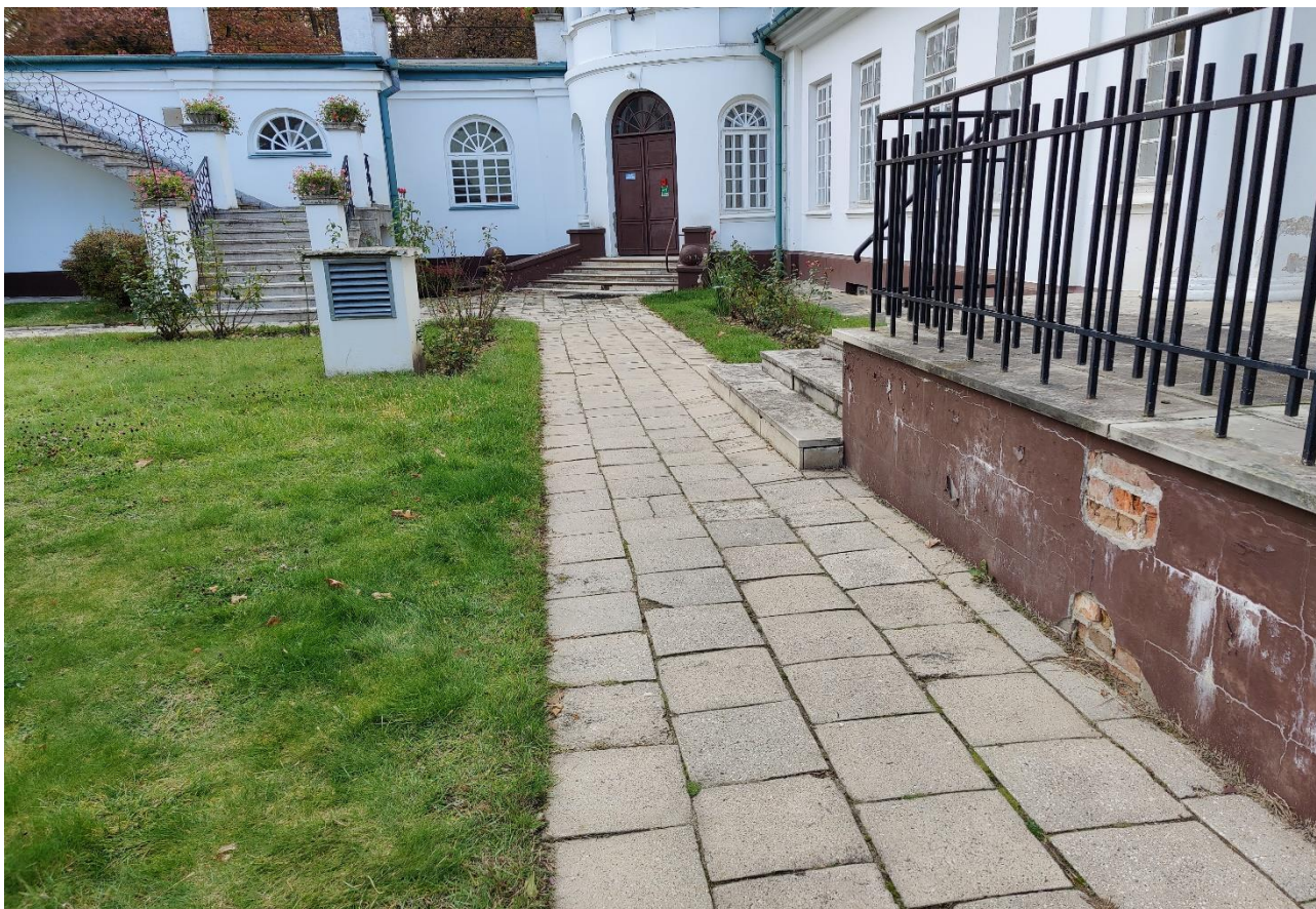
Fot. 8. Nierówności i spękania nawierzchni ciągów pieszo jezdnych.
