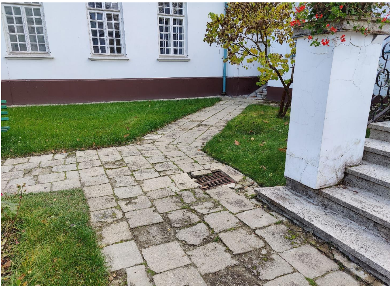
Fot. 6. Nierówności i spękania nawierzchni ciągów pieszo jezdnych.
