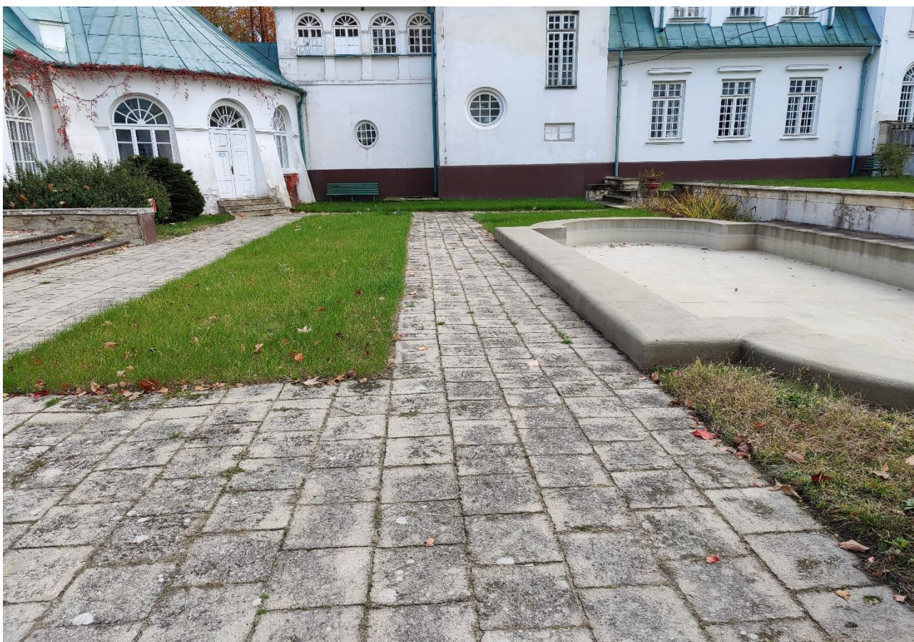
Fot. 3. Nierówności i spękania nawierzchni ciągów pieszo jezdnych.
