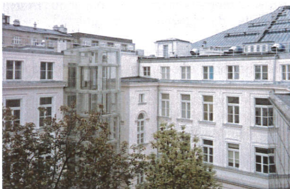
Zastosowanie zewnętrznej windy, która nie zmienia układu wewnętrznego budynku
