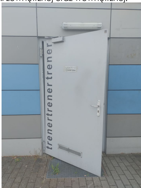
Wyrwane skrzydło drzwiowe z zawiasu górnego
