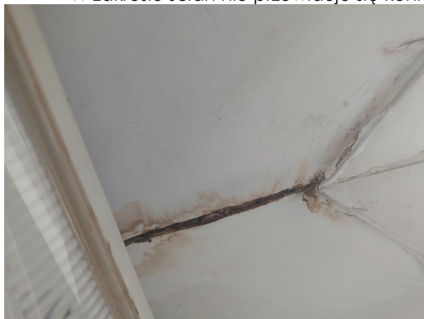
Wyraźne zawilgocenie płyt sufitowych w pomieszczeniu trenera.
