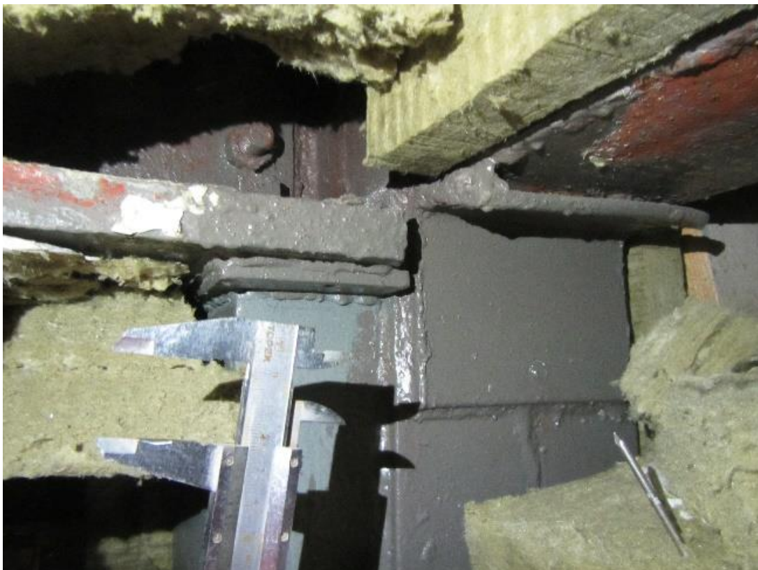
Fot.12. Odkrywka rygla ramy poprzecznej w budynku F- dwuteownik spawany o wysokości 500mm, szerokość półki- 350mm, grubość półki- 25mm, grubość środnika- 12mm. Osie J2- L1/ 23, parter.
