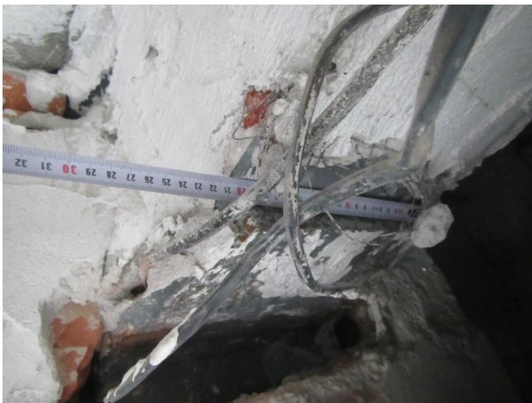
Fot.19. Odkrywka rygla ramy poprzecznej w łączniku E5- dwuteownik spawany o wysokości 280mm, szerokość półki- 200mm, grubość półki- 10mm, grubość środnika- 10mm. Osie D2- E/ 15, parter.
