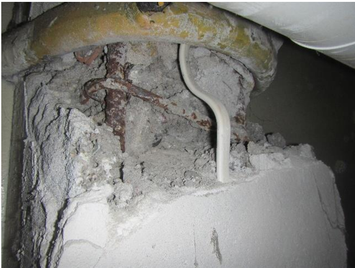
Fot.6. Słup żelbetowy powierzchniowo uszkodzony- budynek F, 1 piętro. Odślonięte zbrojenie. Rura instalacji ogrzewania wchodząca w przekrój słupa pod stropem.
