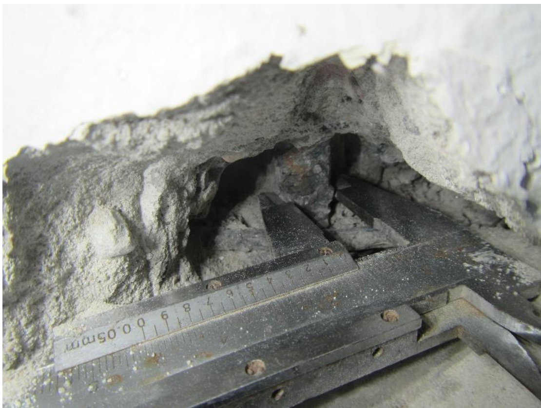
Fot.21. Odkrywka zbrojenia słupa w łączniku E6.
