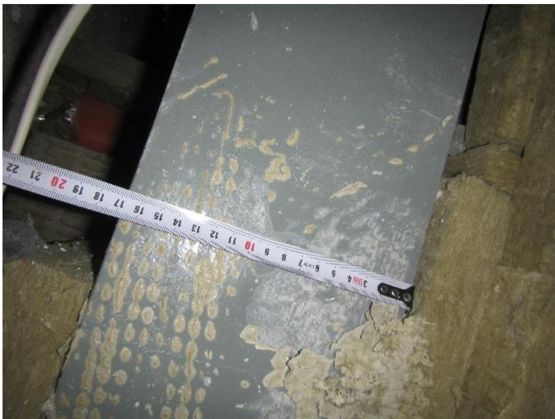
Fot.10. Odkrywka słupa stalowego w budynku F- kształtownik walcowany C240. Osie J2/23, pierwsze piętro.
