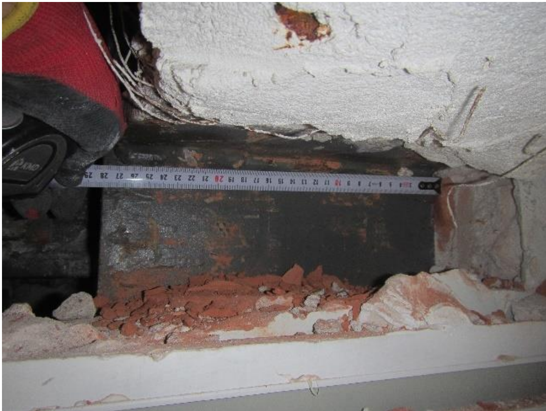
Fot.20. Odkrywka słupa stalowego w łączniku E5- dwuteownik spawany o wysokości 300mm, szerokość półki- 280mm, grubość półki- 20mm, grubość środnika- 10mm. Osie E/ 15, parter.
