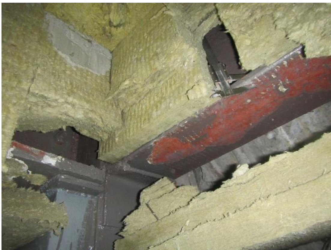
Fot.11. Odkrywka belki stalowej w budynku F- kształtownik walcowany I450. Osie J2/ 23-24, parter.
