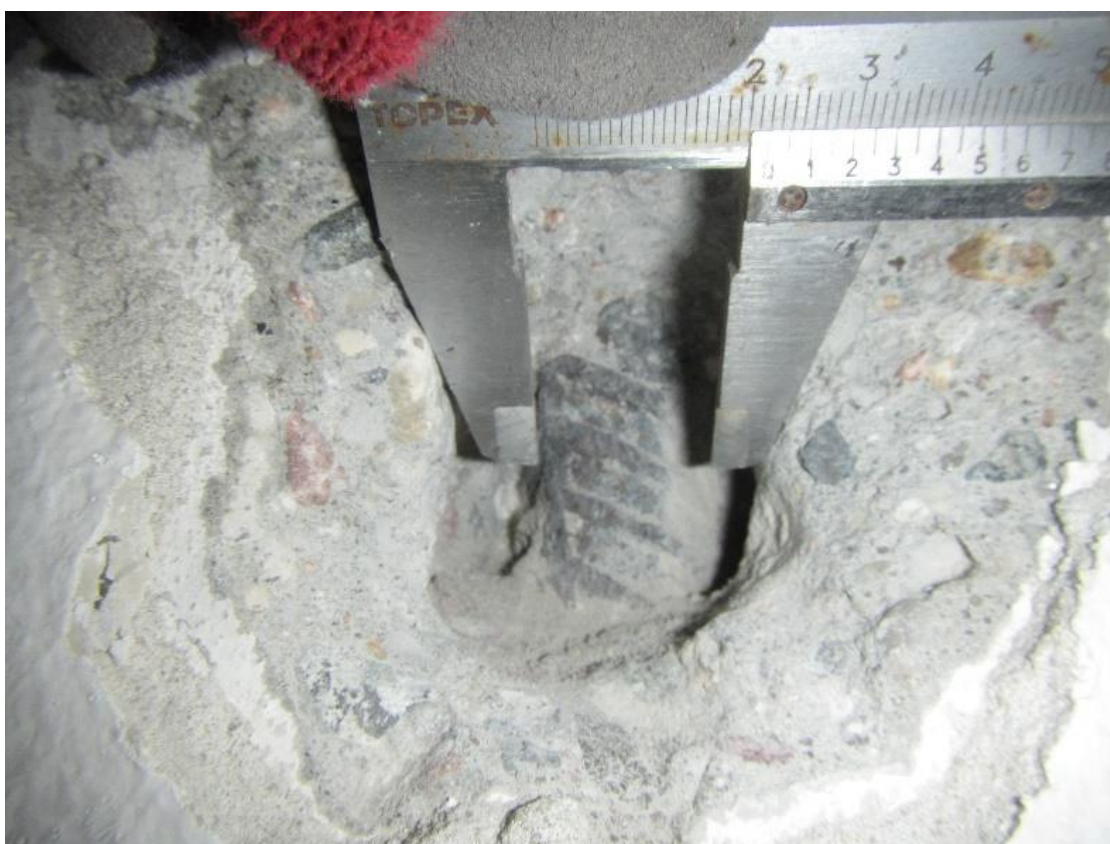
Fot.22. Odkrywka zbrojenia słupa w łączniku E5.
