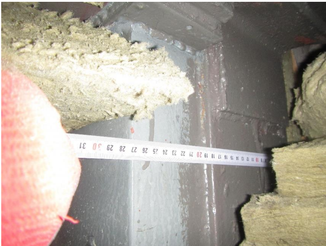
Fot.13. Odkrywka słupa stalowego w budynku F- zespawane ze sobą półkami ceowniki stalowe C260 z dospawanym ceownikiem C240. Osie J2/ 23, parter.
