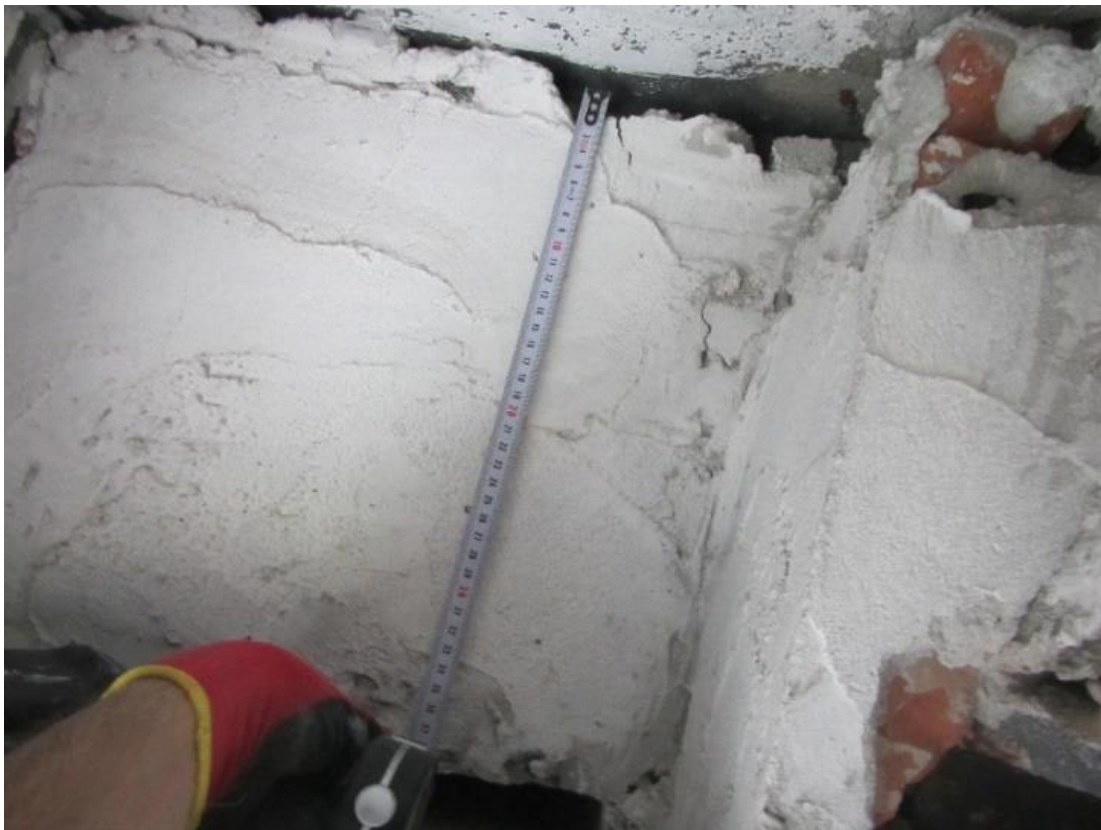
Fot.21. Odkrywka rygla podłużnego w łączniku E5- dwuteownik walcowany I400. Osie E/ 15-16, parter.
