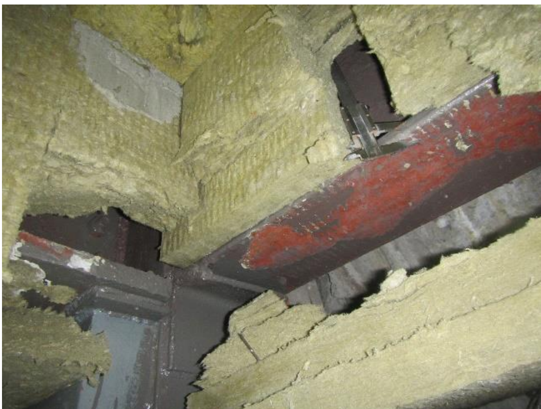
Fot.15. Odkrywka rygla ramy poprzecznej w budynku F- dwuteownik walcowany I450. Osie F1/ 22-23, parter.
