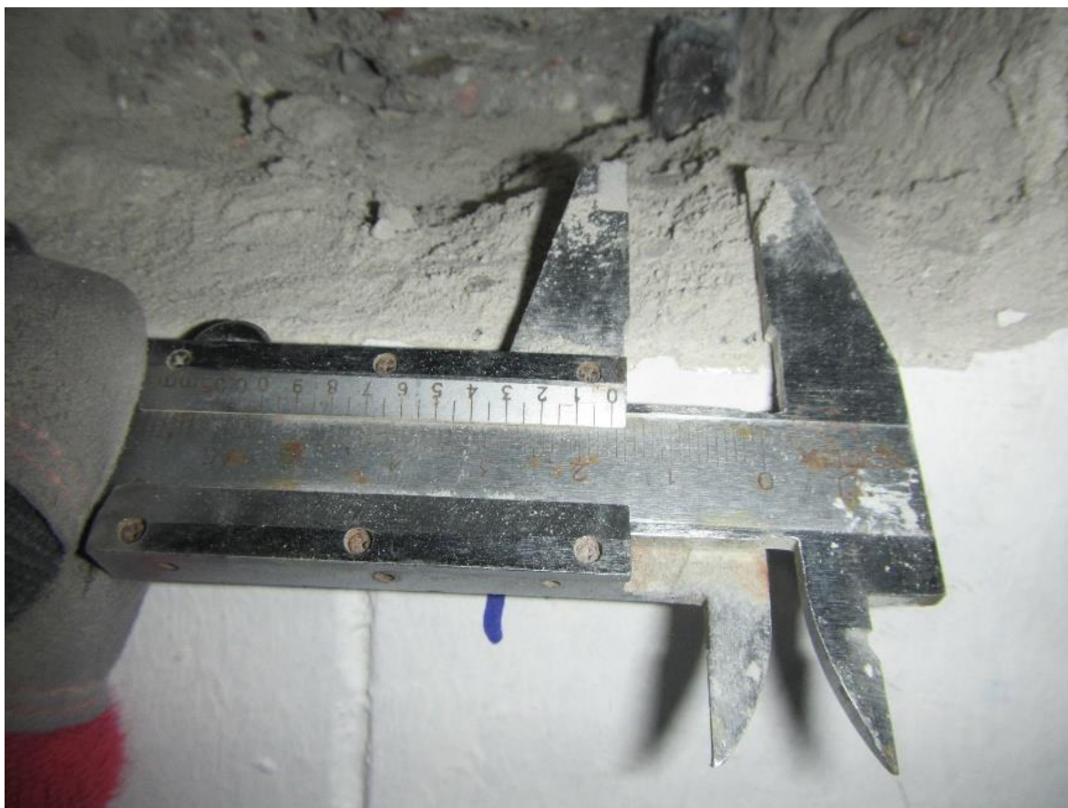
Fot.23. Odkrywka zbrojenia słupa w łączniku E4.
