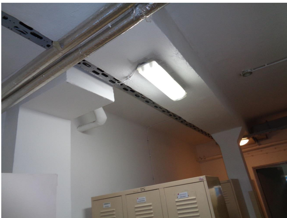
Fot.4. Ramy poprzeczne niskiego parteru w budynku F- słupy żelbetowe wraz z podciągami.
