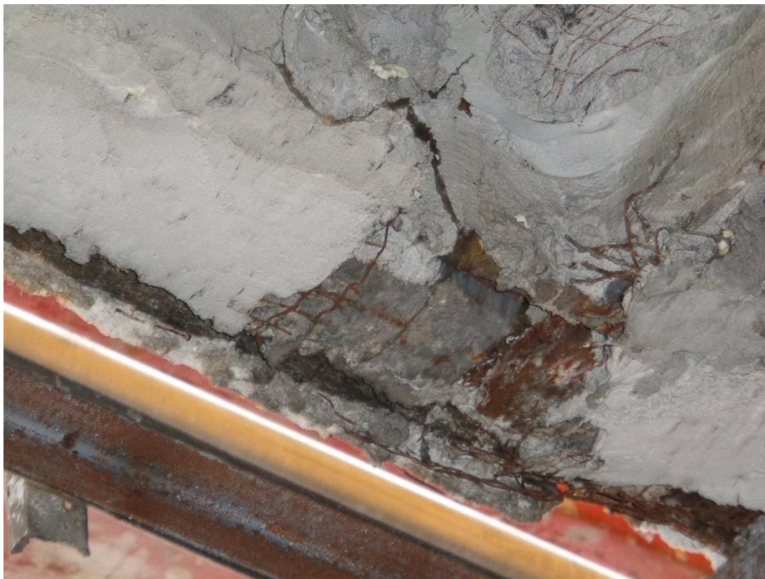
Fot. 2. Widoczne ubytki tynku oraz lokalna korozja belki stalowej w bloku E3.
