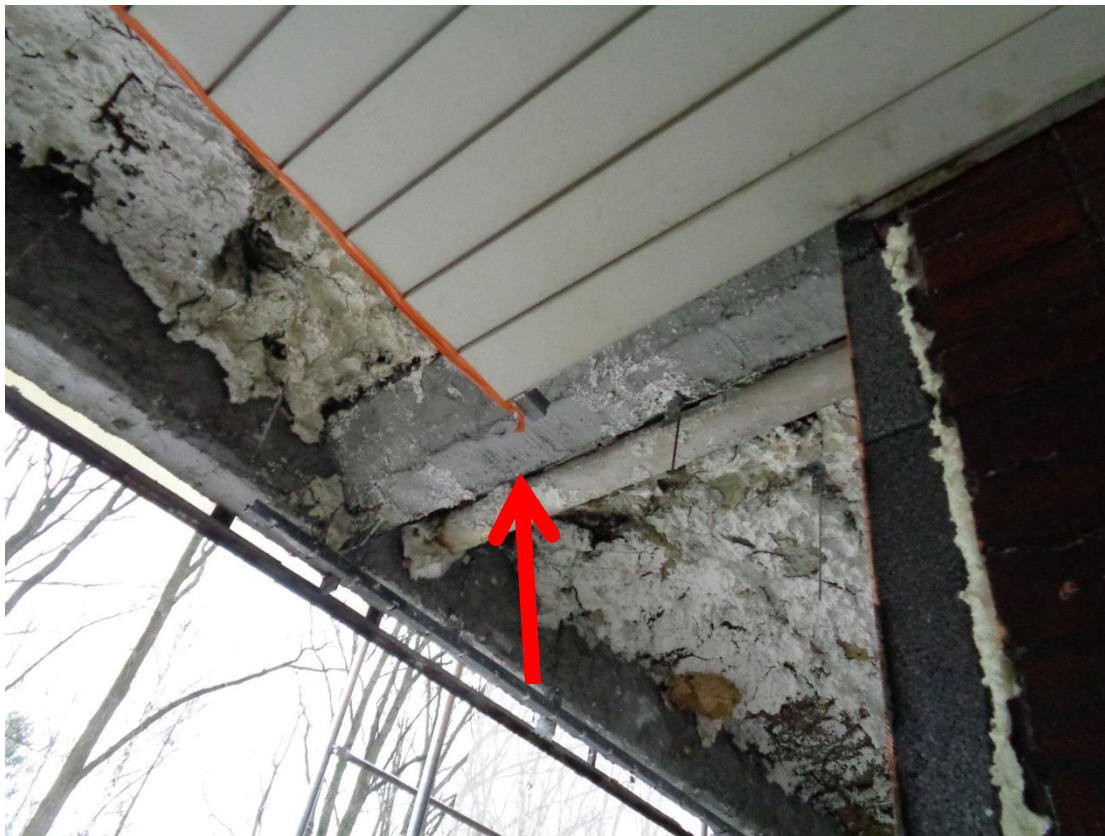
Fot.1. Widoczny rygiel ramy poprzecznej (oszczędowany i otynnkowany) w bloku E3.
