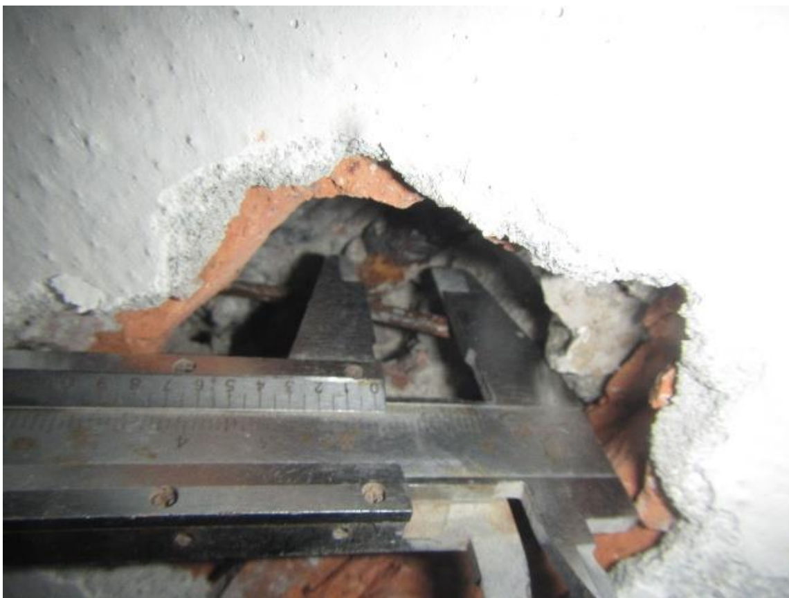
Fot.7. Odkrywka stropu typu Ackermana nad 1 piętrem budynku F.
