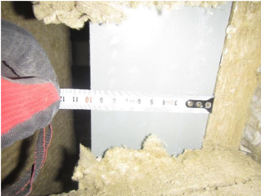
Fot.9. Odkrywka belki stalowej opartej na ramie poprzecznej w budynku F- kształtownik walcowany I220. Osie 22-23, pierwsze piętro.
