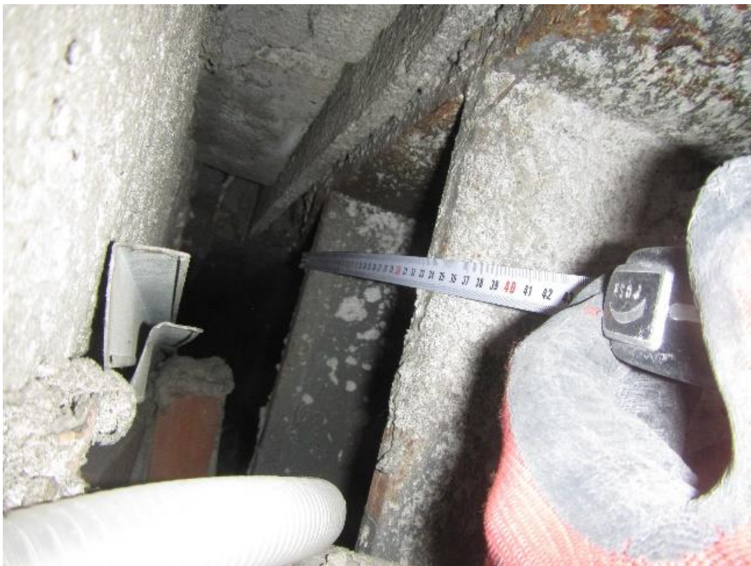
Fot.14. Odkrywka słupa stalowego w budynku F- dwuteownik spawany o wysokości 340mm, szerokość półki- 280mm, grubość półki- 20mm, grubość środnika- 10mm. Osie F1/ 23, parter.
