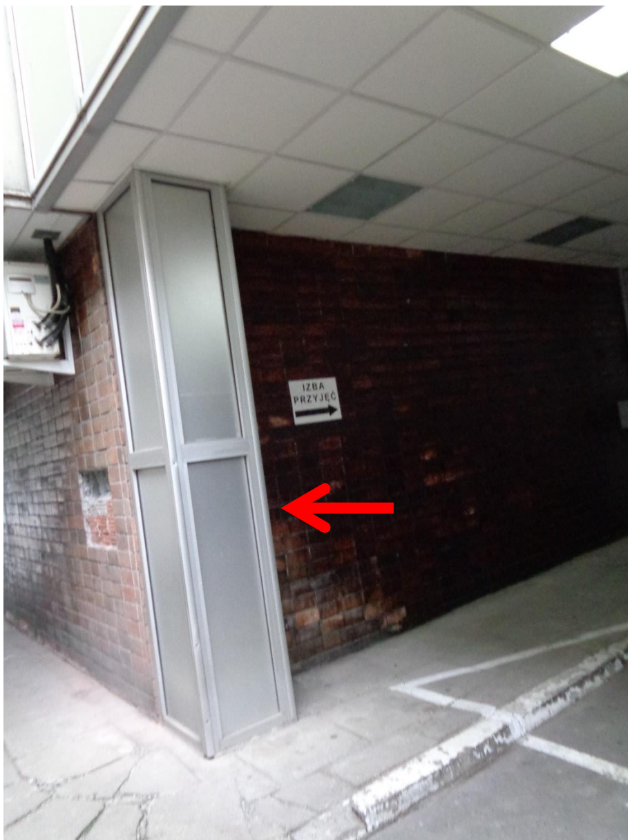
Fot.5. Stalowy słup w podjeździe dla karetek, obudowany panelami aluminiowymi.
