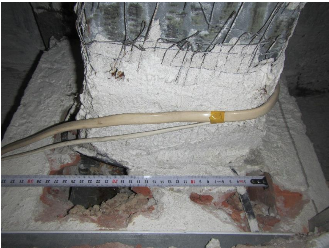
Fot.17. Odkrywka słupa stalowego w łączniku E4- dwuteownik spawany o wysokości 300mm, szerokość półki- 280mm, grubość półki- 20mm, grubość środnika- 10mm. Osie E/ 23b, parter.
