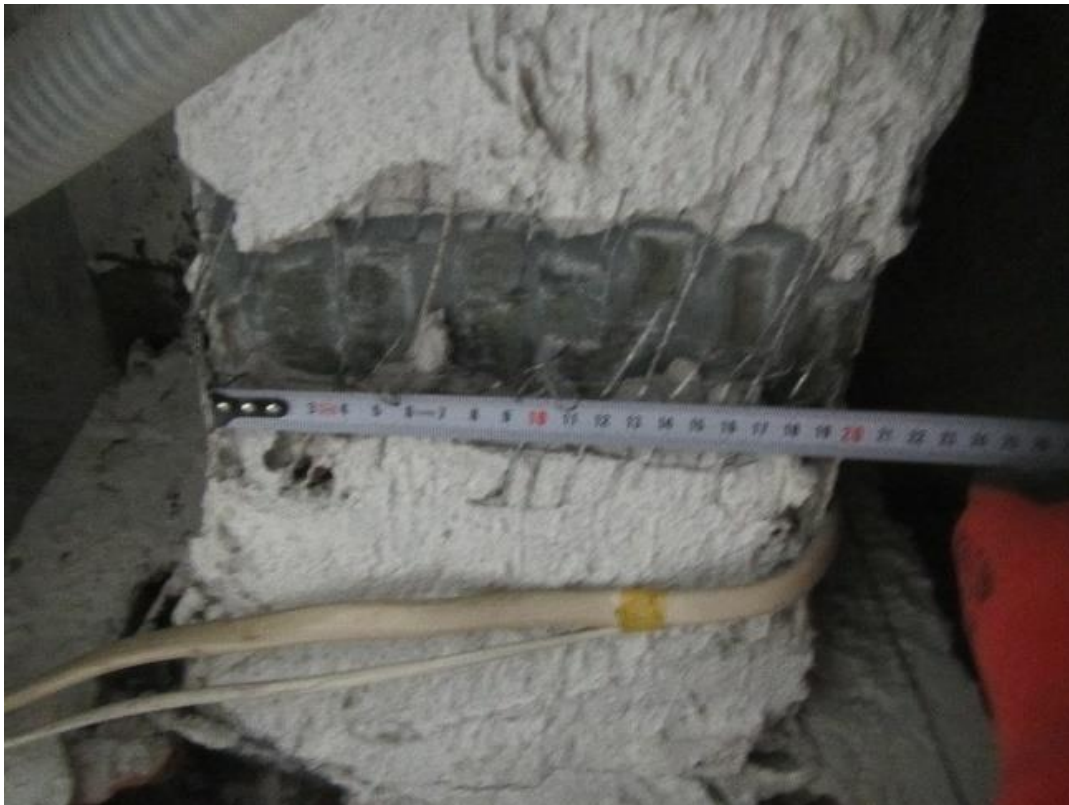
Fot.16. Odkrywka rygla ramy poprzecznej w łączniku E4- dwuteownik spawany o wysokości 280mm, szerokość półki- 200mm, grubość półki- 10mm, grubość środnika- 10mm. Osie D- E/ 23b, parter.
