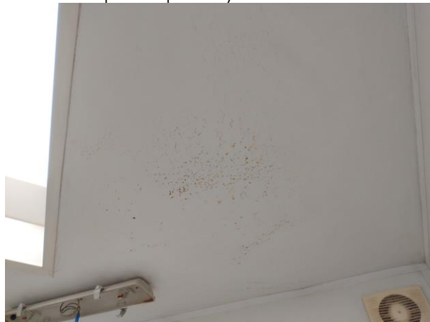
Wykwyty wilgoci widoczne na suficie w toalecie damskiej oraz dla osób niepełnosprawnych
