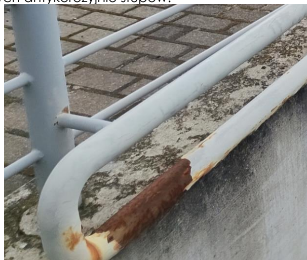
Rdzewiejące powierzchnie balustrad.
