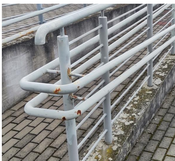
Rdzewiejące powierzchnie balustrad.
