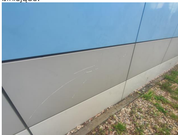
Powyższe zarysowania należy naprawić poprzez wykonanie wyprawki lakierniczej.
