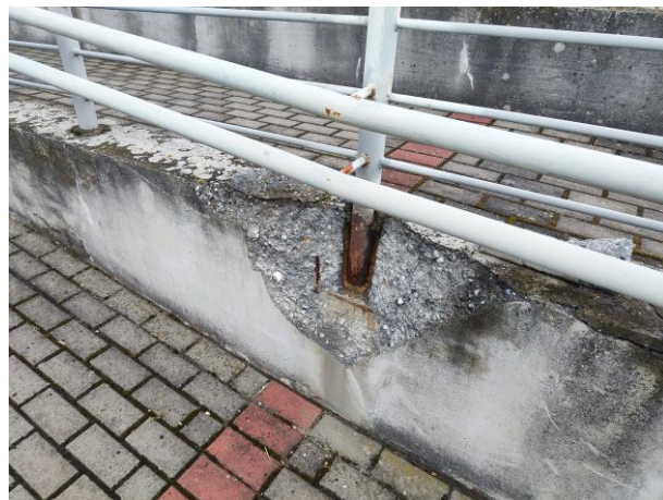
Złuszczenia oraz ubytki w betonie, odsłaniające słupki w murze oraz zbrojenie.
