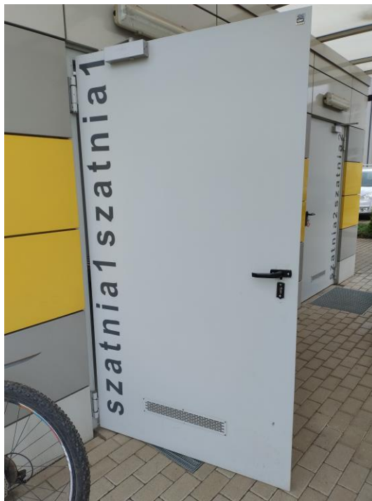
Zbyt nisko osadzone skrzydło styka się z nawierzchnią utrudniając otwarcie skrzydła.
