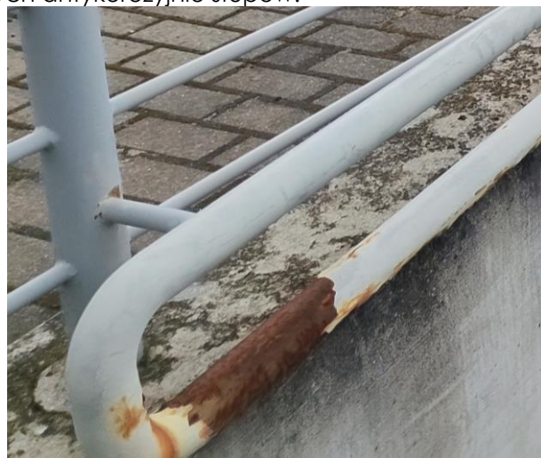
Rdzewiejące powierzchnie balustrad.
