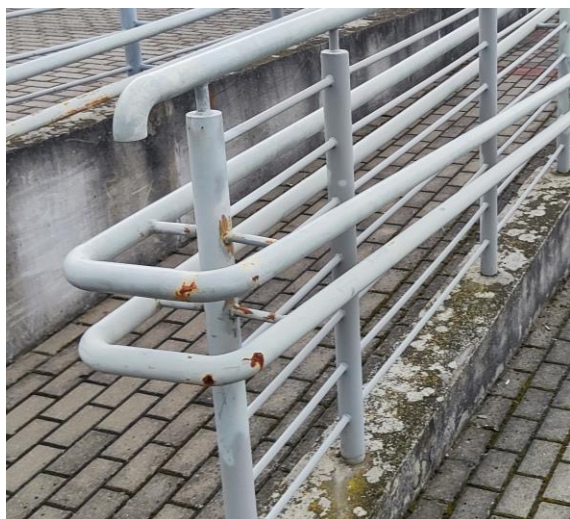
Rdzewiejące powierzchnie balustrad.
