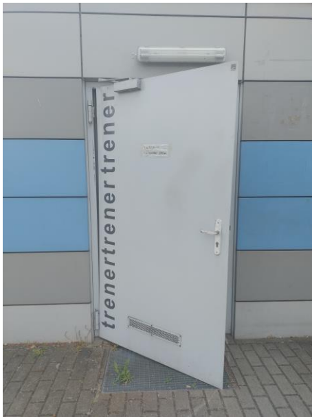
Wyrwane skrzydło drzwiowe z zawiasu górnego
