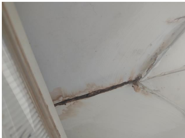
Wyraźne zawilgocenie płyt sufitowych w pomieszczeniu trenera.
