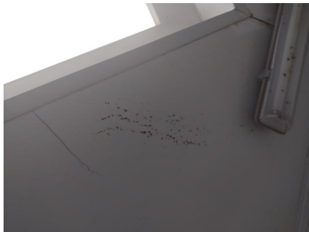
Wykwity wilgoci widoczne na suficie w toalecie damskiej oraz dla osób niepełnosprawnych
