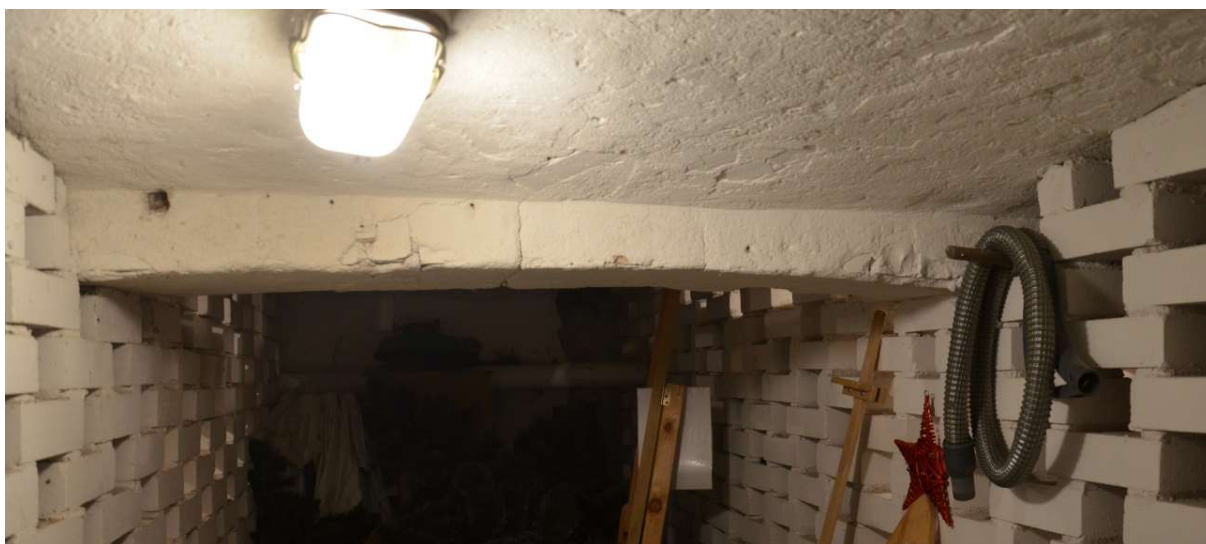
Rys. 7. Zarysowanie podciągu w piwnicy.
