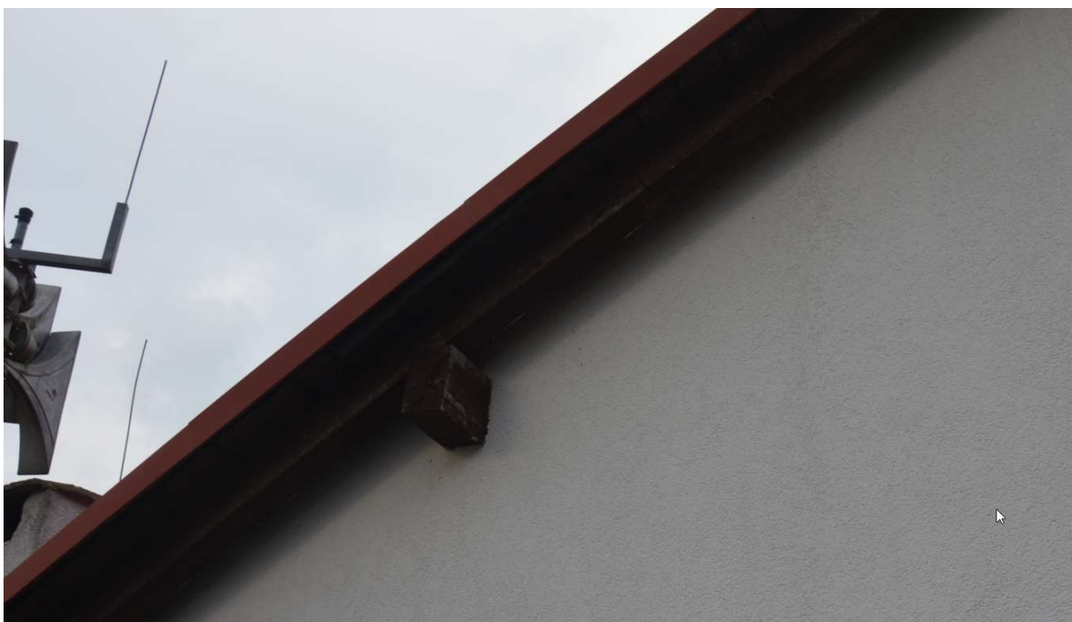
Rys. 4. Zawilgocenie płatwi ram stółcowych przy ścianach szczytowych.
