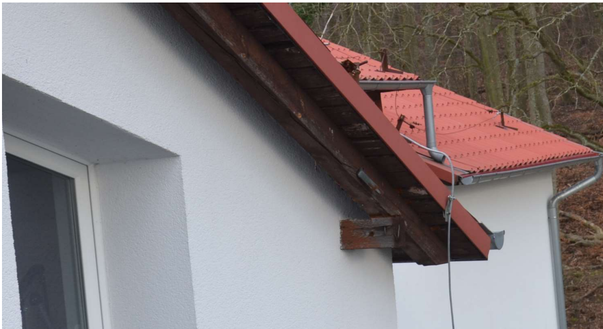
Rys. 5. Uszkodzenie murlat przy ścianach szczytowych
