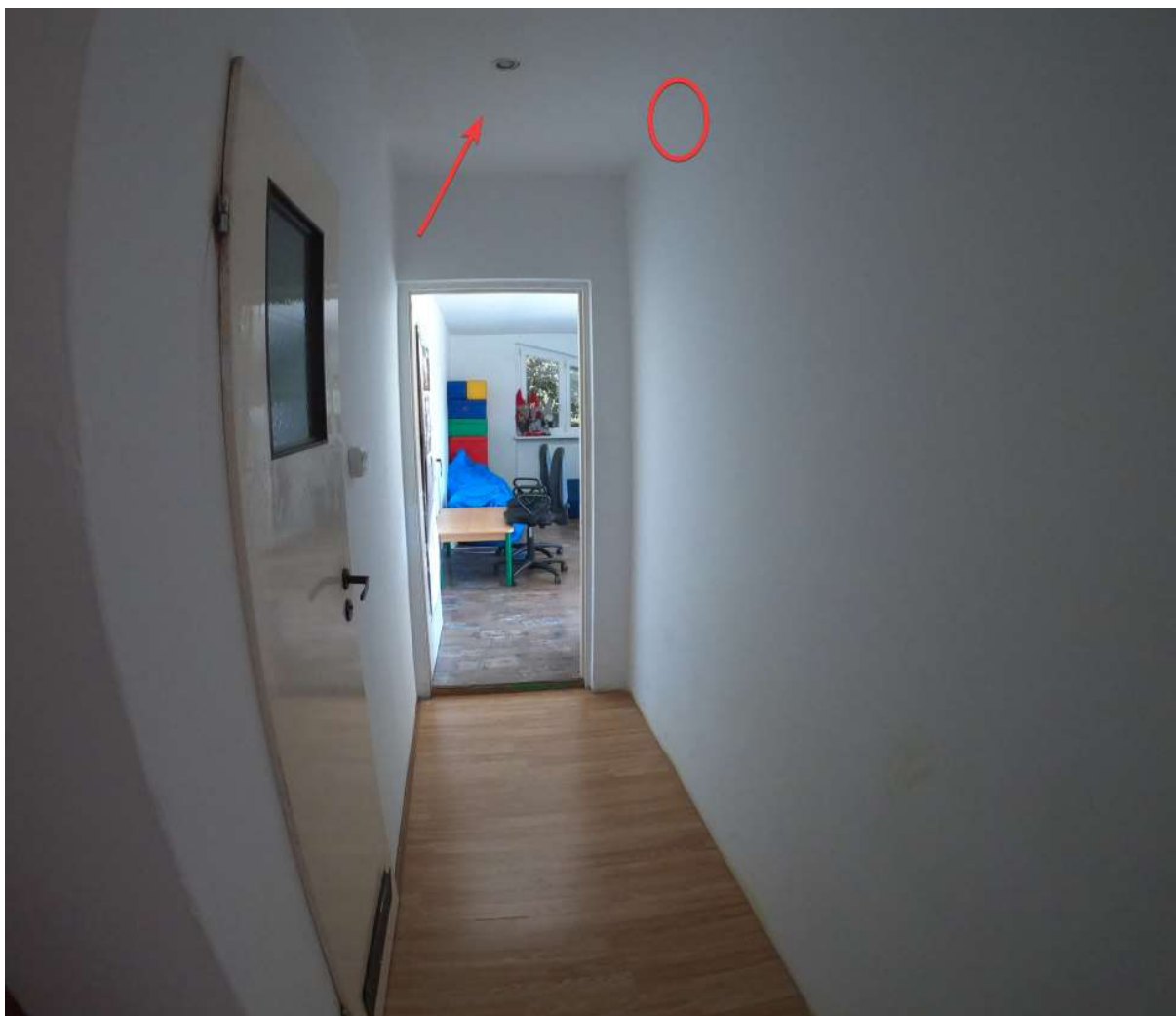
Rys. 8. Wskazanie kolejności rozbiórek oraz wykonania odkrywek: 1) wskazanie na sufit podwieszony; 2) zaznaczenie punktowych odkrywek w ścianie między pom. 2.12. oraz 2.13
