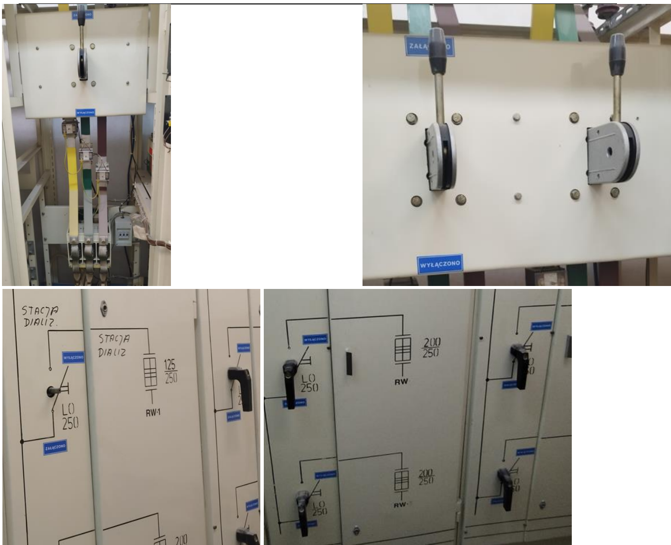
Rozłączniki mocy OZK oraz LO - Rozdzielnia RG1 w budynku szpitala
