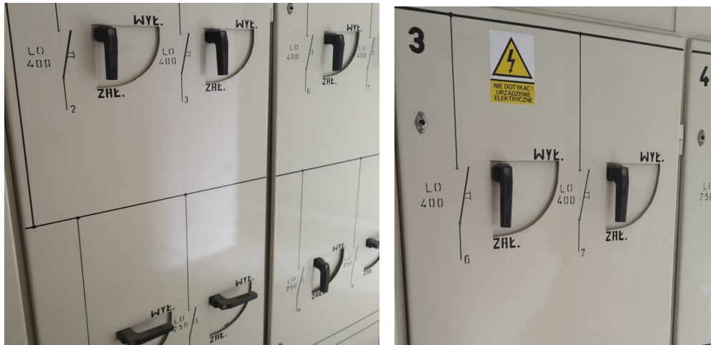
Rozłączniki izolacyjne w rozdzielni głównej RG nN
