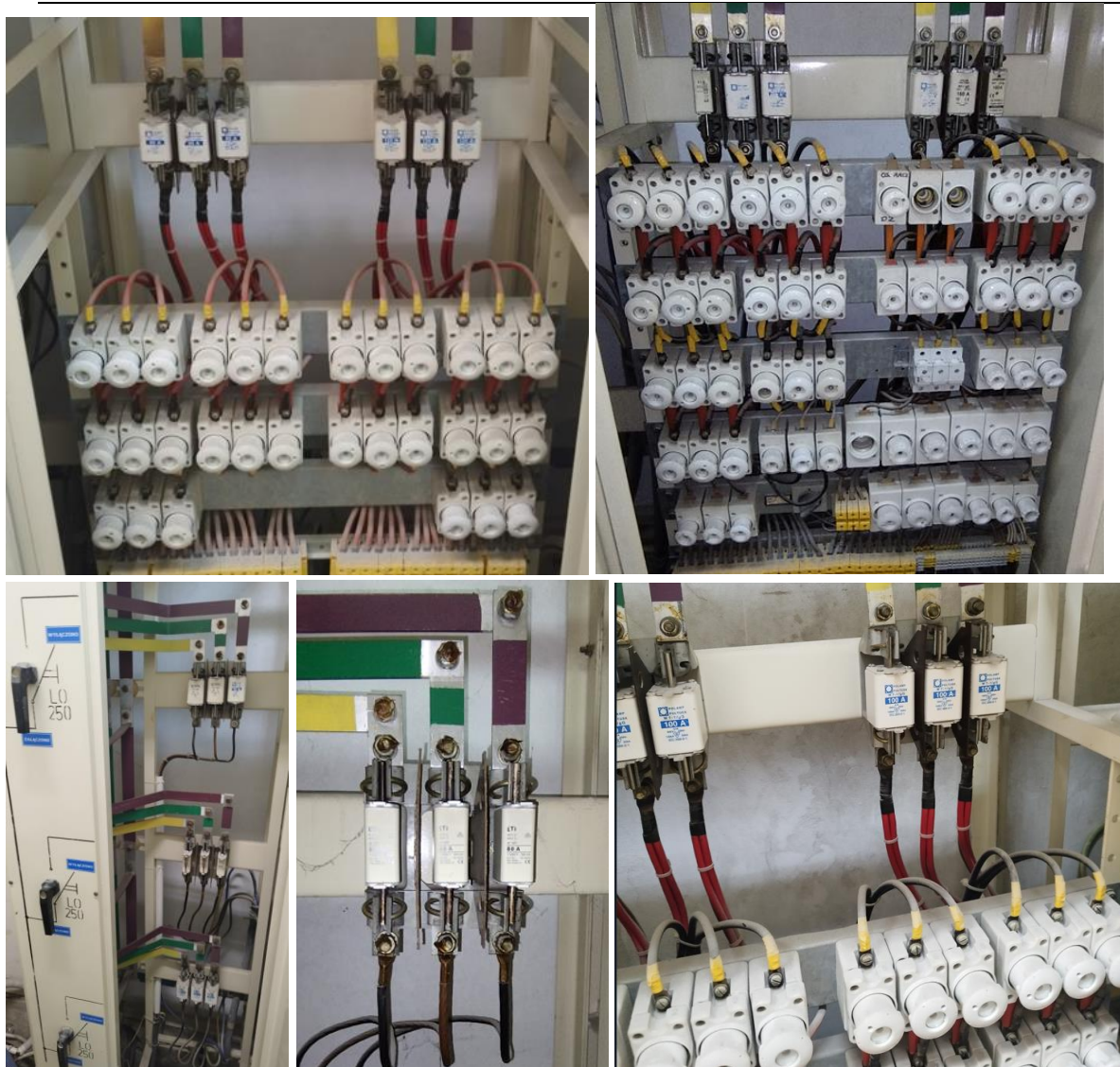
Podstawy bezpieczników BM oraz bezpieczników topikowych - Rozdzielnia RG1 w budynku szpitala
