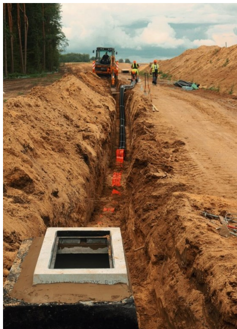
Rys. 34. Zamontowana studzienka kablowa
