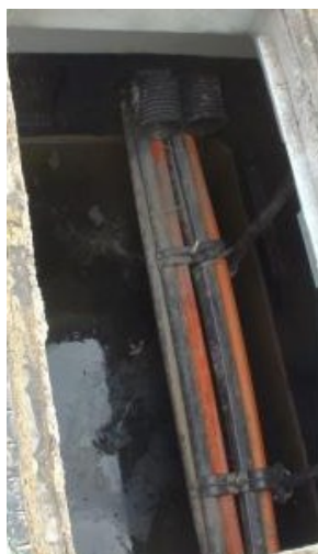
Rys. 34. Zamontowana studzienka kablowa
