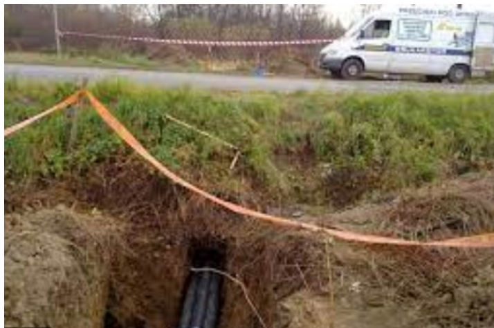
Rys. 31. Kanał kablowy umieszczony metodą przewiertu
