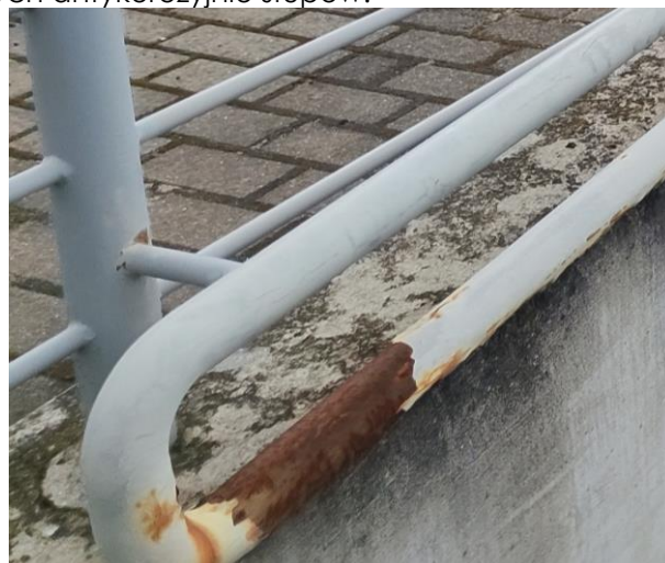
Rdzewiejące powierzchnie balustrad.
