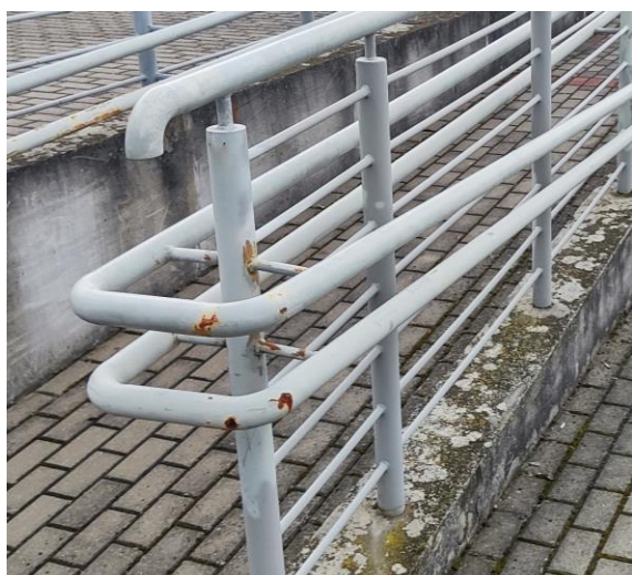
Rdzewiejące powierzchnie balustrad.
