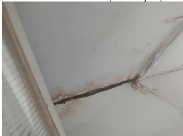
Wyraźne zawilgocenie płyt sufitowych w pomieszczeniu trenera.
