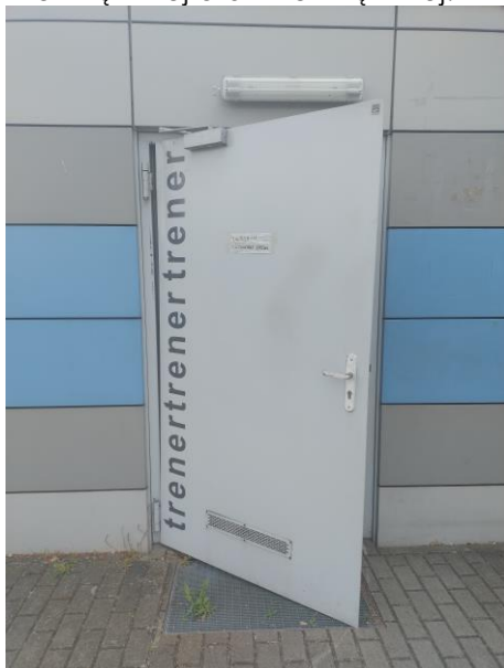
Wyrwane skrzydło drzwiowe z zawiasu górnego
