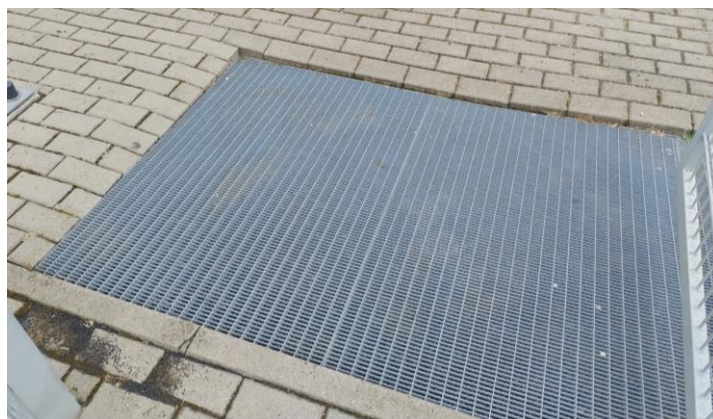
Zapadnięta nawierzchnia w obrębie wycieraczki wejściowej na boisko
