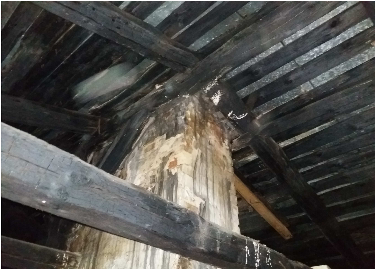
Fot.20 Część główna dachu- obszar PP-podłużne pęknięcia elementów,zawilgocenie ściany komina,zniszczenie tynku
