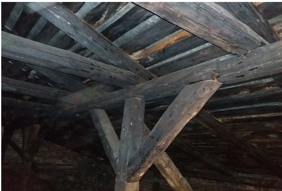
Fot.18 Część główna dachu- obszar PP-podłużne pęknięcia elementów, brak oparcia płatwi, przekoszenie płatwi nad mieczami słupa
