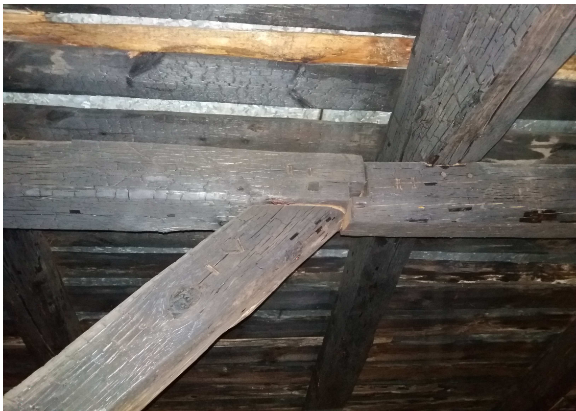
Fot.19 Część główna dachu- obszar PP-podłużne pęknięcia elementów, wadliwe wykonanie oparcia płatwi, przekręcenie jętki
