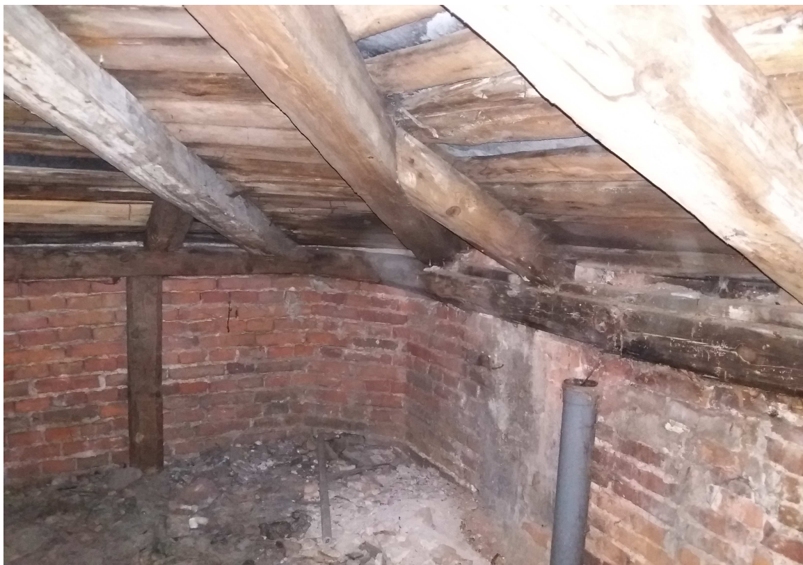
Fot.5 Oficyna-zawilgocone odcinki murlat;spękania podłużne;brak wyprowadzenia wywiewek kanalizacyjnych ponad dach
