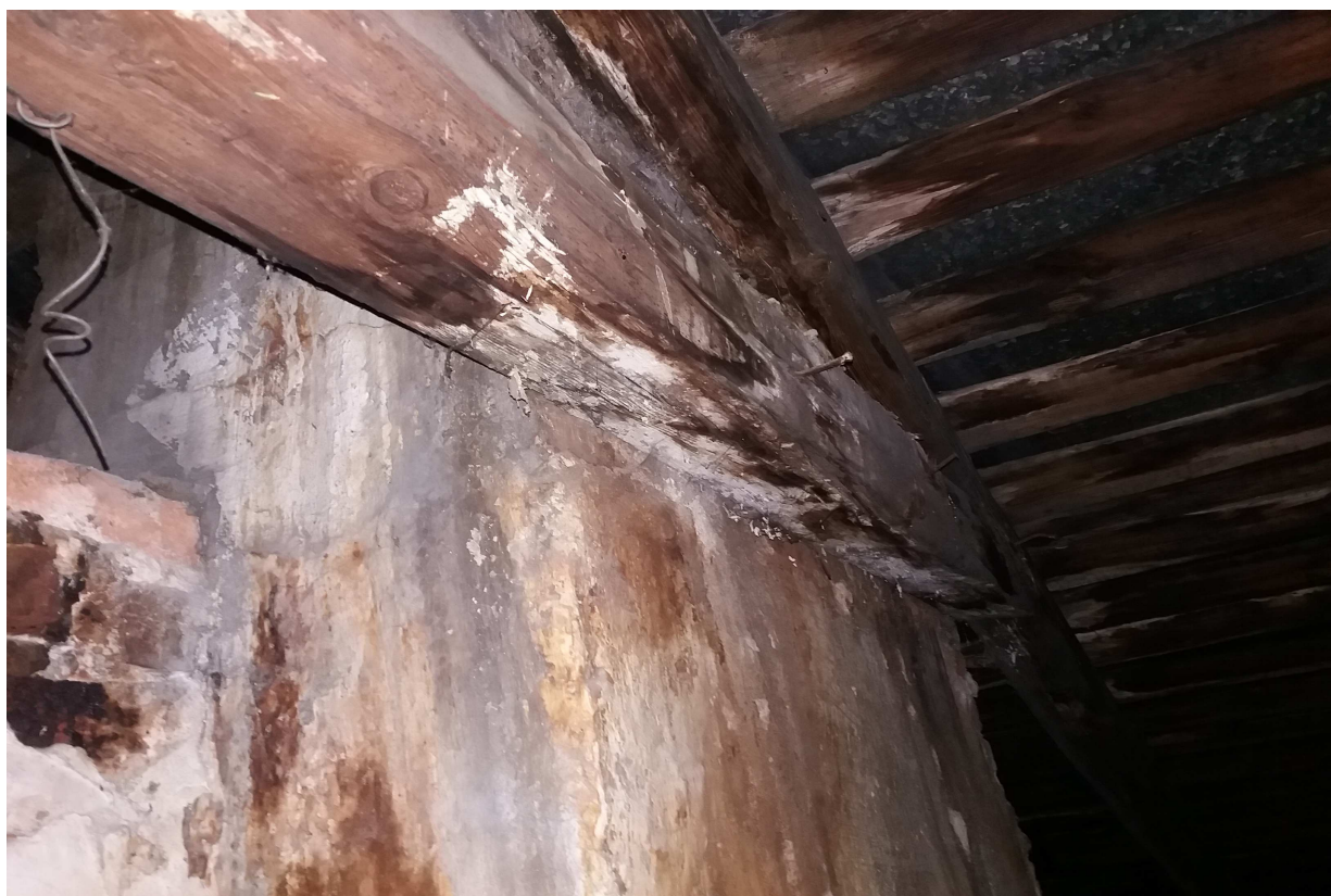
Fot.2 Oficyna-wejście;liczne zacieki przy kominie,płatew zawilgocona z fragmentami spróchnienia
