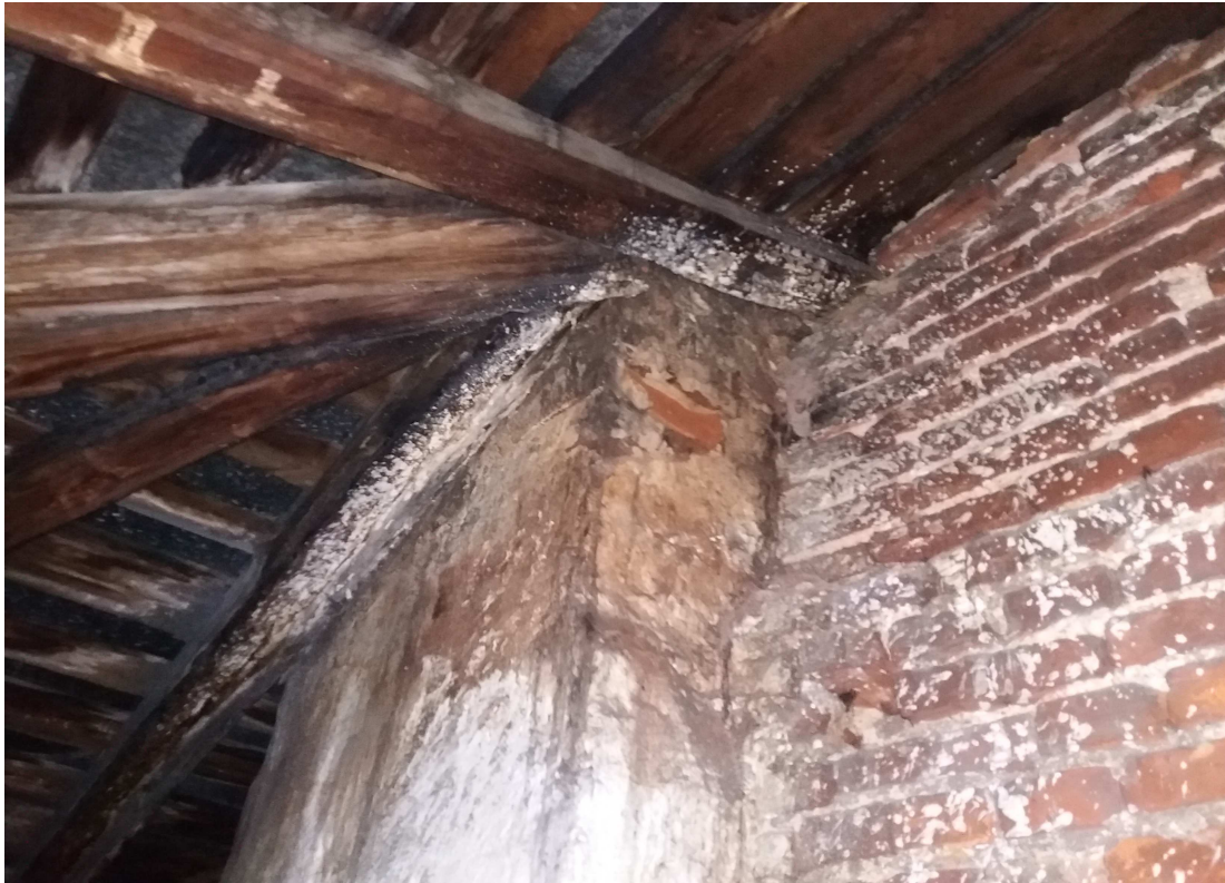
Fot.3 Oficyna-liczne zacieki w dachu; zagrzybienie elementów konstrukcji-krokwie
