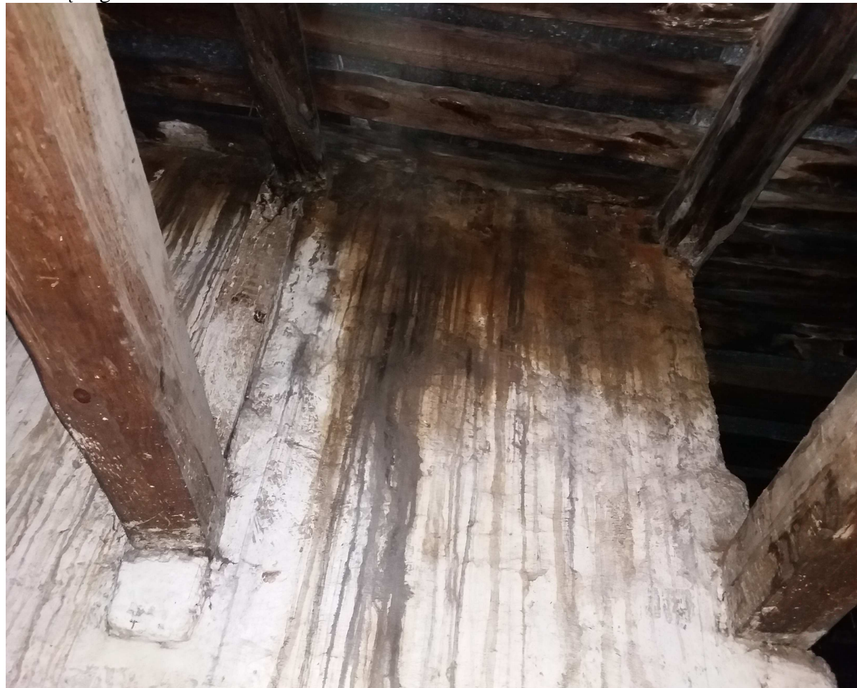
Fot.14 Część główna dachu- liczne zacieki na ścianach kominów
