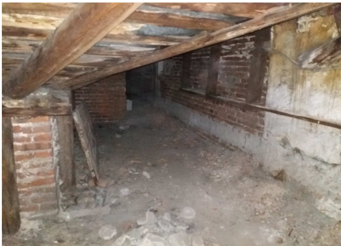
Fot.6 Oficyna-zawilgocone odcinki murlat;brak możliwości oceny podwalin i mocowań słupków do podłoża
