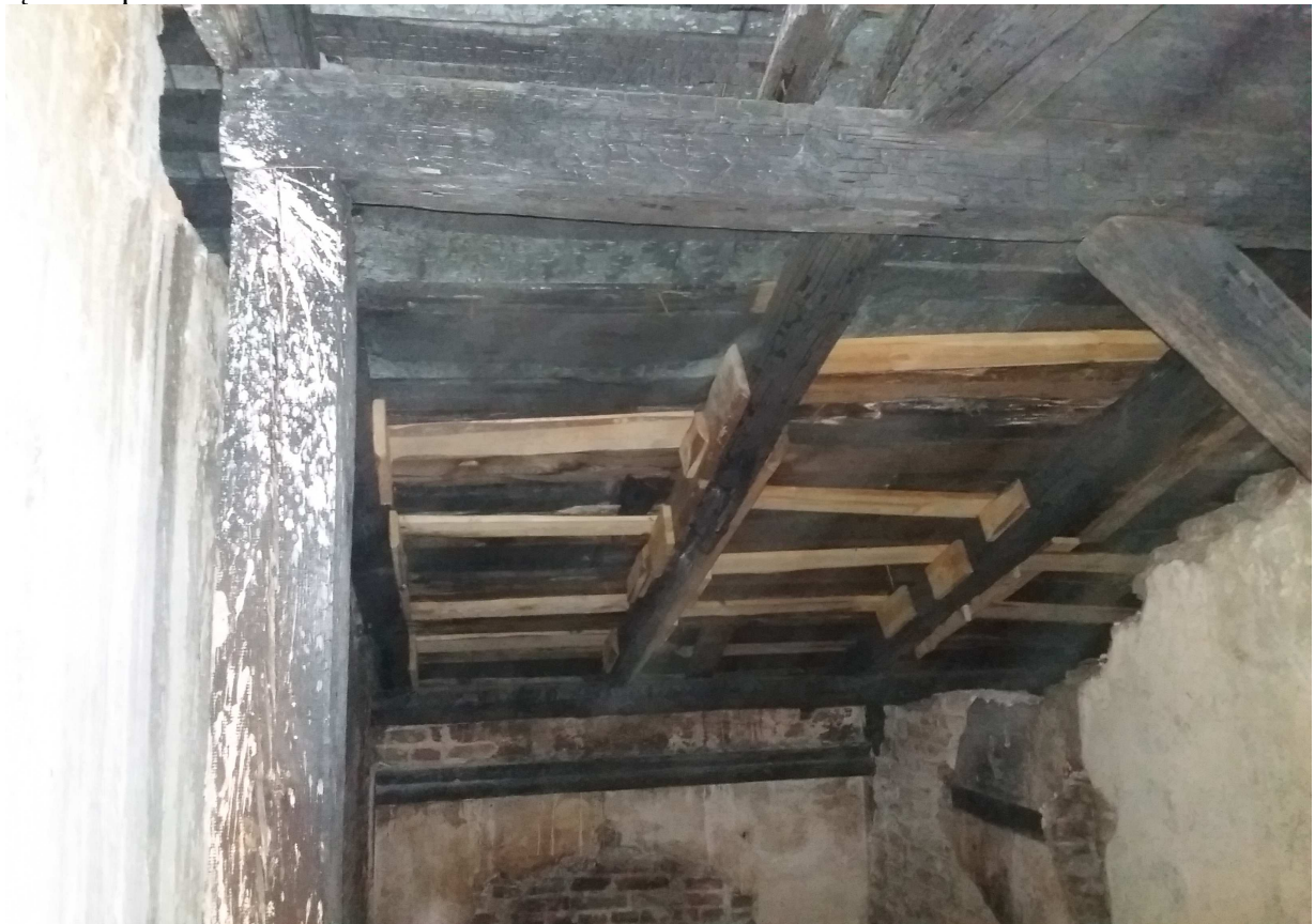
Fot.22 Część główna dachu- obszar PP-podłużne pęknięcia elementów,zawilgocenie ścian,poprzerywane deskowanie a nowe dobite do osłabionych krokwi
