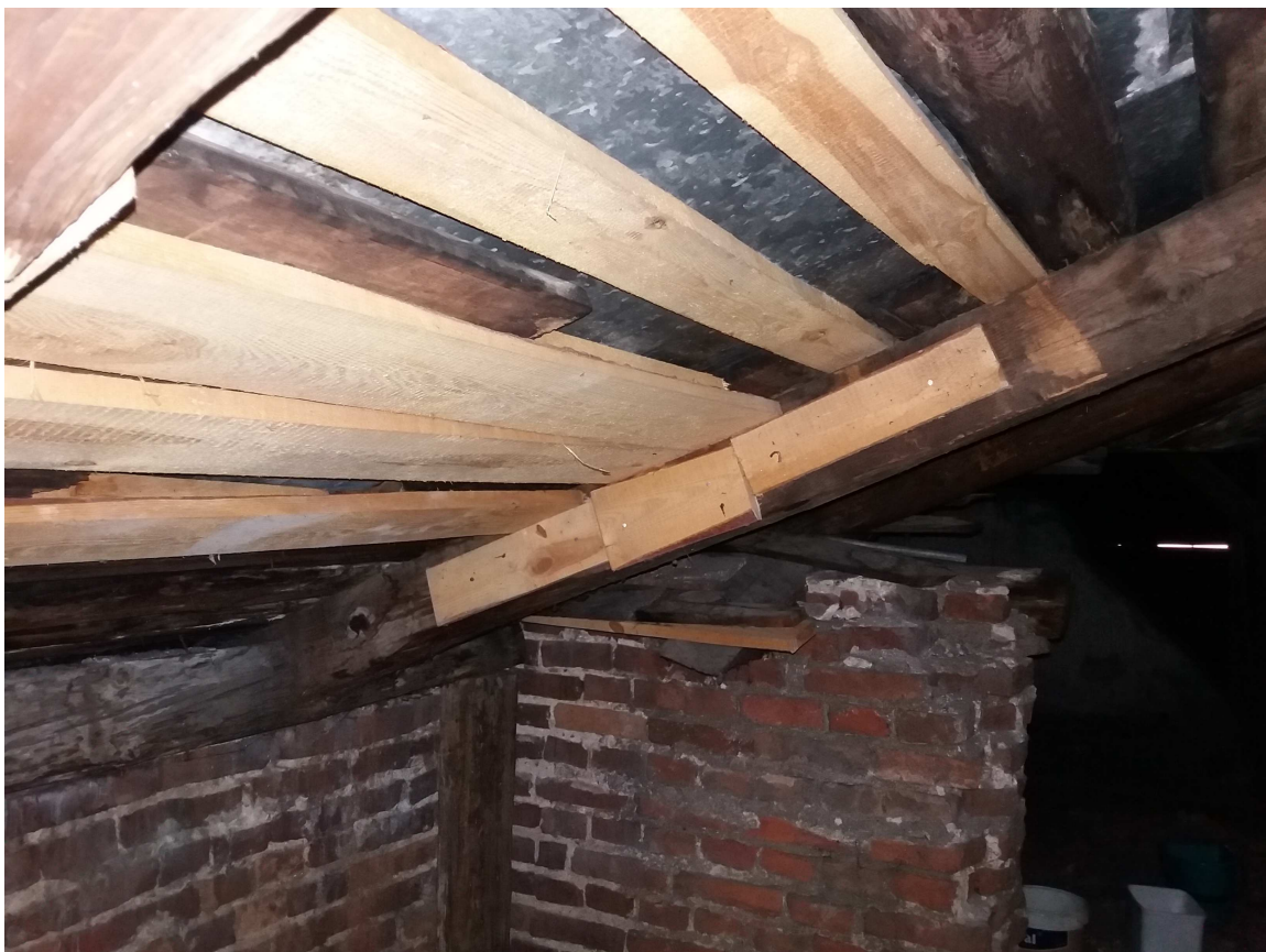
Fot.13 Część główna dachu- liczne uzupełnianie deskowań
