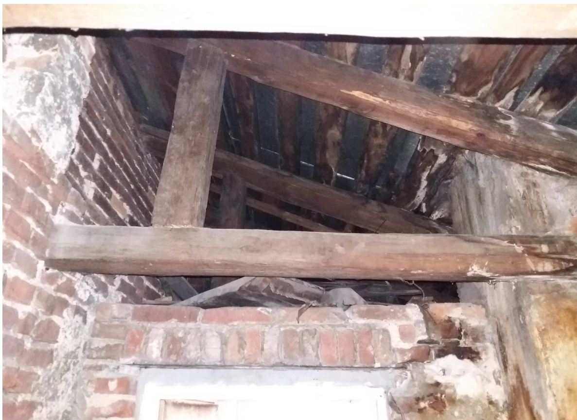
Fot.7 Oficyna-zawilgocenie deskowania
