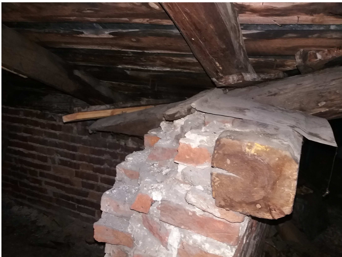
Fot.10 Część główna dachu- brak podparcia dla krokwi na murze
