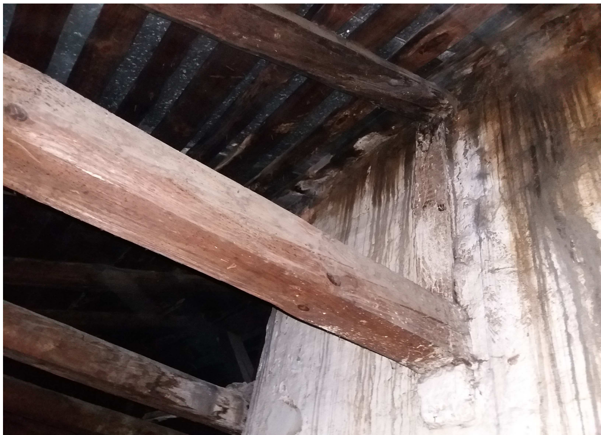
Fot.14 Część główna dachu- liczne zacieki na ścianach kominów
