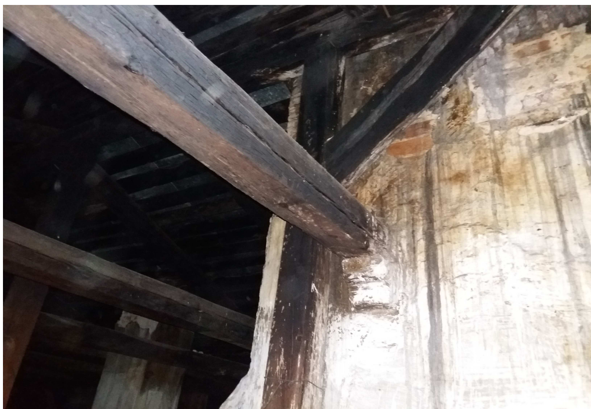
Fot.17 Część główna dachu- obszar PP-wzdłużne pęknięcie i przekoszenie jętki
