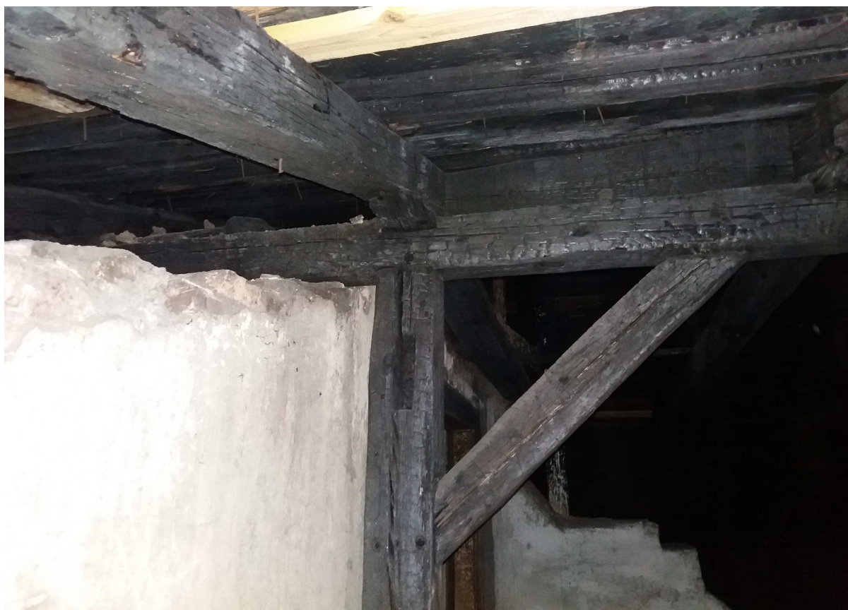
Fot.16 Część główna dachu- obszar PP-spękania elementów konstrukcji; deformacja miecza słupa
