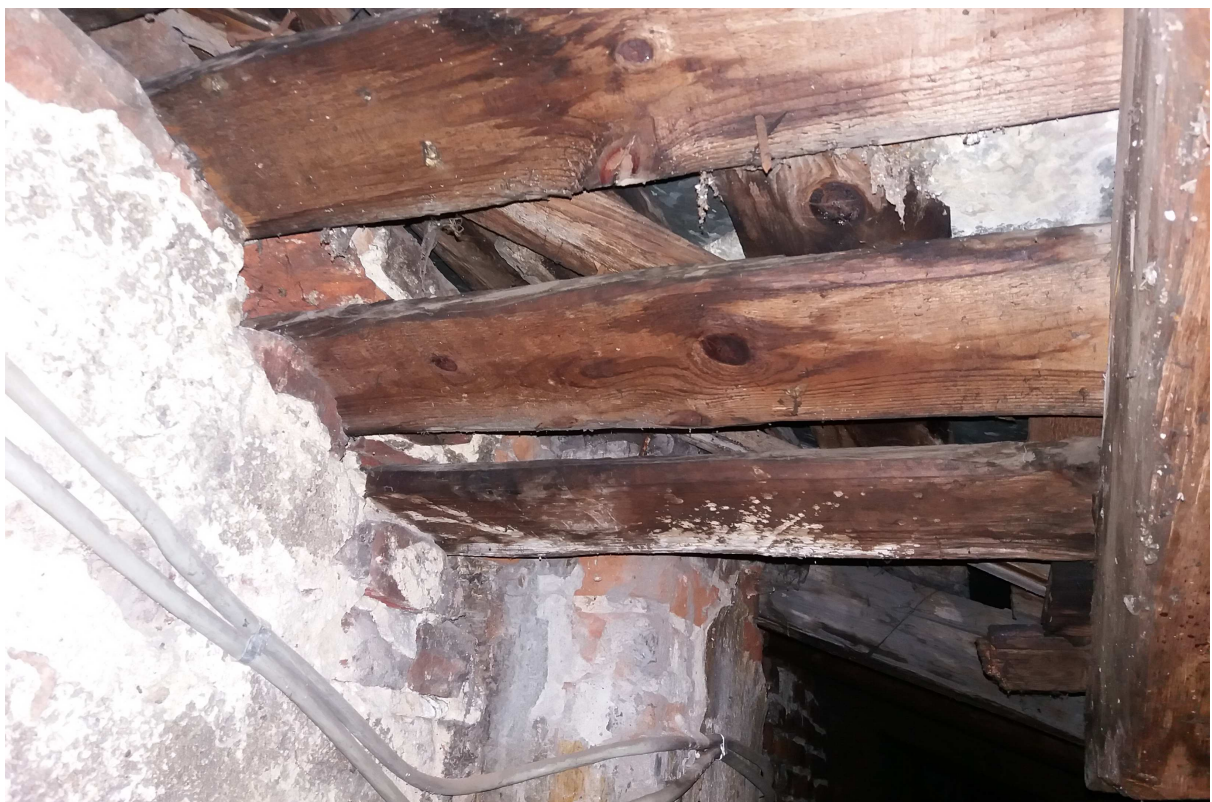
Fot.12 Część główna dachu- wadliwie wykonane deskowanie
