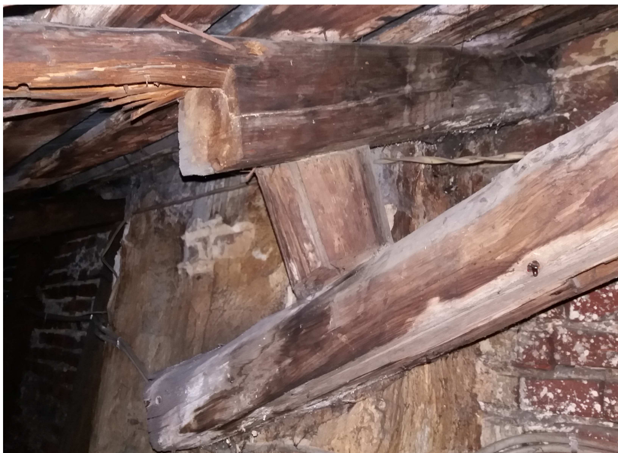
Fot.8 Oficyna-zagryzione elementy węzła-podparcie belki koszowej
