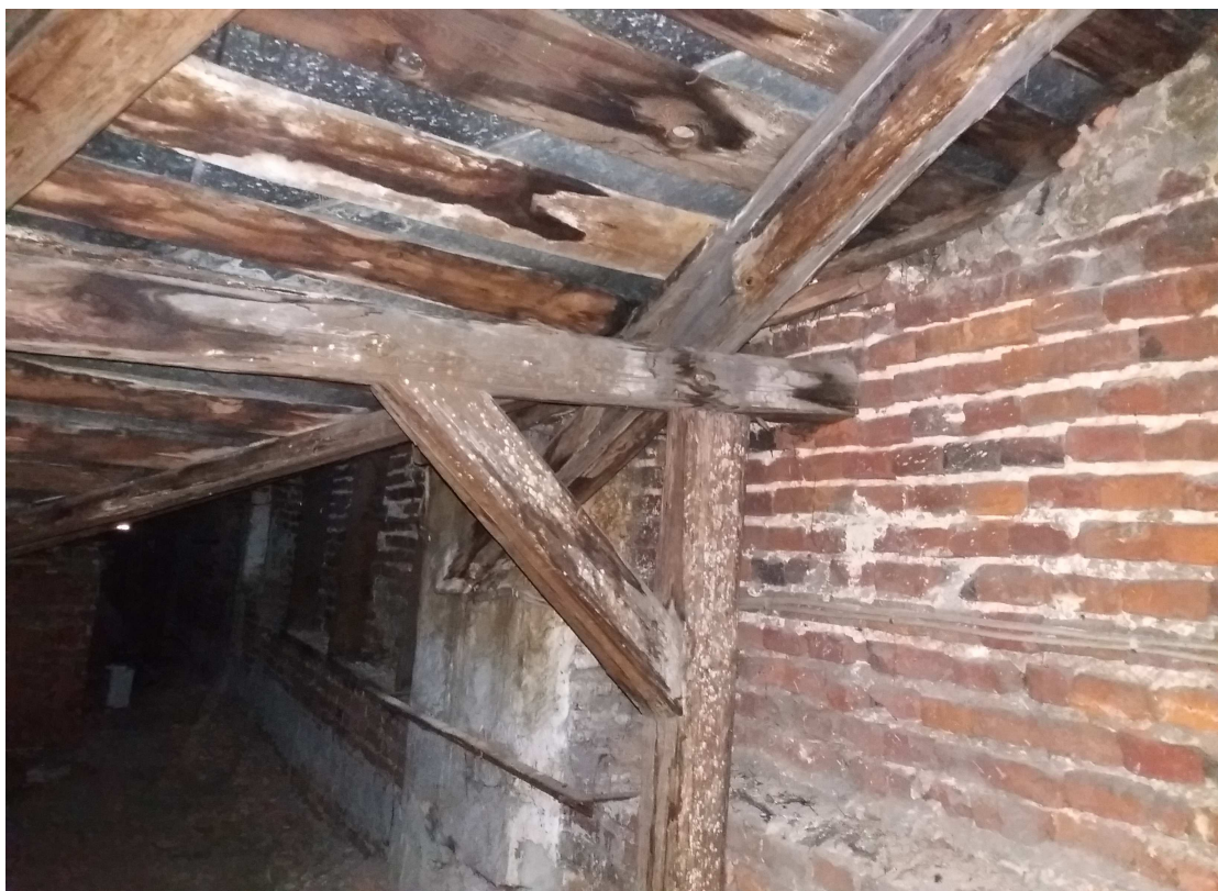
Fot.4 Oficyna-liczne zacieki w dachu; zagrzybienie elementów konstrukcji-krokwie, miecz słupa oraz słup
