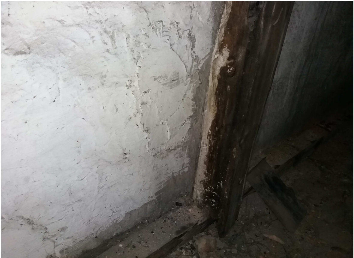
Fot.21 Część główna dachu- obszar PP-podłużne pęknięcia elementów,zdeformowana podwalina w obrębie słupa S1
