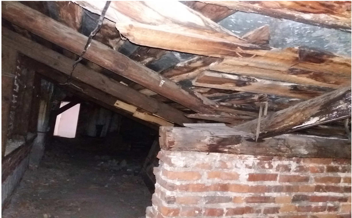
Fot.11 Część główna dachu- przekoszona murlata w murze;brak krokwi koszowej,brak połączenia deskowania
