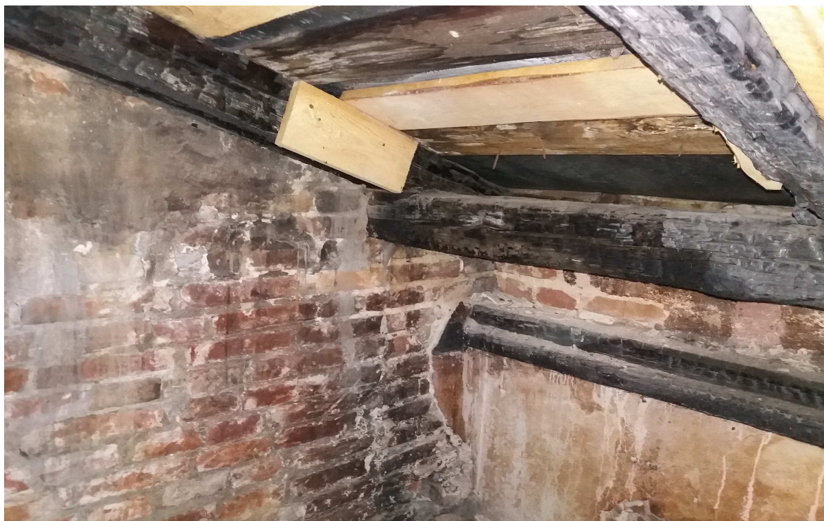
Fot.15 Część główna dachu- liczne ubytki tynków; zawilgocenie ścian kolankowych
