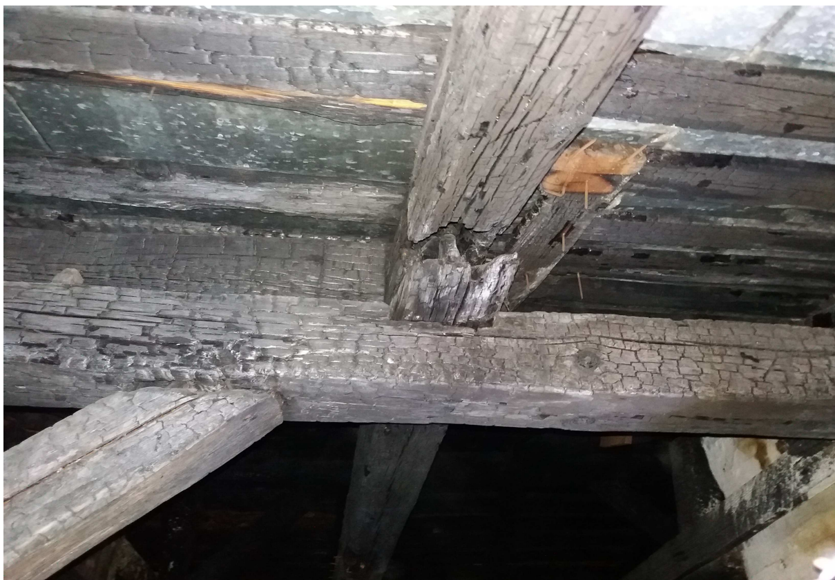
Fot.17 Część główna dachu- obszar PP-przerwanie ciągłości krokwi
