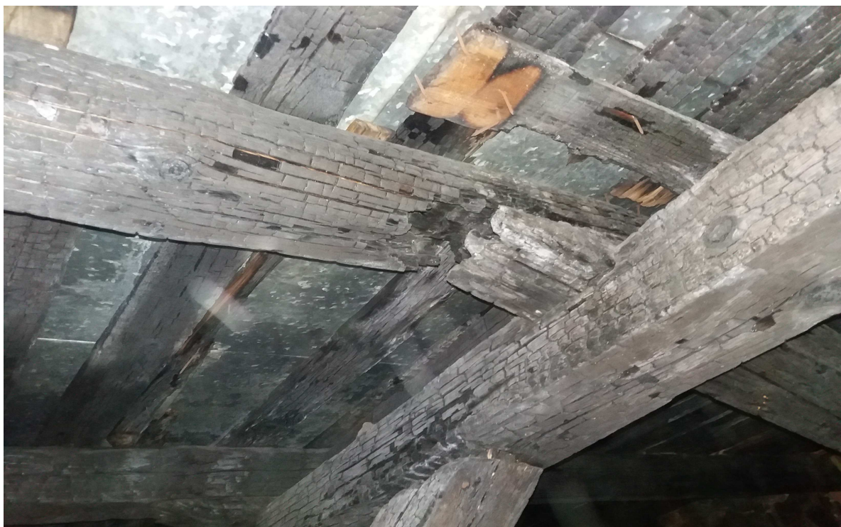
Fot.21 Część główna dachu- obszar PP-podłużne pęknięcia elementów,przerwana krokiew
