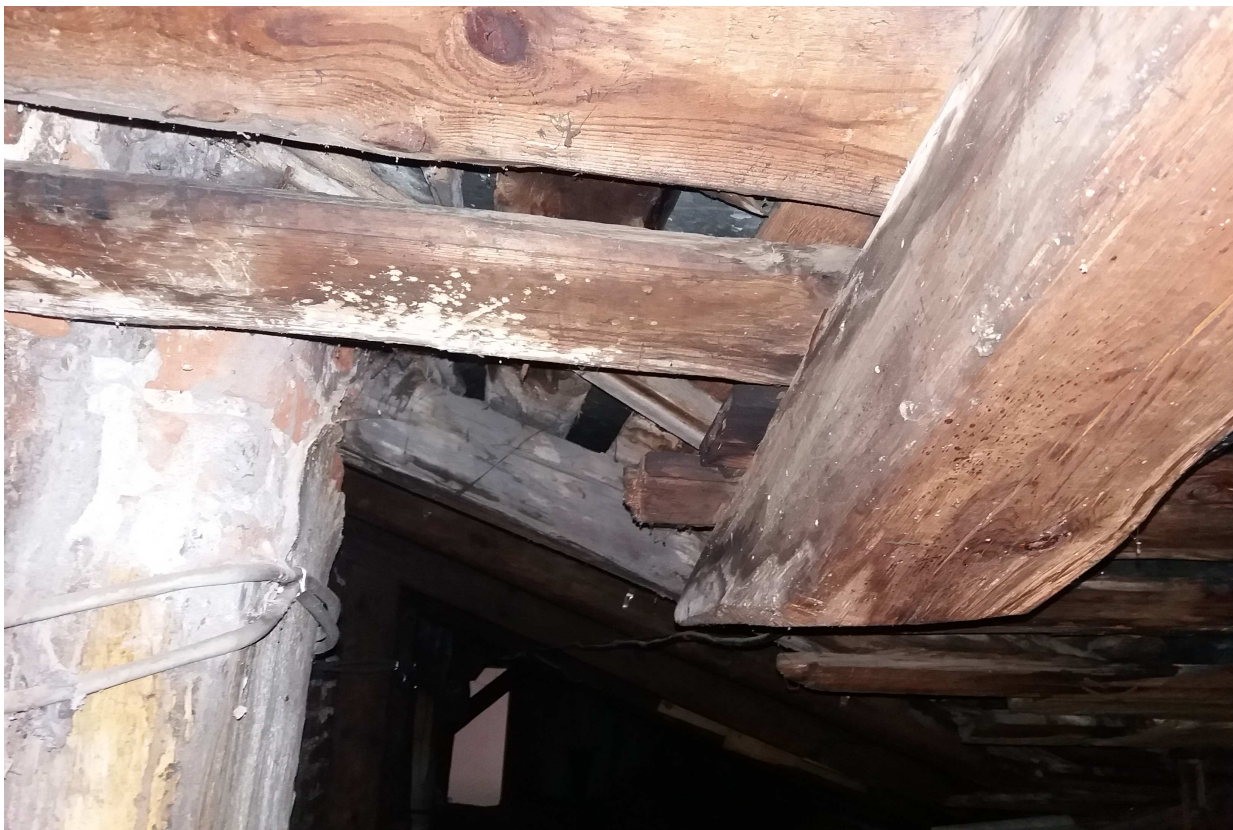
Fot.9 Część główna dachu-brak podparcia belki koszowej
