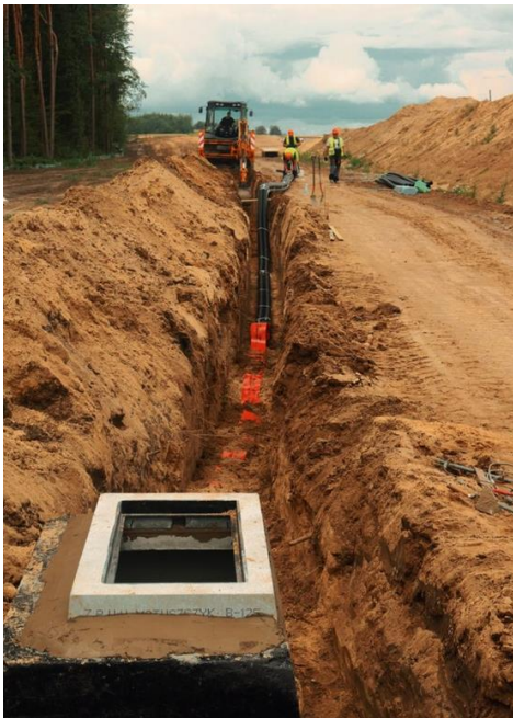
Rys. 34. Zamontowana studzienka kablowa
