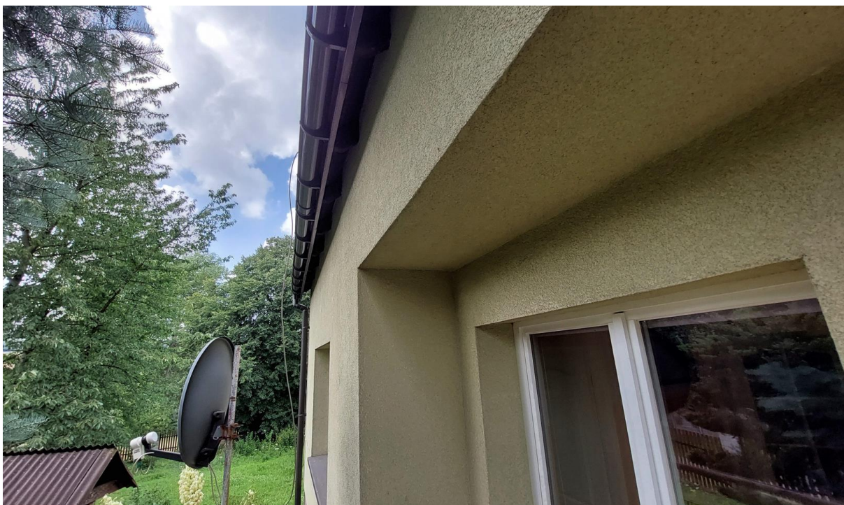
Fot. 4 Wnęka do zabudowy szklaną fasadą.
