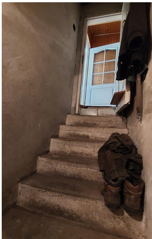
Fot. 6 Schody piwniczne – zamurowanie otworu w stropie.
