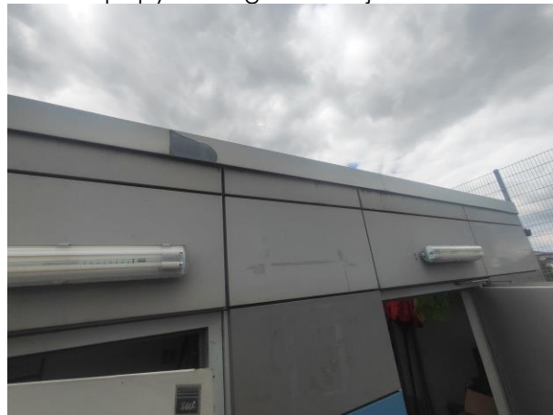
Ubytki w farbie na obróbce blacharskiej budynku kontenerowego.
