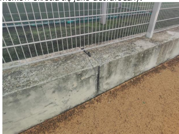
Zabrudzenia na murze oraz skruszenia muru oporowego na dylatacji.
