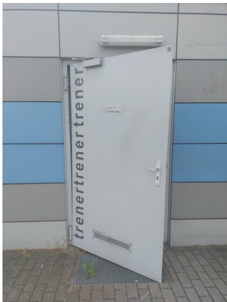
Wyrwane skrzydło drzwiowe z zawiasu górnego
