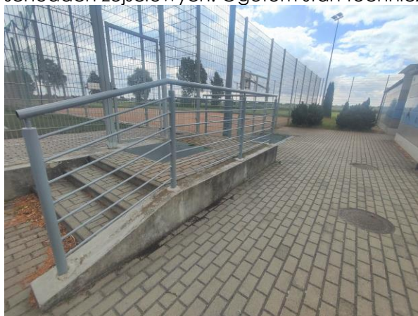
Zabrudzenia na murze oraz skruszenia muru oporowego na dylatacji.
