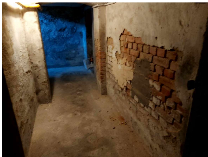
zdjęcie nr 9 – Zawilgocenie i ubytki tynku wraz fugą na ścianach wewnętrznych i zewnętrznych piwnicy
