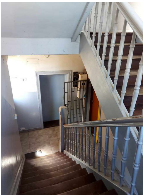
zdjęcie nr 5 – Wewnętrzna klatka schodowa od poziomu parteru ze schodami i balustradami w konstrukcji drewnianej.
