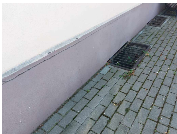
zdjęcie nr 12, 13 – Pomiary drobnych zarysowań na ścianach nośnych na poziomie parteru
