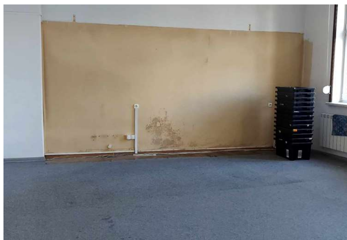
zdjęcie nr 10 – Zawilgocenie ścian zewnętrznych na poziomie parteru
