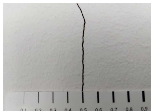
zdjęcie nr 12, 13 – Pomiary drobnych zarysowań na ścianach nośnych na poziomie parteru
