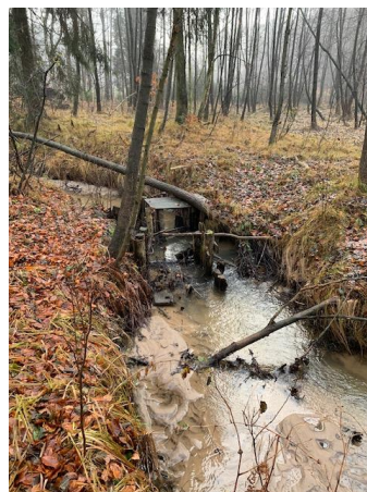
Fot. 4 Zniszczona zastawka. Jej odtworzenie nie będzie konieczne dzięki wytworzeniu nowego układu bystrze-płoso i meandrów, na wyższej rzędnej [fot. Jacek Zalewski]
