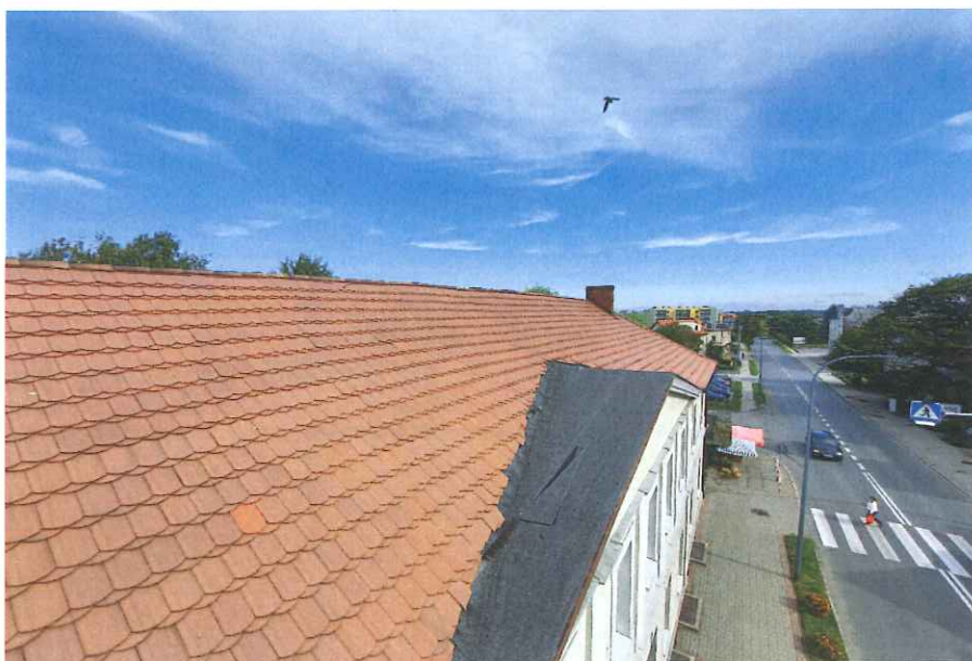
Kosze od strony ulicy Kaliskiej z powodu braku mocowania dachówek do łąt wypadają i wysuwają się z połaci dachowej.
