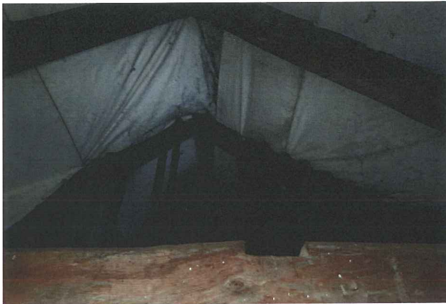
Zdjęcia przedstawiają ułożenie membrany na połaci dachowej , widoczne Obwisy, zagięcia, brak właściwego zamocowania i ułożenia , a także całe kolonie grzybów na przestrzeni membrana dachówka ceramiczna.
