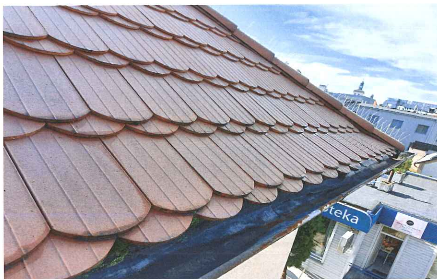
Zdjęcia przedstawiają ułożenie membrany na połaci dachowej , widoczne Obwisy, zagięcia, brak właściwego zamocowania i ułożenia , a także całe kolonie grzybów na przestrzeni membrana dachówka ceramiczna.
