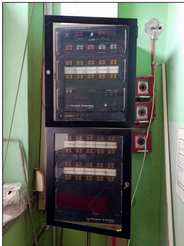
Centra systemu SSP na parterze
