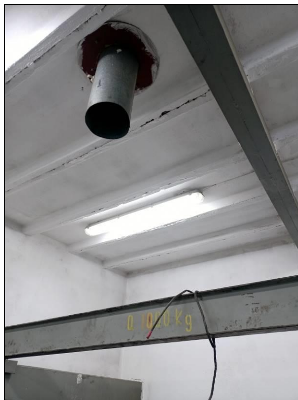
Wentylacja, oświetlenie, belka montażowa w maszynowni
