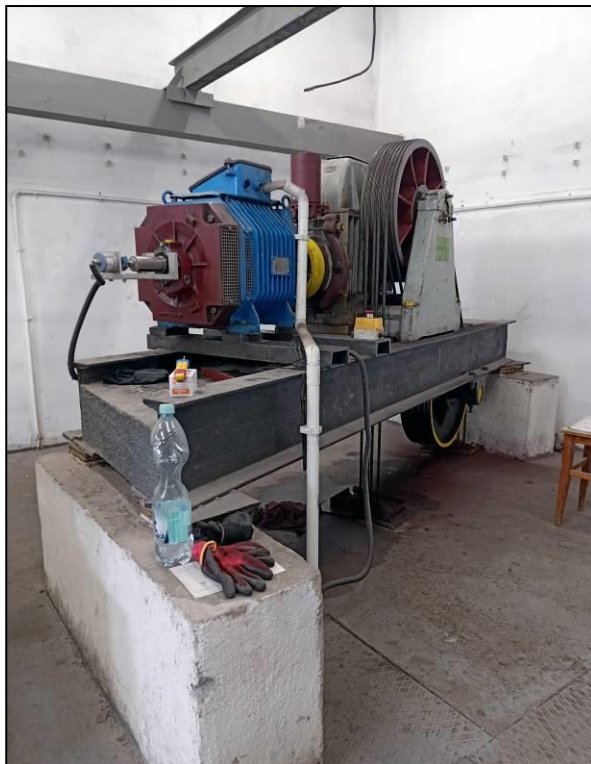
Zespół napędowy w maszynowni
