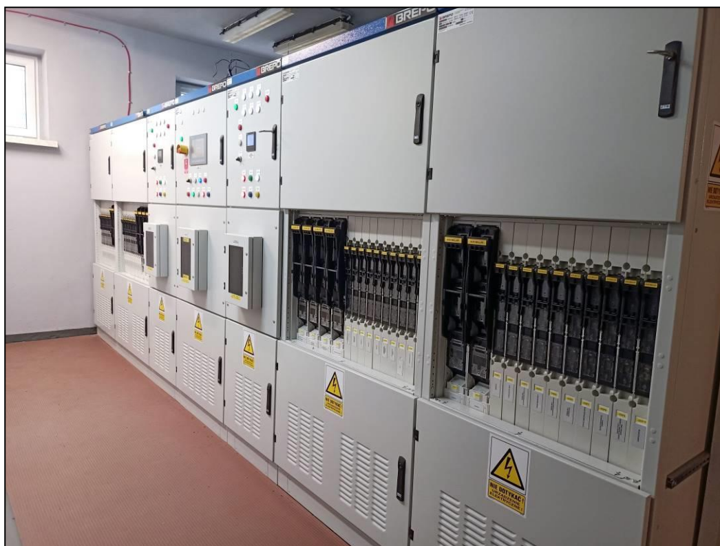
Rozdzielnia główna w piwnicy
