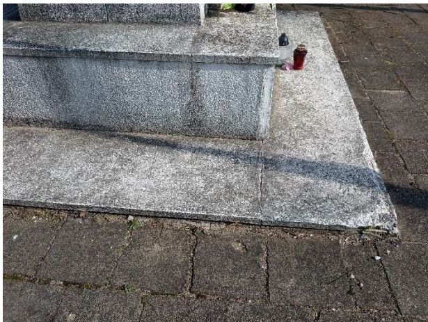
Fot. 2. Ubytki w podstawie
