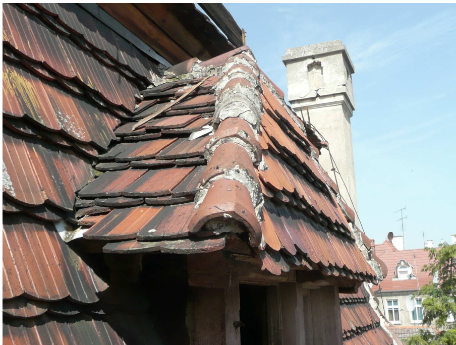
Fot. 15 – Widok daszku nad lukarną oraz zwieńczenia komina nr 1. Widoczna dezintegracja pokrycia dachówkowego oraz uszkodzenia głowicy komina.
