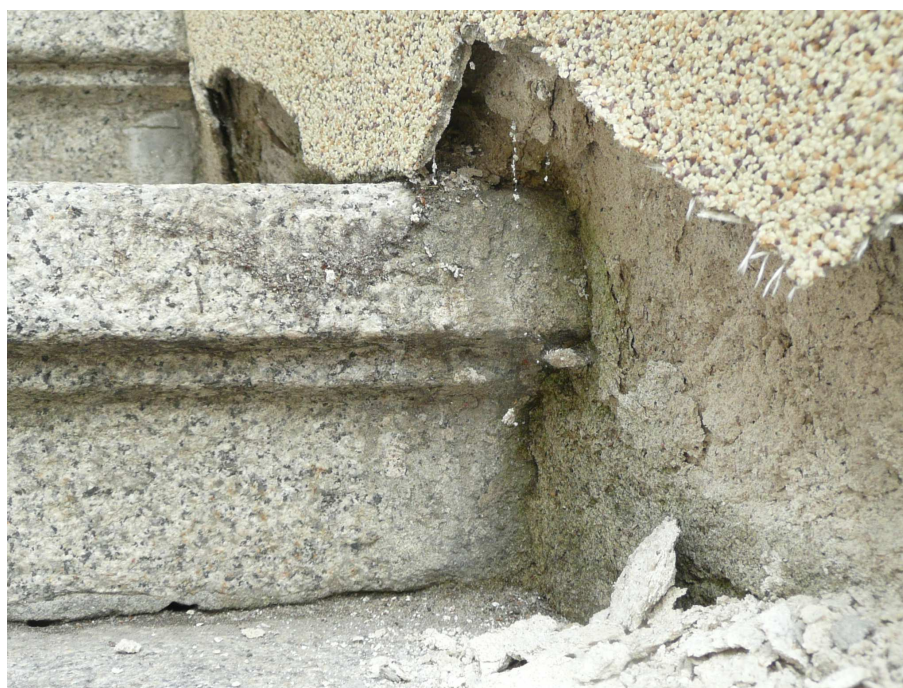
Fot. 24 – „Odparzenie” tynku żywicznego na murze balustrady schodowej.
