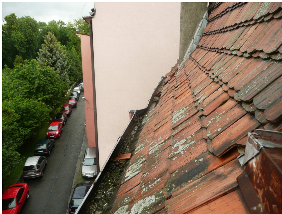
Fot. 13 – Widok fragmentu połaci zachodniej. Widoczne zabrudzenie oraz porażenie dachówek przez glony, zanieczyszczenie i deformacje rynien oraz korozję obróbki okna lukarny.
