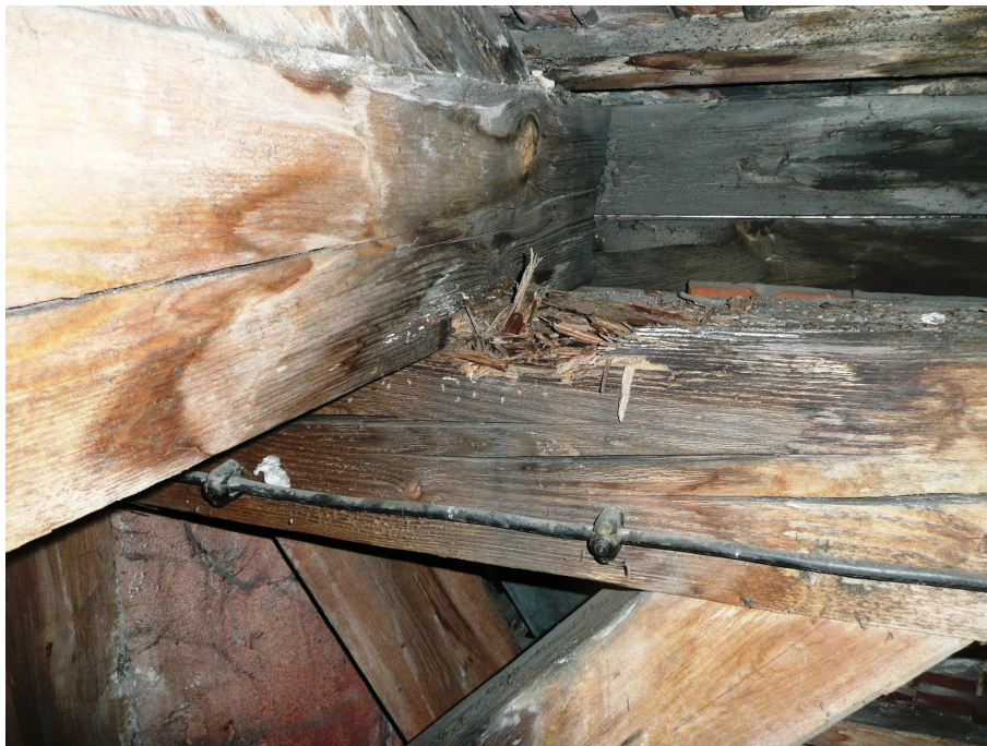
Fot. 7 – Porażenie przez grzyba domowego tramu oraz płatwi /porażenie nr 16/
