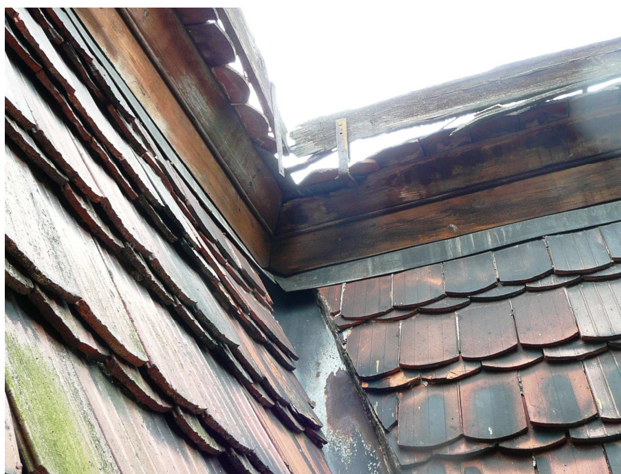
Fot. 14 – Widok fragmentu połaci północnej. Widoczne zabrudzenie oraz porażenie dachówek przez glony, korozję obróbki koszowej oraz desek śniegołapów.
