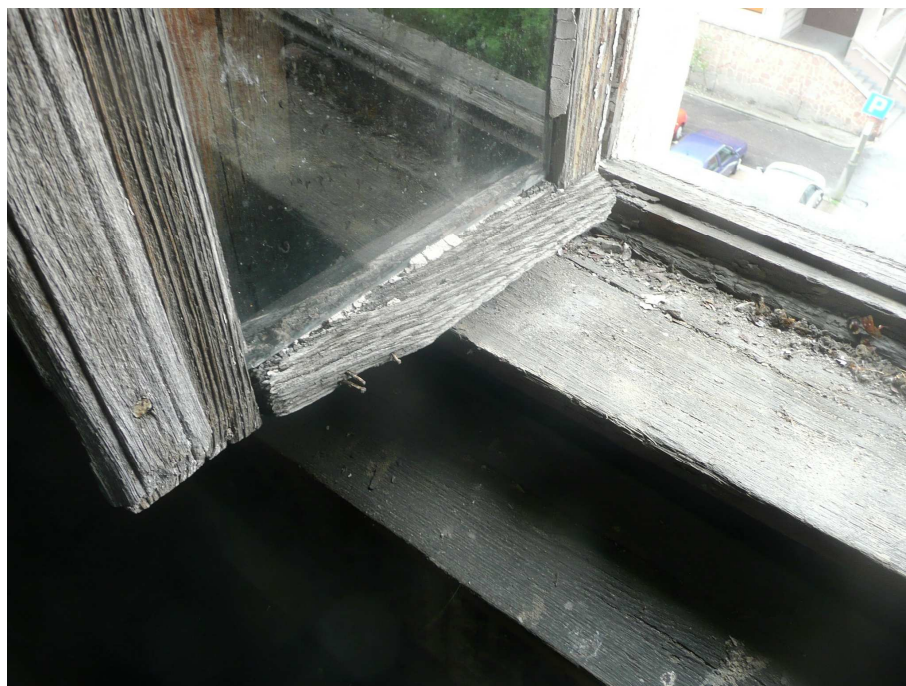
Fot. 17 – Korozja okna krosnowego lukarny.
