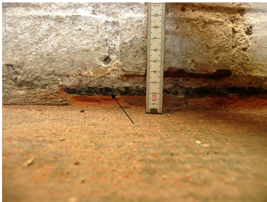
Fot. 20 – Izolacja pozioma „dolna” ściany zewnętrznej piwnic . Widok od strony korytarza piwnicznego.
