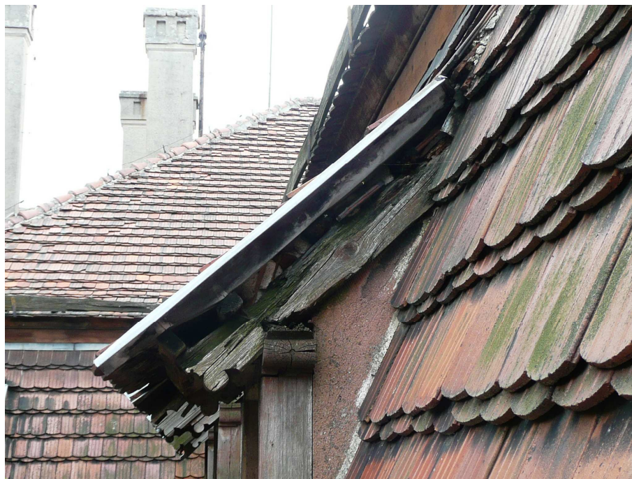
Fot. 11 – Porażenie przez grzyba domowego krokwi i płatwi lukarny /porażenie nr 39/
