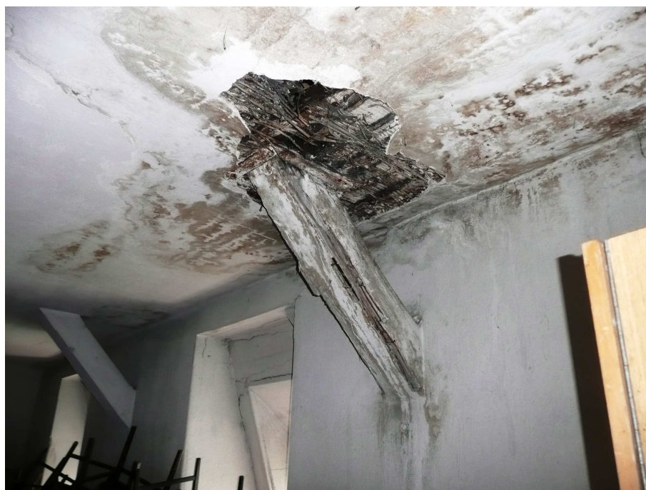
Fot. 12 – Zacieki na sufitach pomieszczenia strychowego. Widoczne ubytki tynku sufitu
