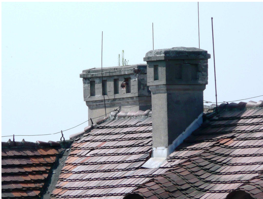
Fot. 16 – Spękania głowic kominów nr 13 i 15.
