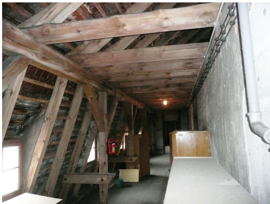
Fot. 5 – Korytarz strychu. Widoczny fragment więźby dachowej. Widoczne elementy połączeń dolnej i górnej mansardy.
