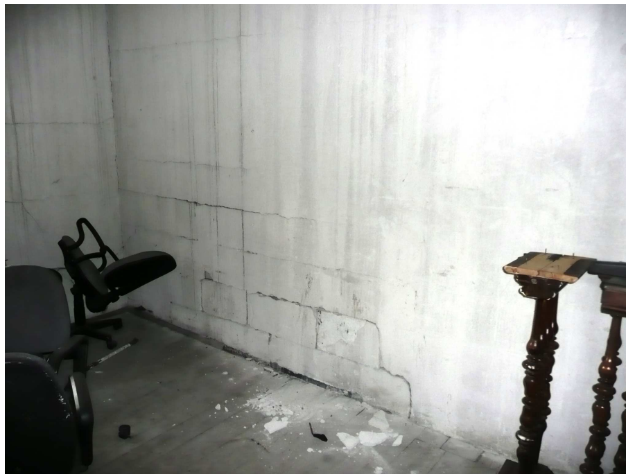
Fot. 25 – Spękanie ścianki działowej na strychu
