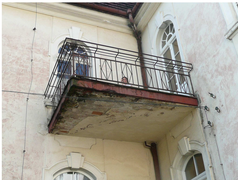
Fot. 18 – Widok płyty balkonowej. Widoczne uszkodzenia płyty oraz belek balkonowych.
