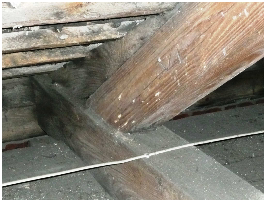
Fot. 9 – Widok porażonej końcówki krokwi przez owada /porażenie nr 35/
