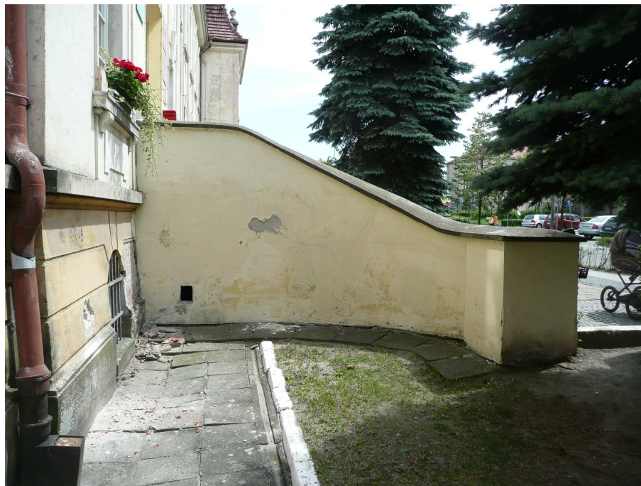
Fot. 23 – Balustrada zachodnia schodów. Widoczne zarysowania oraz zasolenie tynków
