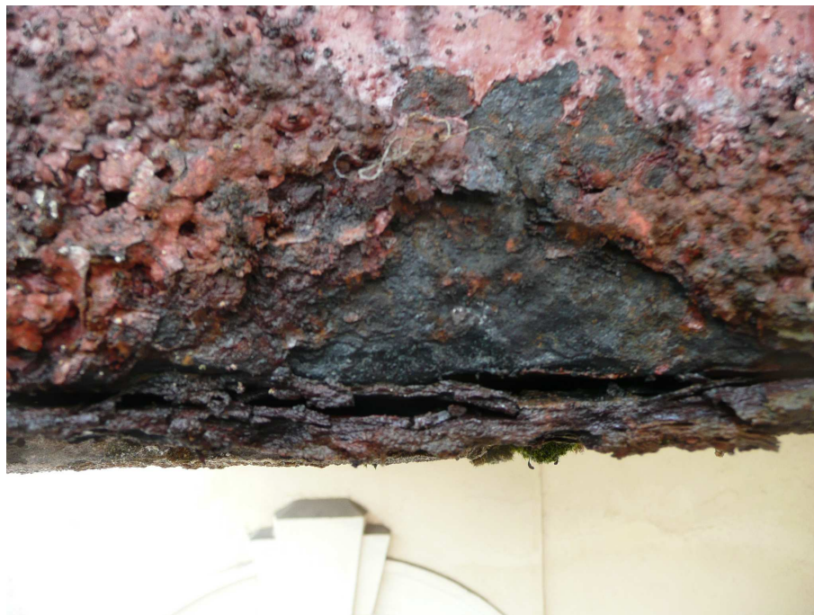
Fot. 19 – Skorodowanie stopki dolnej belki nośnej balkonu.
