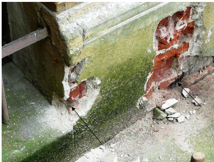
Fot. 21 – Izolacja pozioma „górna” oraz pionowa ściany zewnętrznej piwnic .
