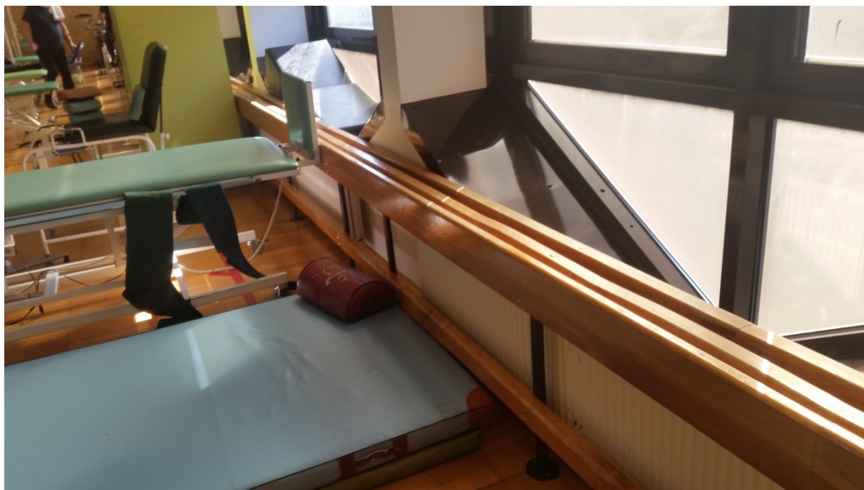
Rys. 32. Okna sali gimnastycznej do częściowego zamurowania, fot. Ireneusz Smal, 2022
