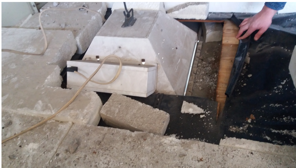
Rys. 18. Fragment sufitu podwieszanego nad halą basenową, widoczna istniejąca izolacja termiczna oraz istniejące oświetlenie, fot. Ireneusz Smal, 2022
