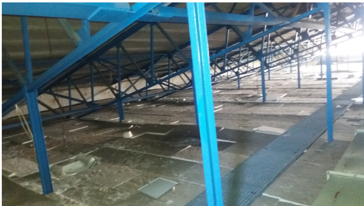
Rys. 15. Konstrukcja stalowa sufitu podwieszanego nad halą basenową, widoczna istniejąca izolacja termiczna i kanały wentylacyjne, fot. Ireneusz Smal, 2022
