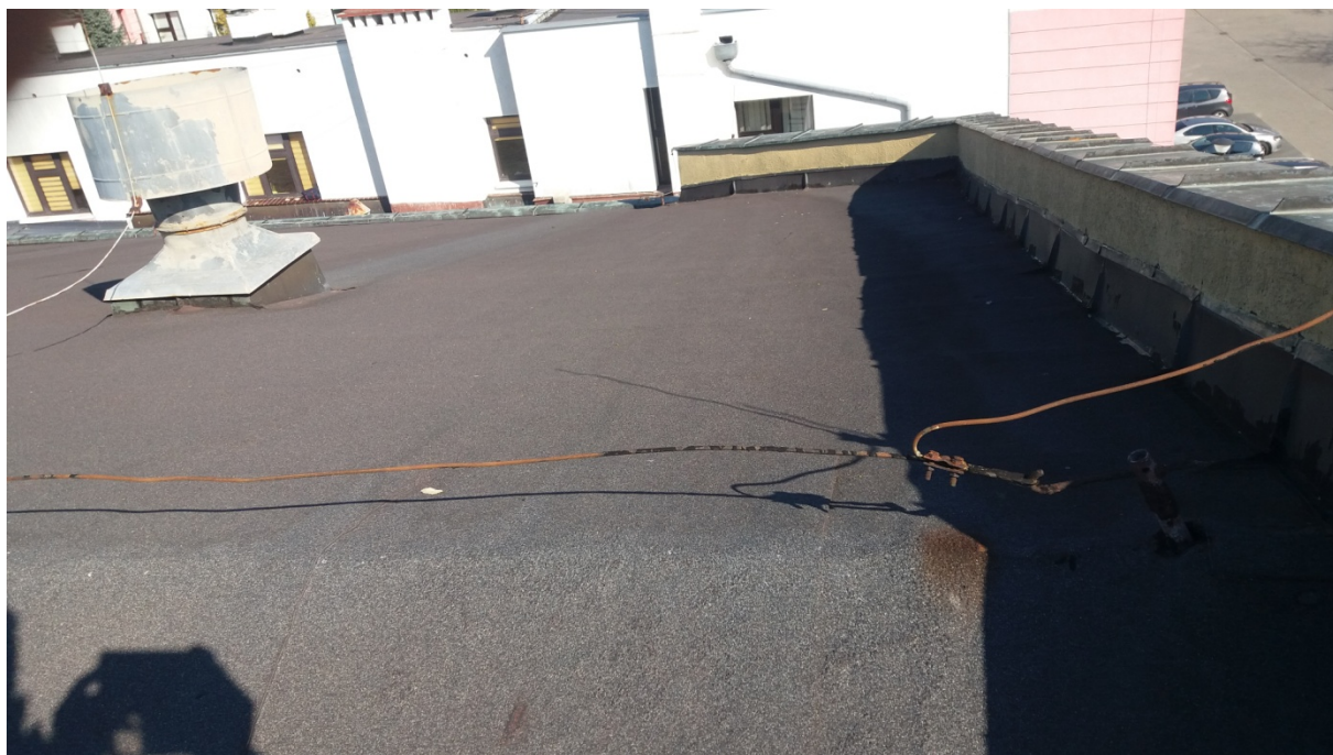
Rys. 24. Istniejąca instalacja odgromowa dachu basenu, fot. Ireneusz Smal, 2022
