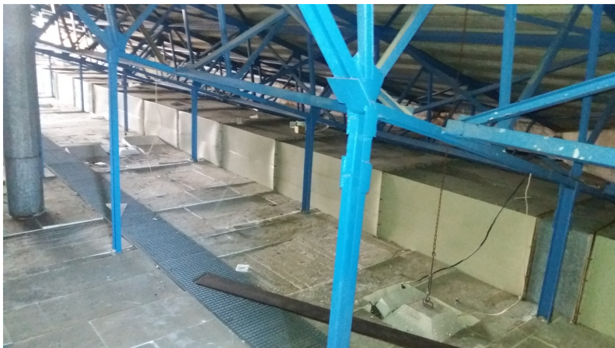
Rys. 14. Konstrukcja stalowa sufitu podwieszanego nad halą basenową, widoczna istniejąca izolacja termiczna i kanały wentylacyjne, fot. Ireneusz Smal, 2022
