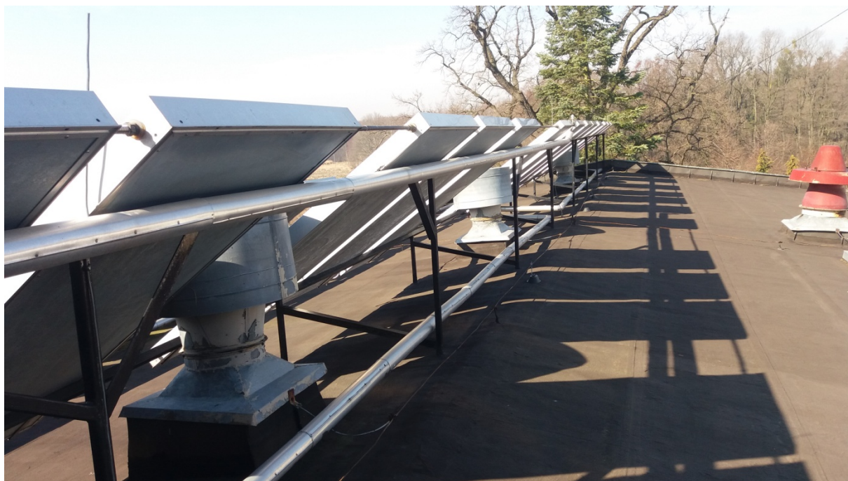
Rys. 12. Pokrycie dachu cz. wysoka sali gimnastycznej wraz z kolektorami słonecznymi i konstrukcją wsporczą, fot. Ireneusz Smal, 2022
