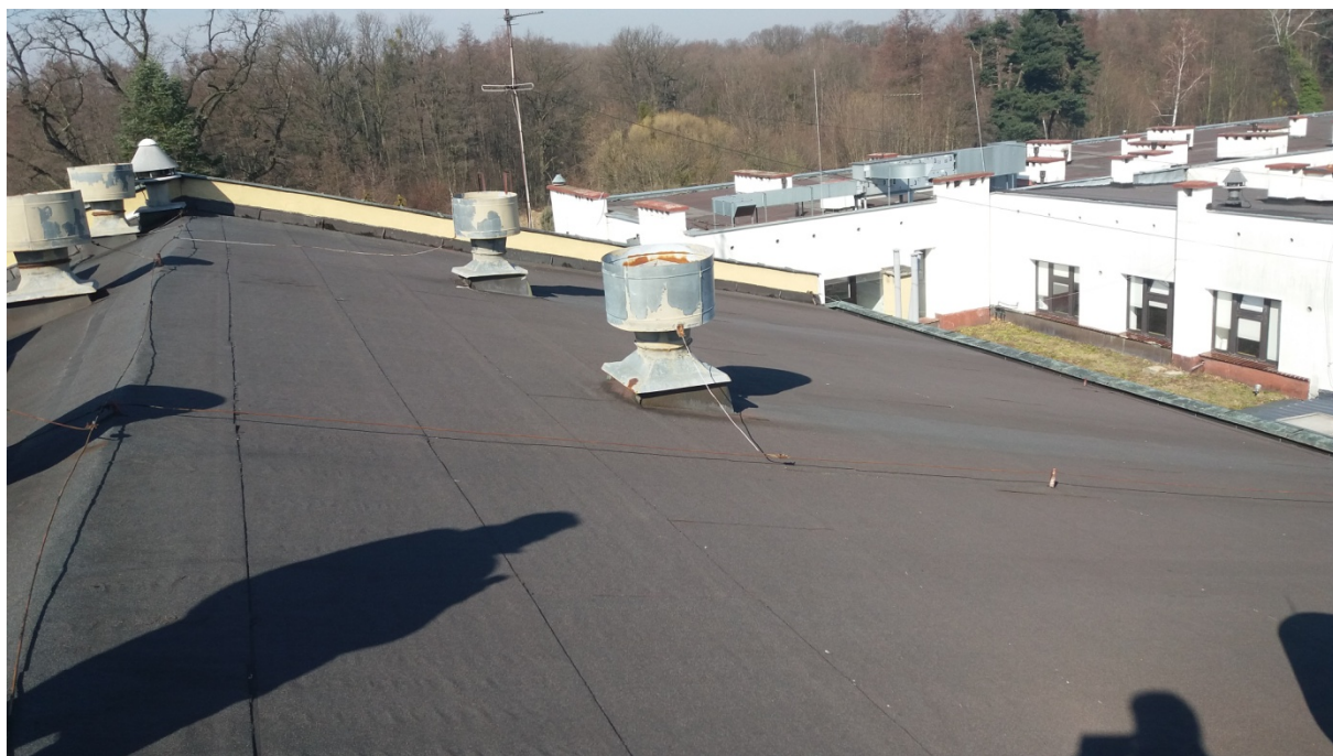
Rys. 25. Istniejąca instalacja odgromowa dachu basenu, fot. Ireneusz Smal, 2022
