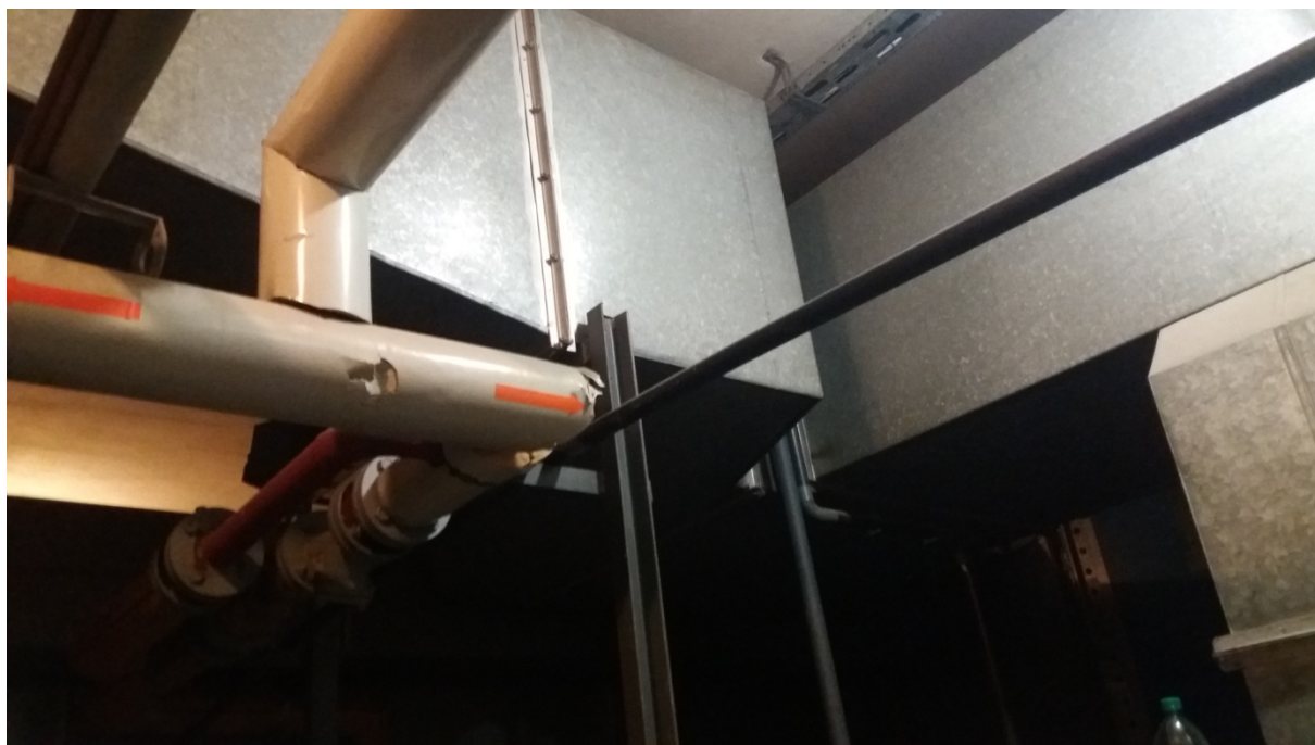
Rys. 30. Kanały wentylacyjne do częściowej wymiany, fot. Ireneusz Smal, 2022
