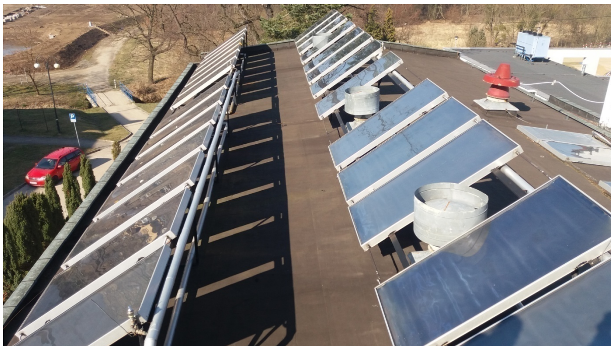
Rys. 21. Pokrycie dachu basenu wraz z kolektorami słonecznymi i konstrukcją wsporczą na południowej pości, fot. Ireneusz Smal, 2022
