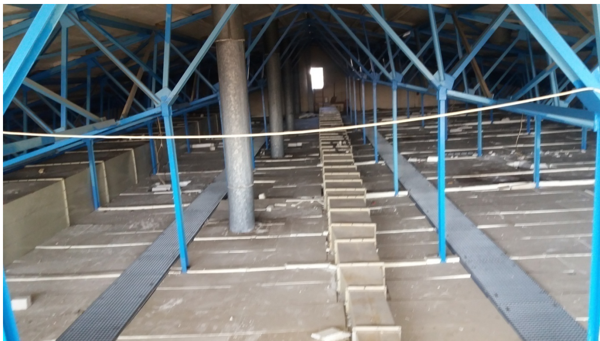
Rys. 17. Konstrukcja stalowa sufitu podwieszanego nad halą basenową, widoczna istniejąca izolacja termiczna i kanały wentylacyjne, fot. Ireneusz Smal, 2022
