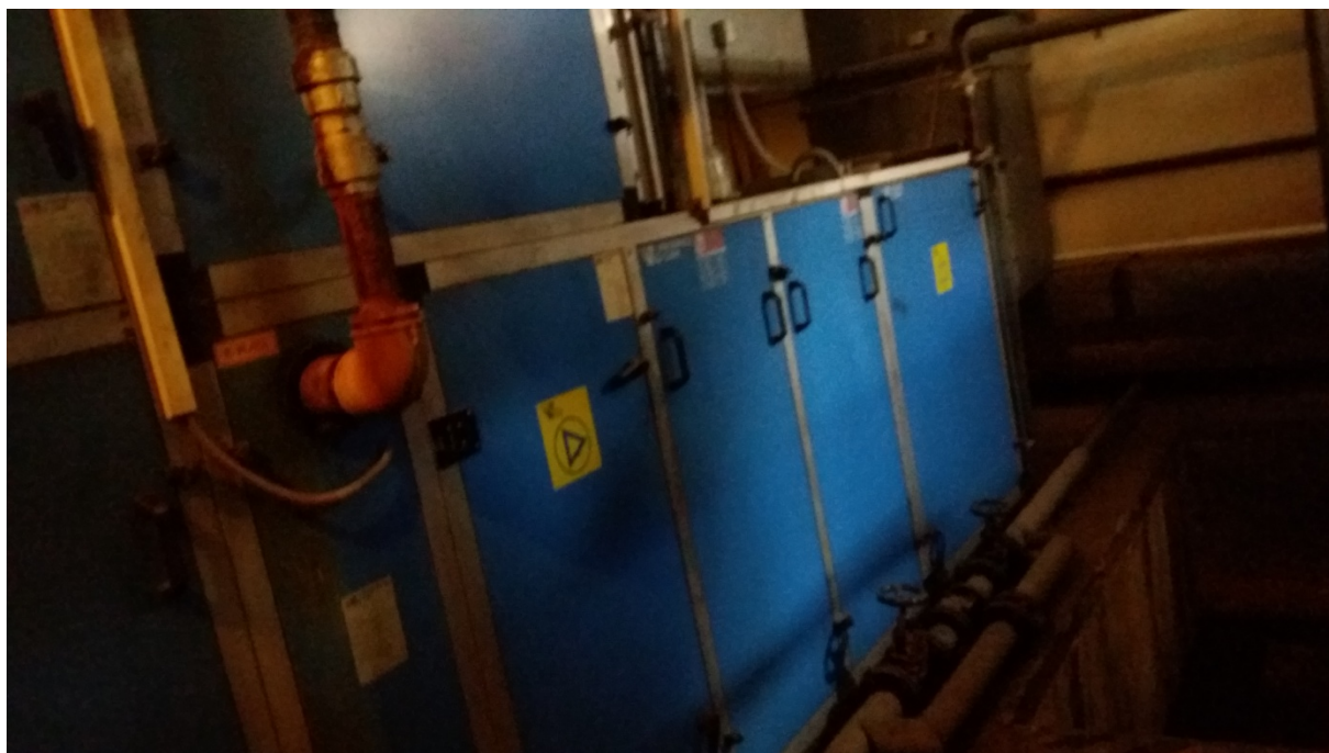
Rys. 31. Centrala wentylacyjna basenu (do wymiany), fot. Ireneusz Smal, 2022
