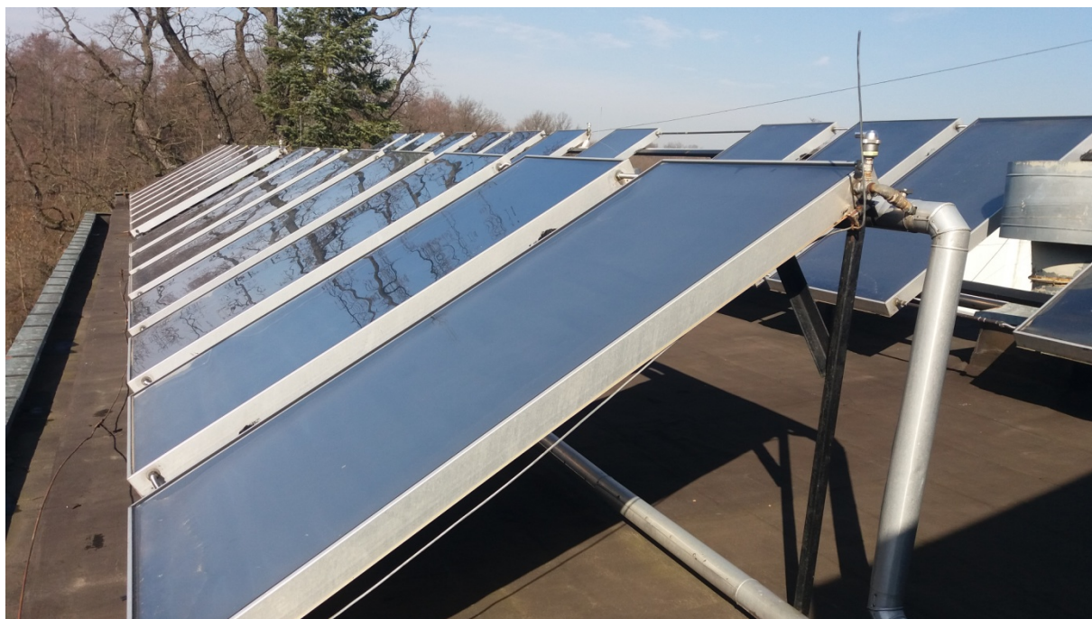
Rys. 13. Pokrycie dachu cz. wysoka sali gimnastycznej wraz z kolektorami słonecznymi i konstrukcją wsporczą, fot. Ireneusz Smal, 2022
