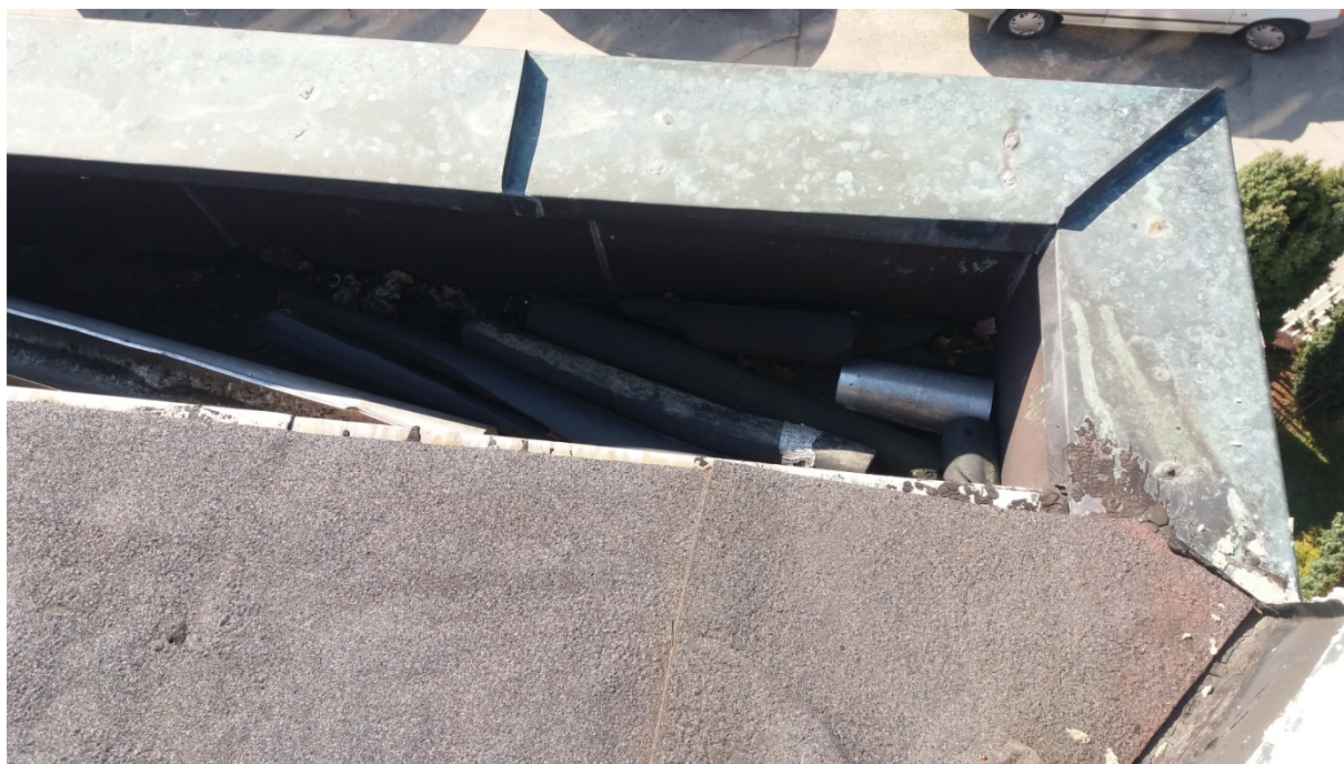
Rys. 22. Koryto odwadniające połąć południową dachu basenu, fot. Ireneusz Smal, 2022
