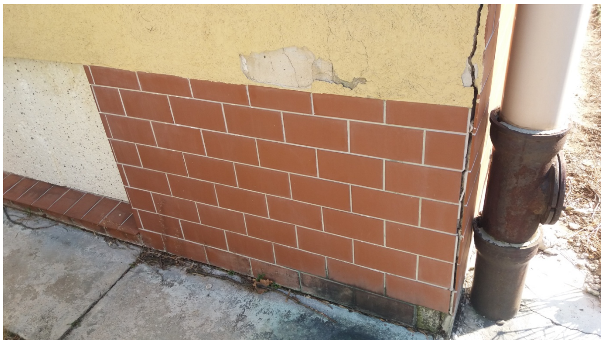
Rys. 8. Widoczne odspojenie tynku w narożu elewacji ściany szczytowej sali gimnastycznej, fot. Ireneusz Smal, 2022
