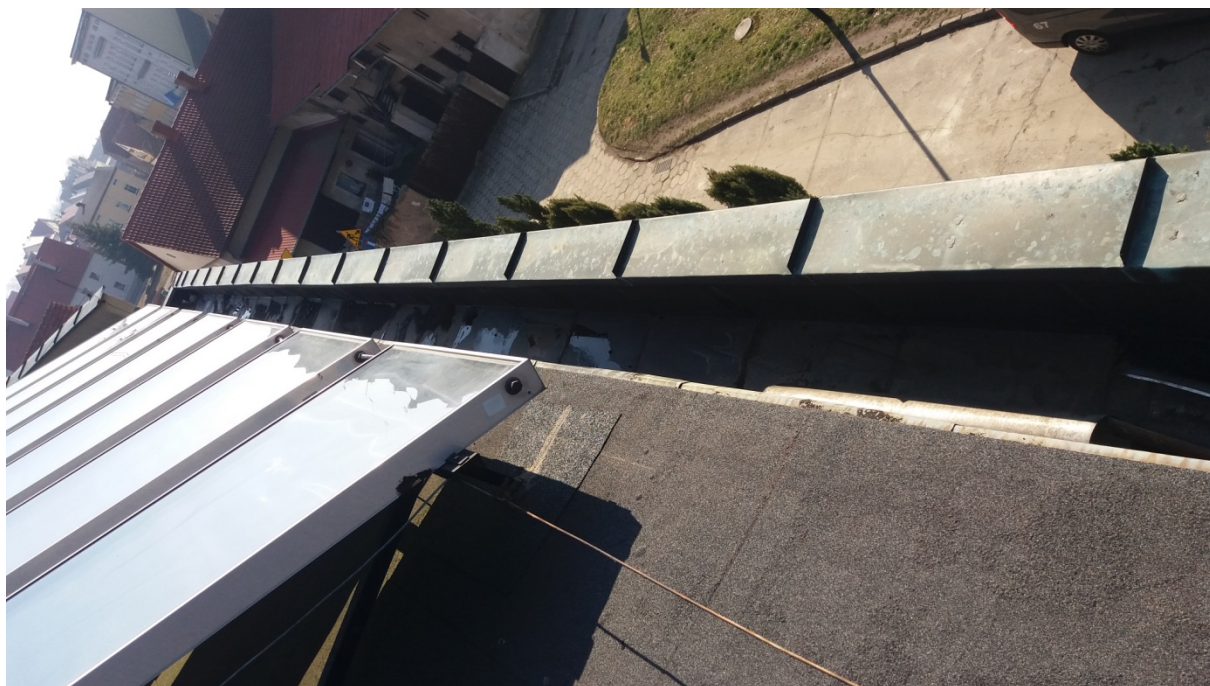
Rys. 23. Koryto odwadniające połąć południową dachu basenu, fot. Ireneusz Smal, 2022
