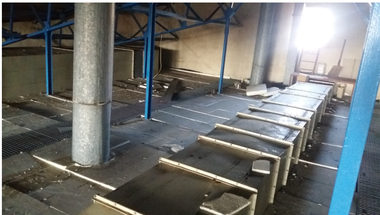
Rys. 16. Konstrukcja stalowa sufitu podwieszanego nad halą basenową, widoczna istniejąca izolacja termiczna i kanały wentylacyjne, fot. Ireneusz Smal, 2022
