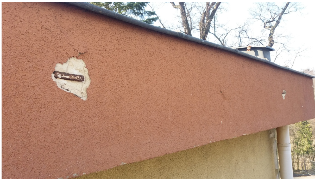
Rys. 28. Uszkodzenia wyprawy elewacyjnej koryta odwodnienia dachu cz. wysokiej sali gimnastycznej, fot. Ireneusz Smal, 2022
