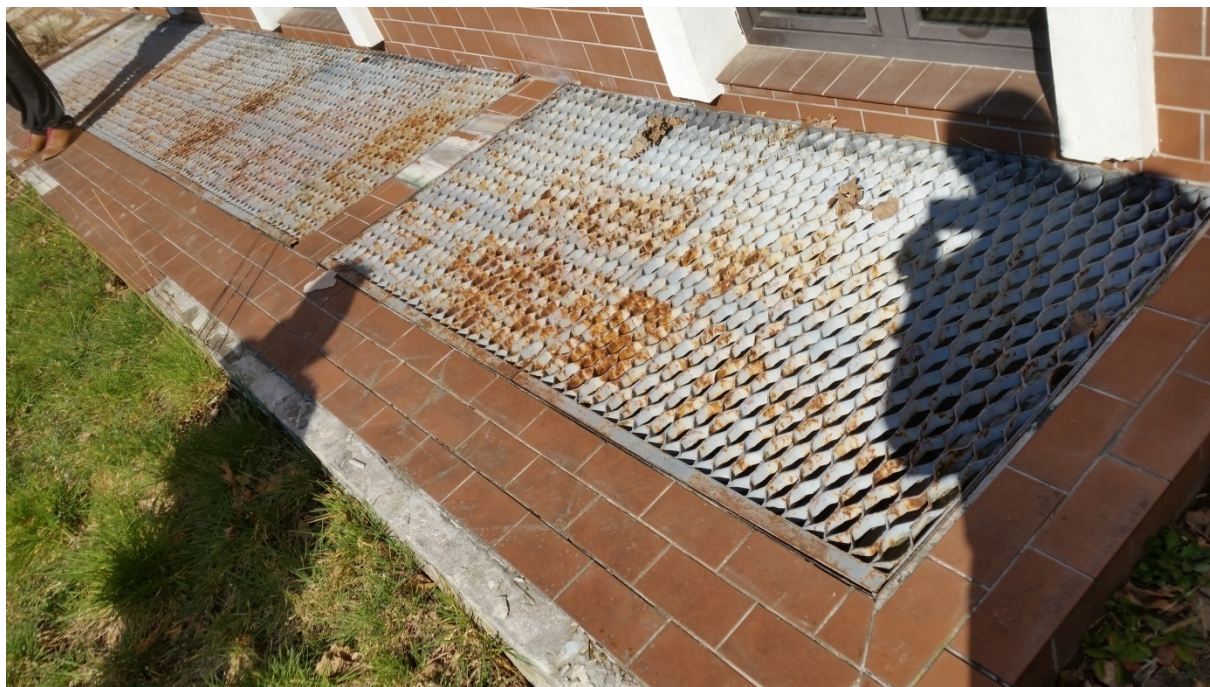
Rys. 6. Kraty wywiewne central wentylacyjnych na ścianie południowej sali gimnastycznej, fot. Ireneusz Smal, 2022
