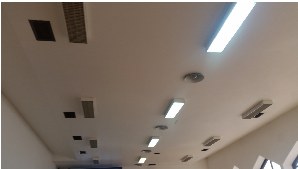
Rys. 34. Oświetlenie budynku sali gimnastycznej do wymiany na energooszczędne, fot. Ireneusz Smal, 2022
