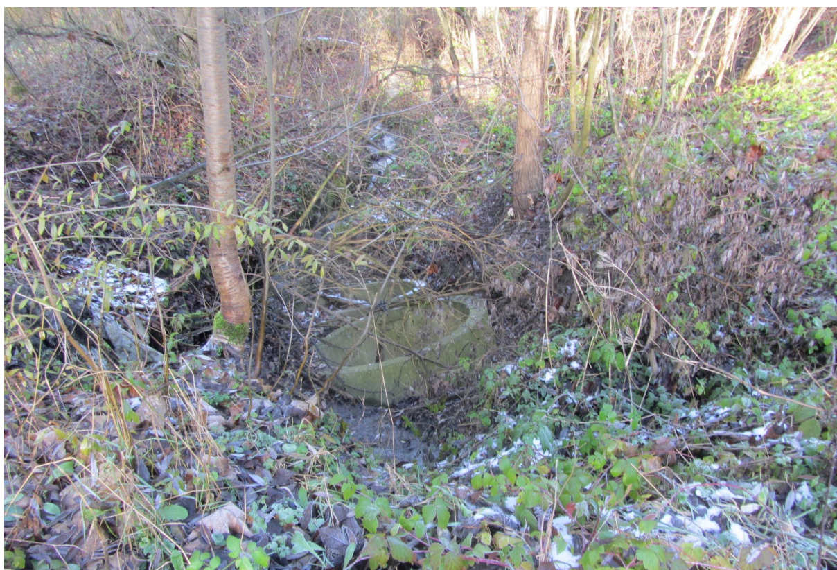
Fot.17 – Zniszczony przepustu na drodze dojazdowej do inklinometrów
