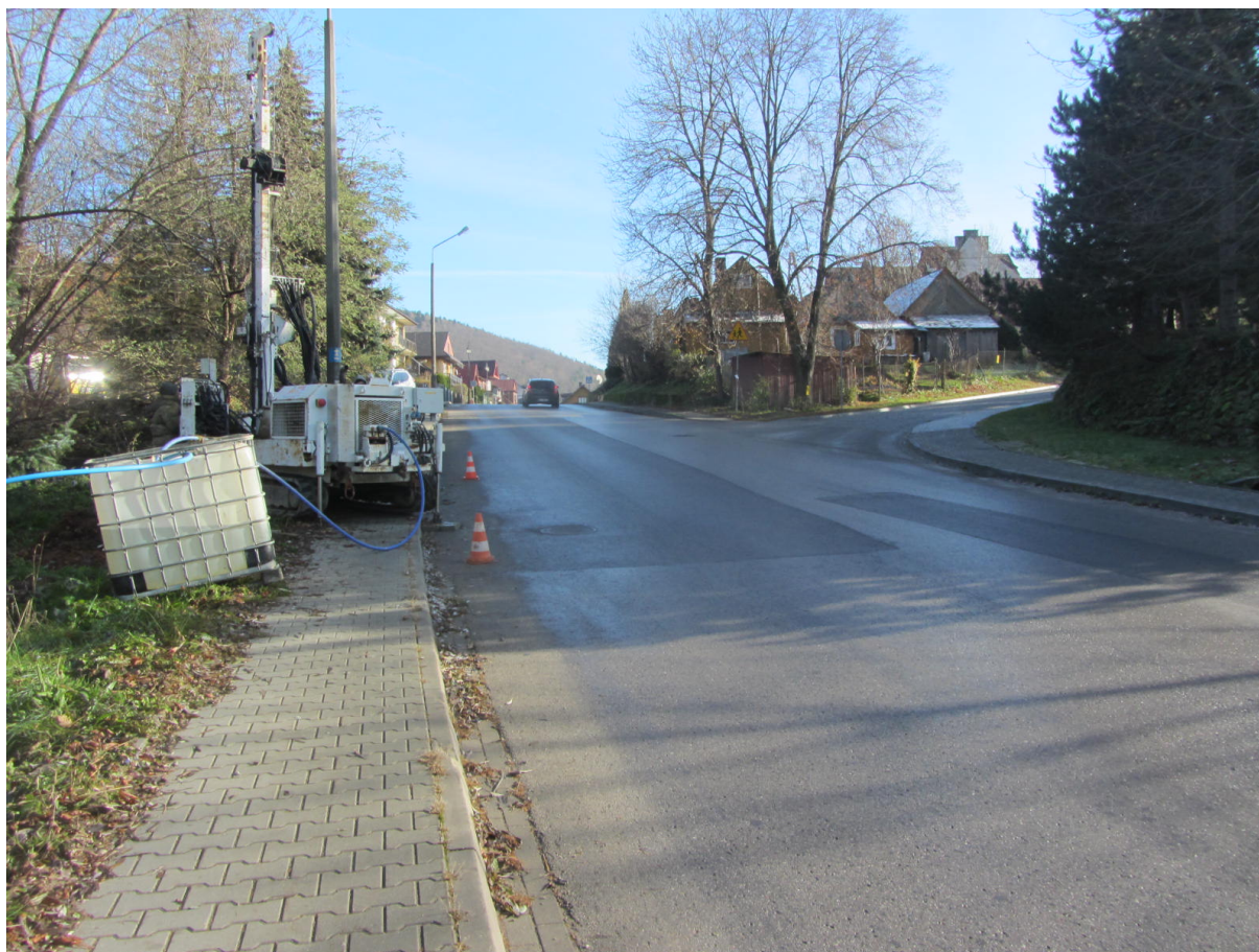
Fot.15 – Wymieniony asfalt w miejscu stabilizacji
