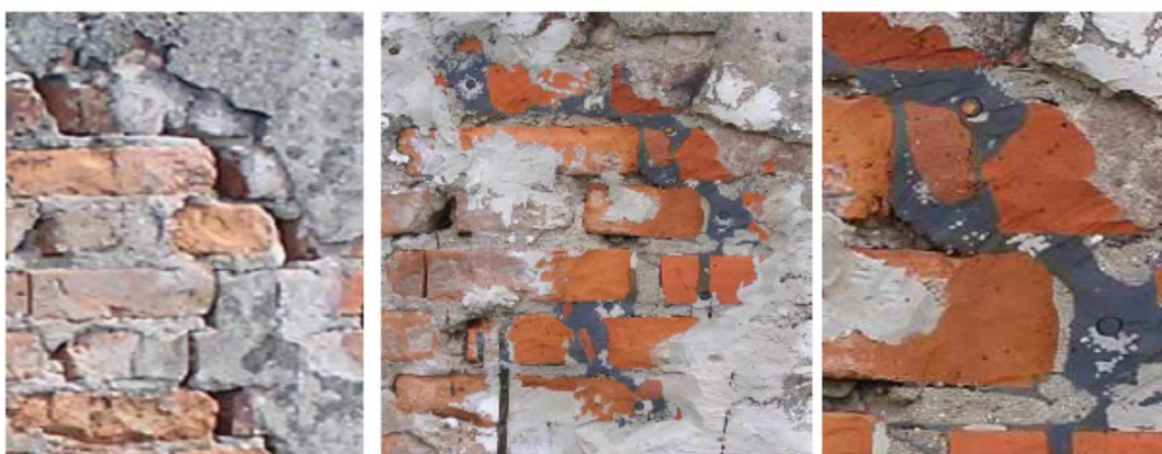
Rys. 3) Rozdzielone pęknięciem elementy konstrukcyjne sklezione specjalną masą polimerową
