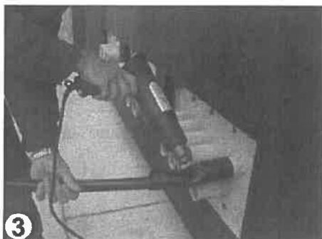
3 Koszulkę termokurczliwą zgrzewamy w ten sposób, aby po zastygnięciu szczelnie zaciśnęła się na przepuscie i na kablu, tworząc w ten sposób szczelną izolację.
