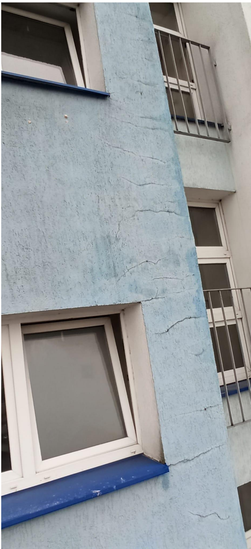
Fot. 7 Spękania na ścianach szczytowych
