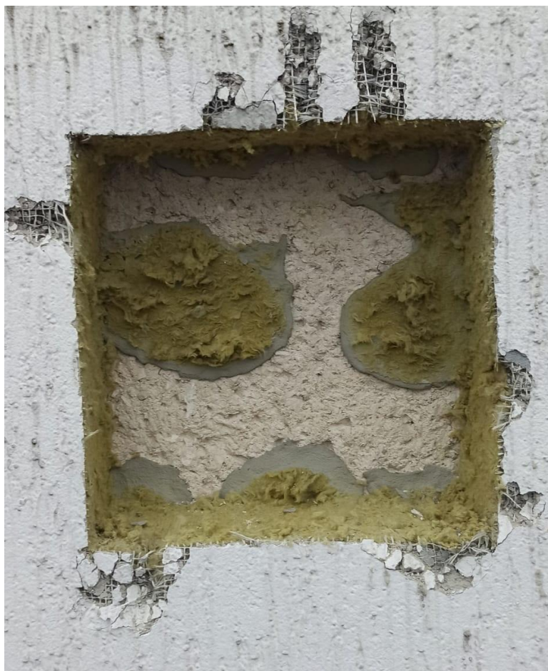
Fot. 5 Odkrywka istniejącego ocieplenia wełna mineralną
