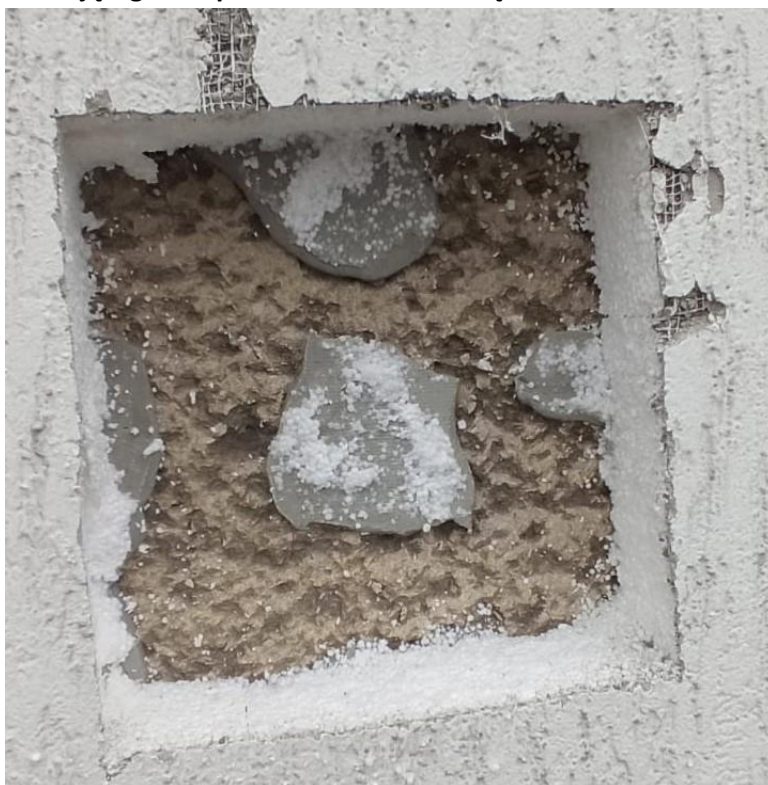
Fot. 6 Odkrywka istniejącego ocieplenia styropianem
