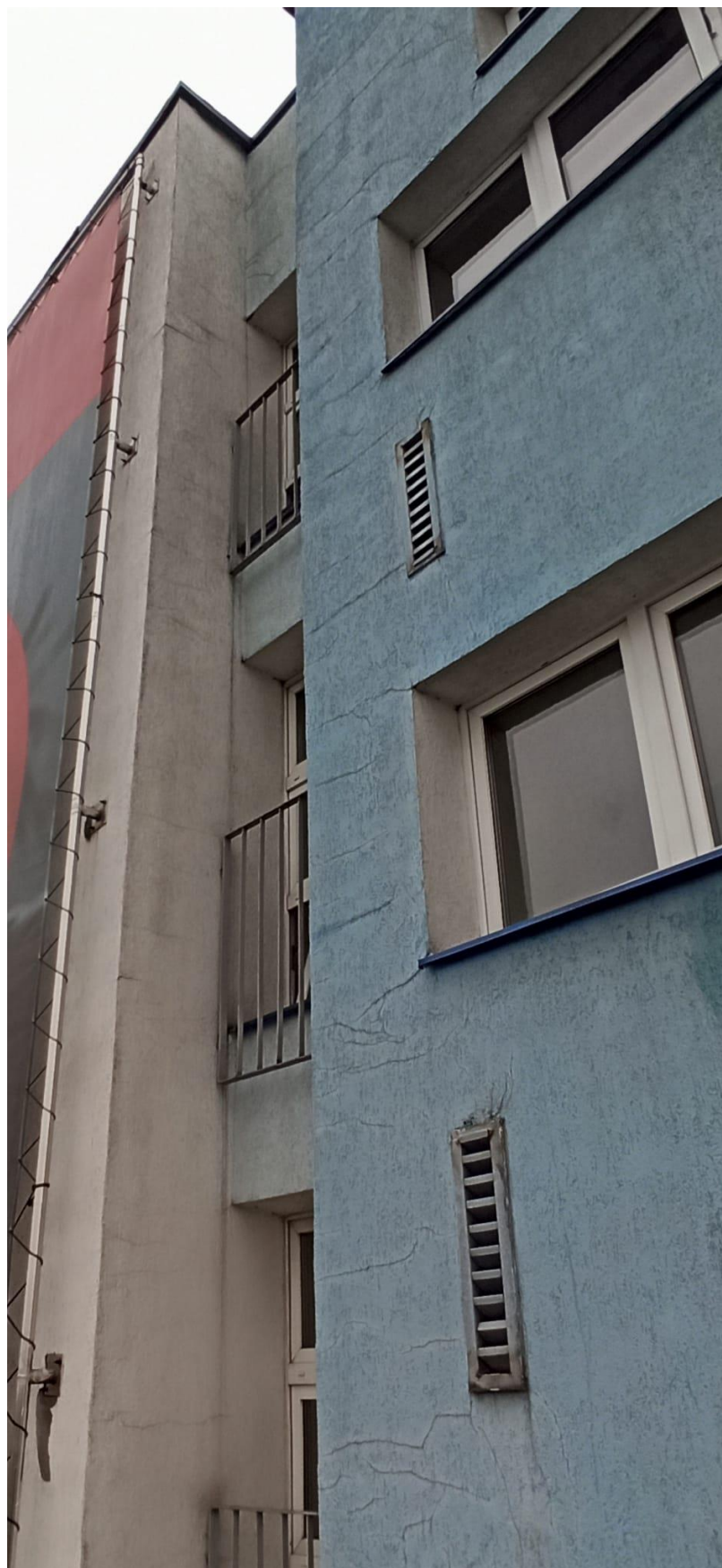
Fot. 8 Spękania na ścianach szczytowych
