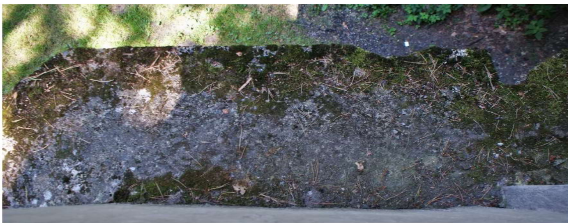
Fot. nr 73 Widok na daszek ponad dolną kondygnacją wieżyczki nr 2 i nr 078 na mapie. Widoczne duże skupiska mchów i porostów, a także drobne wyszczerbienia formy.
