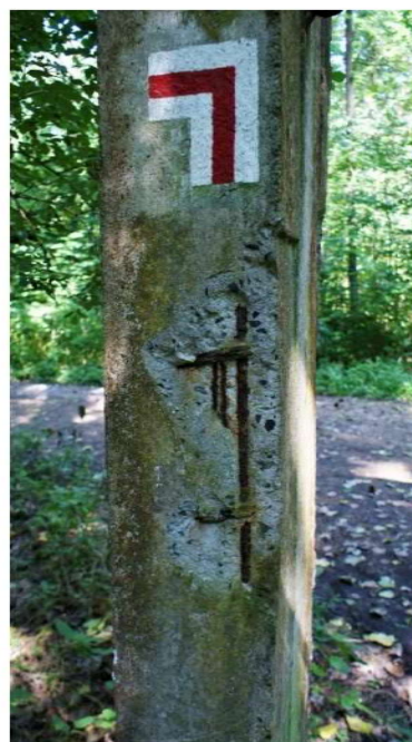
Fot. nr 36 Widok prawego filaru od tyłu bramy obozowej nr 1 i nr 106 na mapie bramy. Widoczne uszkodzenie filaru oraz korodujący metalowy szkielet bramy.
