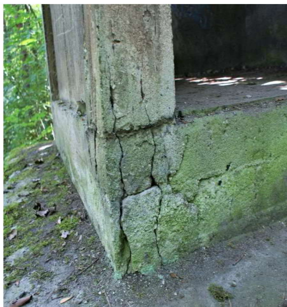
Fot. nr 18 Widoczne szczeliny i rozwarstwianie materiału w dolnej części wejścia do górnej kondygnacji wieżyczki nr 1 i nr 105 na mapie.
