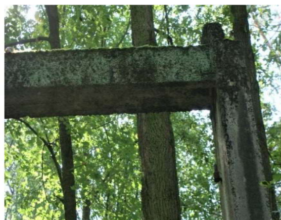
Fot. nr 33 Widok prawej strony górnej belki bramy obozowej nr 1 i nr 106 na mapie, od frontu. Widoczny rozwój mchów i porostów .
