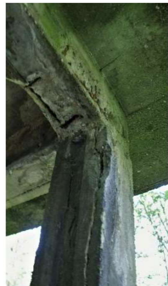
Fot. nr 14 Widoczne uszkodzenia spowodowane przez korodowanie metalowego szkieletu, a także krystalizacja soli na powierzchni i rozrost porostów od wewnętrznej strony daszku z górnej kondygnacji wieżyczki nr 1 i nr 105 na mapie.
