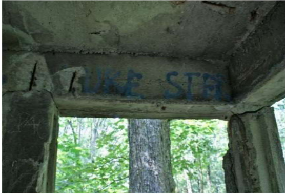
Fot. nr 10. Widoczne uszkodzenia mechaniczne, spowodowane korozją metalowego szkieletu, a także piktogramy/tagi na powierzchni masy betonowej, wewnątrz wieżyczki nr 1 i nr 105 na mapie.
