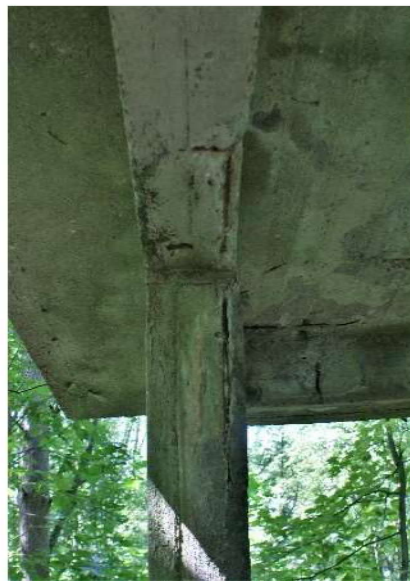
Fot. nr 13 Widoczne uszkodzenia spowodowane przez korodowanie metalowego szkieletu od wewnętrznej strony daszku z górnej kondygnacji wieżyczki nr 1 i nr 105 na mapie.
