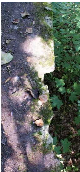
Fot. nr 21 Widok na daszek i fundament górnej kondygnacji. Widoczne jest wyszczerbienie w miejscu przylegania muru obozu do wieżyczki nr 1 i nr 105 na mapie.
