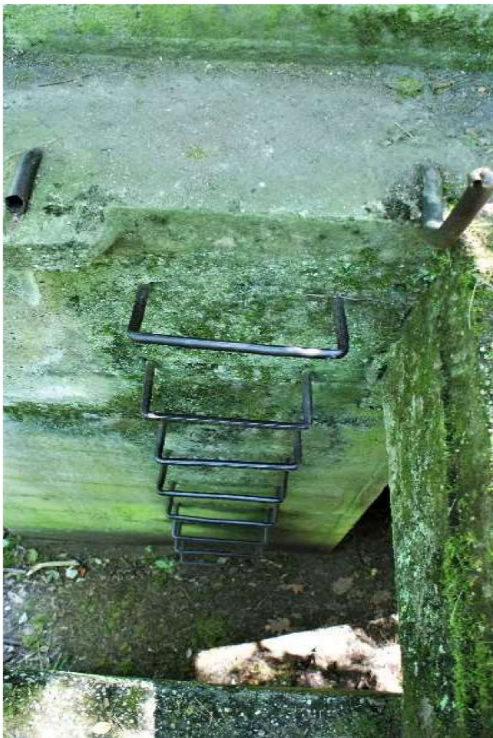
Fot. nr 19 Widok na ścianę od strony SW z uszkodzeniem przypominającym ślad po pocisku, wieżyczka nr 1 i nr 105 na mapie.
