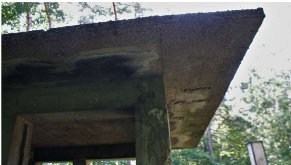
Fot. nr 65 Widok na daszek wieżyczki nr 2 i nr 078 na mapie. Widoczny rozwój soli na powierzchni spodu daszku oraz drobne rozwarstwienia masy betonowej i elementy korodującego szkieletu.
