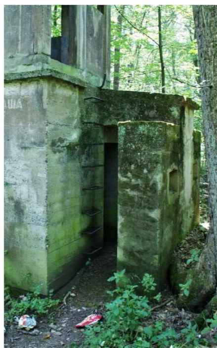
Fot. nr 26 Widok na mur oporowy i rozwój mchów i porostów, a także bliskość drzewa, które bezpośrednio wpływa na stan zachowania tej części wieżyczki nr 1 i nr 105 na mapie.
