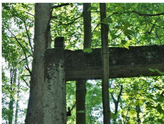
Fot. nr 32 Widok lewej strony górnej belki bramy obozowej nr 1 i nr 106 na mapie, od frontu. Widoczny rozwój mchów i porostów na powierzchni.
