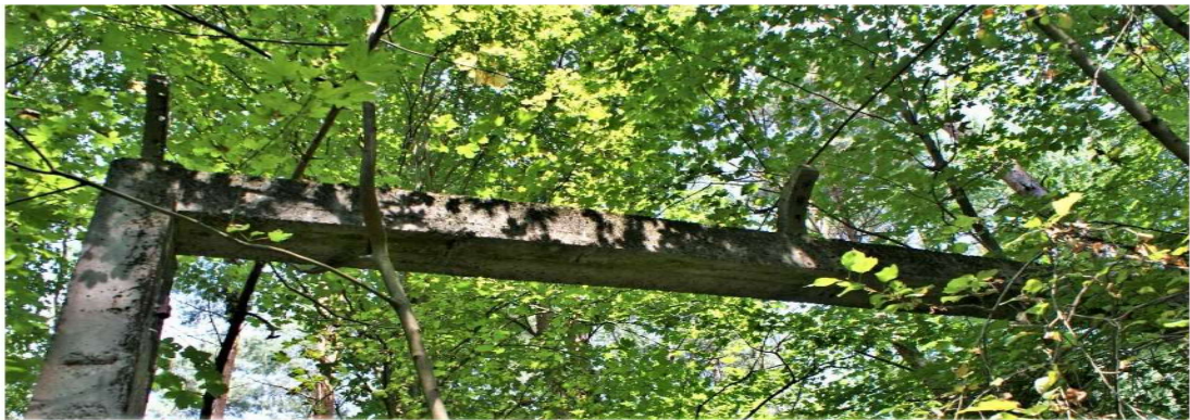
Fot. nr 46 Widok górnej belki od frontu bramy obozowej nr 2 i nr 103 na mapie. Widoczne drzewa rozwijające się w obszarze ustawienia bramy, wpływające negatywnie na jej stan zachowania.
