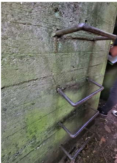
Fot. nr.28 Widok na wejście do dolnej części kondygnacji, przy narożniku ściany od strony drabinek wieżyczki nr 1 i nr 105 na mapie. Widoczne uszczerbienie rogu w masie betonowej.
