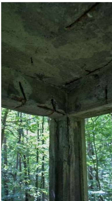
Fot. nr 15 Widoczne uszkodzenia spowodowane przez korodowanie metalowego szkieletu od wewnętrznej strony daszku górnej kondygnacji wieżyczki nr 1 i nr 105 na mapie.
