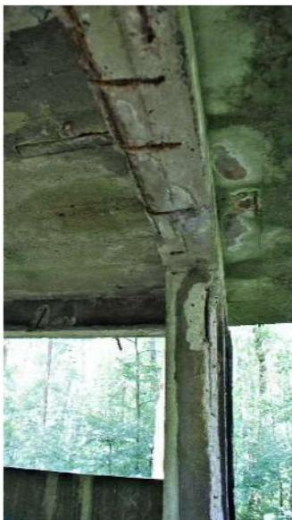
Fot. nr 12 Widoczne uszkodzenia spowodowane przez korodowanie metalowego szkieletu, a także krystalizacja soli na powierzchni i rozrost porostów od wewnętrznej strony daszku z górnej kondygnacji wieżyczki nr 1 i nr 105 na mapie.
