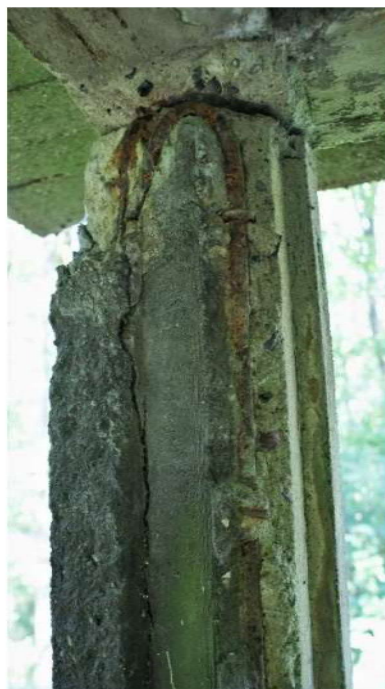
Fot. nr 16 Widoczne uszkodzenia spowodowane przez korodowanie metalowego szkieletu od wewnętrznej strony daszku górnej kondygnacji wieżyczki nr 1 i nr 105 na mapie.
