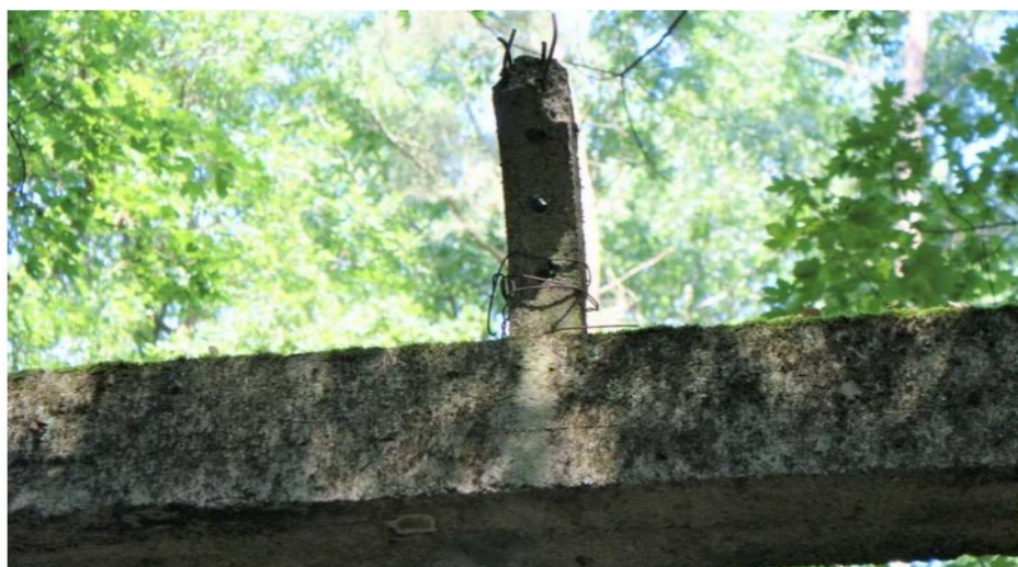
Fot. nr 31 Widok od tyłu górnej belki bramy obozowej nr 1 i nr 106 na mapie. Widoczny środkowy element, do którego był przymocowywany drut kolczasty, z pozostałością drutu, a także zniszczenia mechaniczne elementu oraz jego metalowy, korodujący szkielet.
