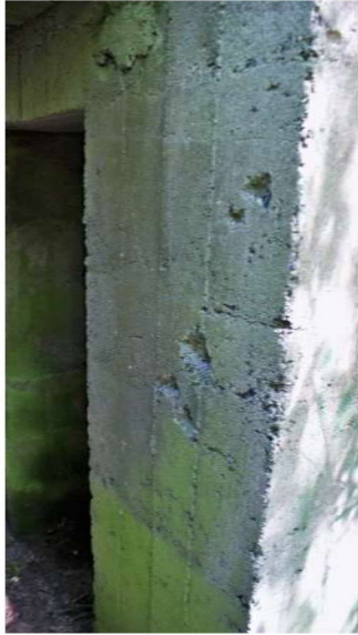
Fot. nr 27 Widok na wejście do dolnej części kondygnacji wieżyczki nr 1 i nr 105 na mapie. Widoczne nieliczne uszkodzenia mechaniczne w masie betonowej.
