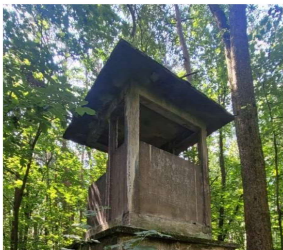
Fot. nr 8 Wieżyczka strażnicza obozowa z widocznymi mchami, porostami i roślinami (na górnym i dolnym daszku oraz górnej kondygnacji). Widoczne są również ataki wandalizmu w formie wrytych piktogramów, nr 1 i nr 105 na mapie.
