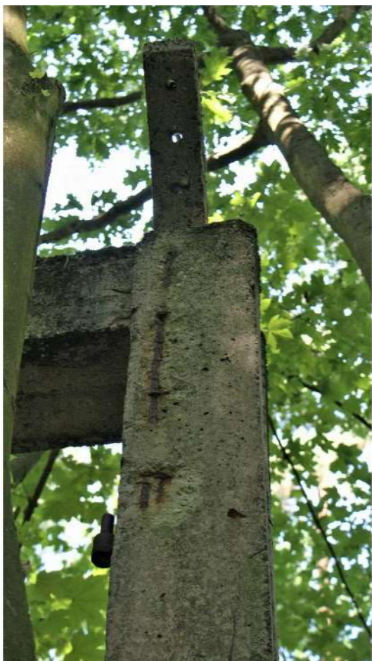
Fot. nr 41 Widok prawego filaru bramy obozowej nr 1 i nr 106 na mapie od tyłu. Widoczne elementy korodującego rusztowania filaru lewego.
