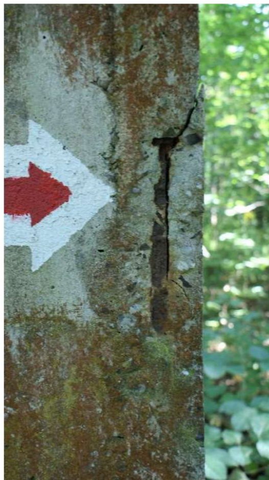
Fot. nr 42 Widok prawego filaru bramy obozowej nr 1 i nr 106 na mapie od tyłu. Widoczne elementy korodującego rusztowania filaru lewego i widoczne rozwarstwienia masy betonowej.
