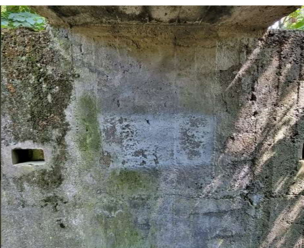
Fot. nr 80 Widok na wewnętrzną część muru oporowego wieżyczki nr 2 i nr 078 na mapie. Widoczne wtórne przemalowania i rozrost mchów.
