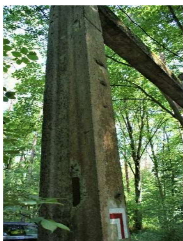
Fot. nr 37 Widok prawego filaru od frontu bramy obozowej nr 1 i nr 106 na mapie. Widoczne uszkodzenie filaru, rysy w betonie oraz korodujący metalowy szkielet bramy.
