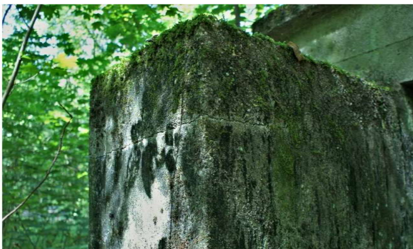
Fot. nr 22 Widok na górną część muru oporowego, widoczne szczeliny w betonie oraz stan porośnięcia powierzchni przez mchy i porosty muru wieżyczki nr1 i nr 105 na mapie.
