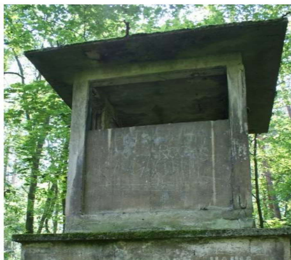
Fot. nr 9 Wieżyczka strażnicza obozowa z widocznymi mchami i porostami i roślinami (na górnym i dolnym daszku oraz górnej kondygnacji). Widoczne są również ataki wandalizmu w formie wrytych piktogramów nr 1 i nr 105 na mapie
