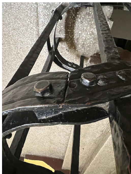
Fot. nr 17 i 18. Widok oryginalnych połączeń i obróbki prętów balustrady
