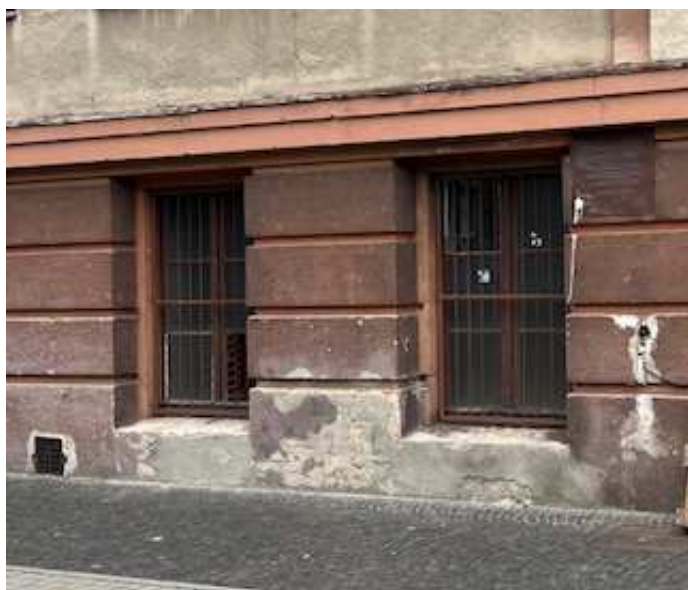
Fot. nr 10. Ubytki tynków i powłok malarskich
