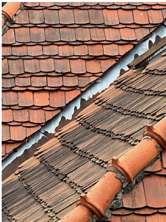
Fot. nr 5 i 6. Stan pokrycia i obróbkę blacharskich dachów łącznika
