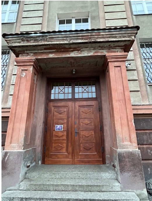
Fot. nr 7. Stan tynków portalu wejścia od strony podwórza
