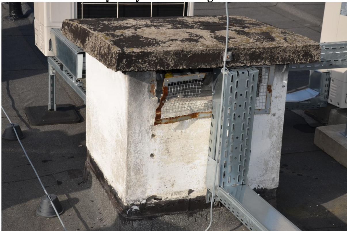
Zdjęcie 33. Budynek B uszkodzona kratka komina.
