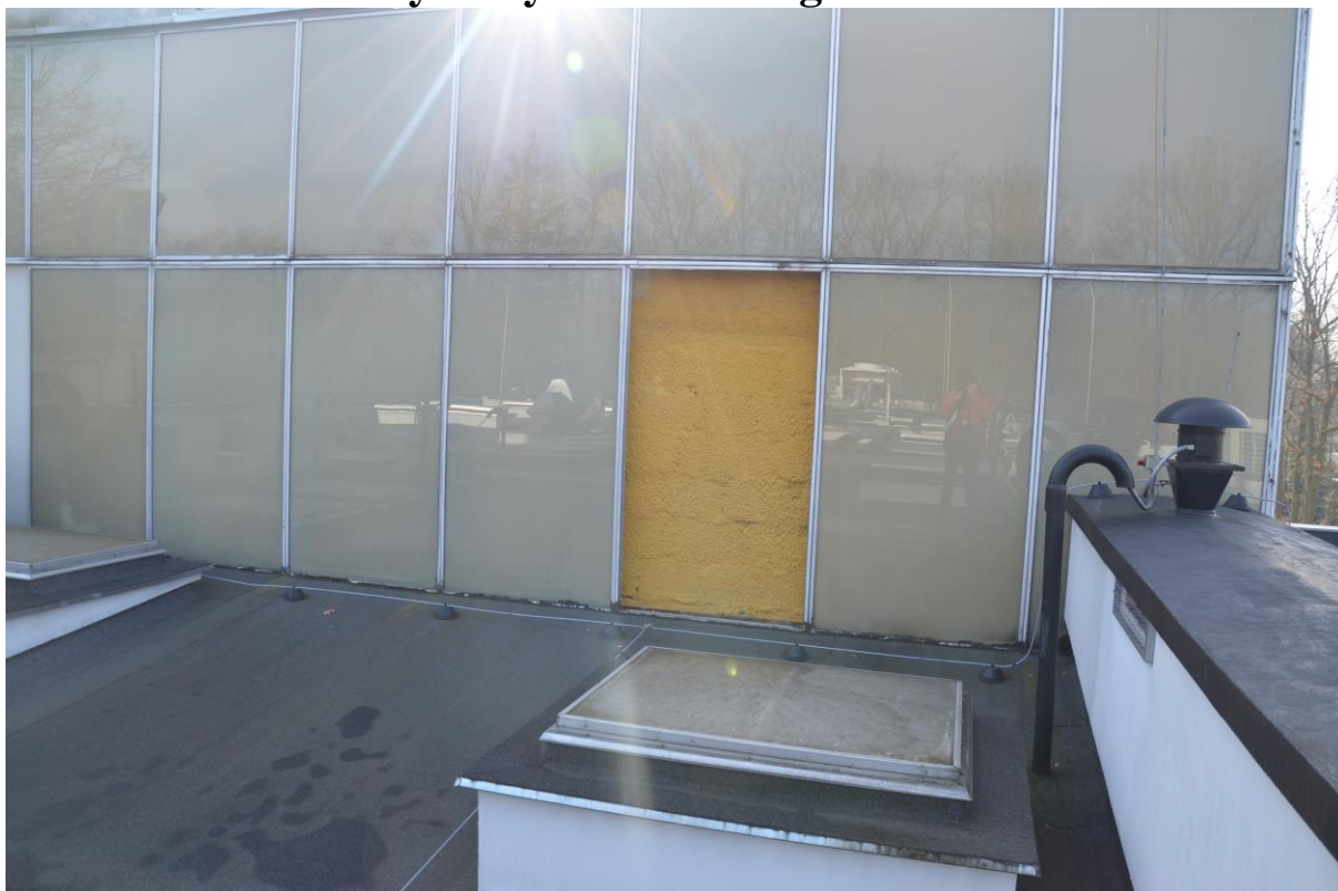
Zdjęcie 31. Budynek H4 brak płyty elewacyjnej.
