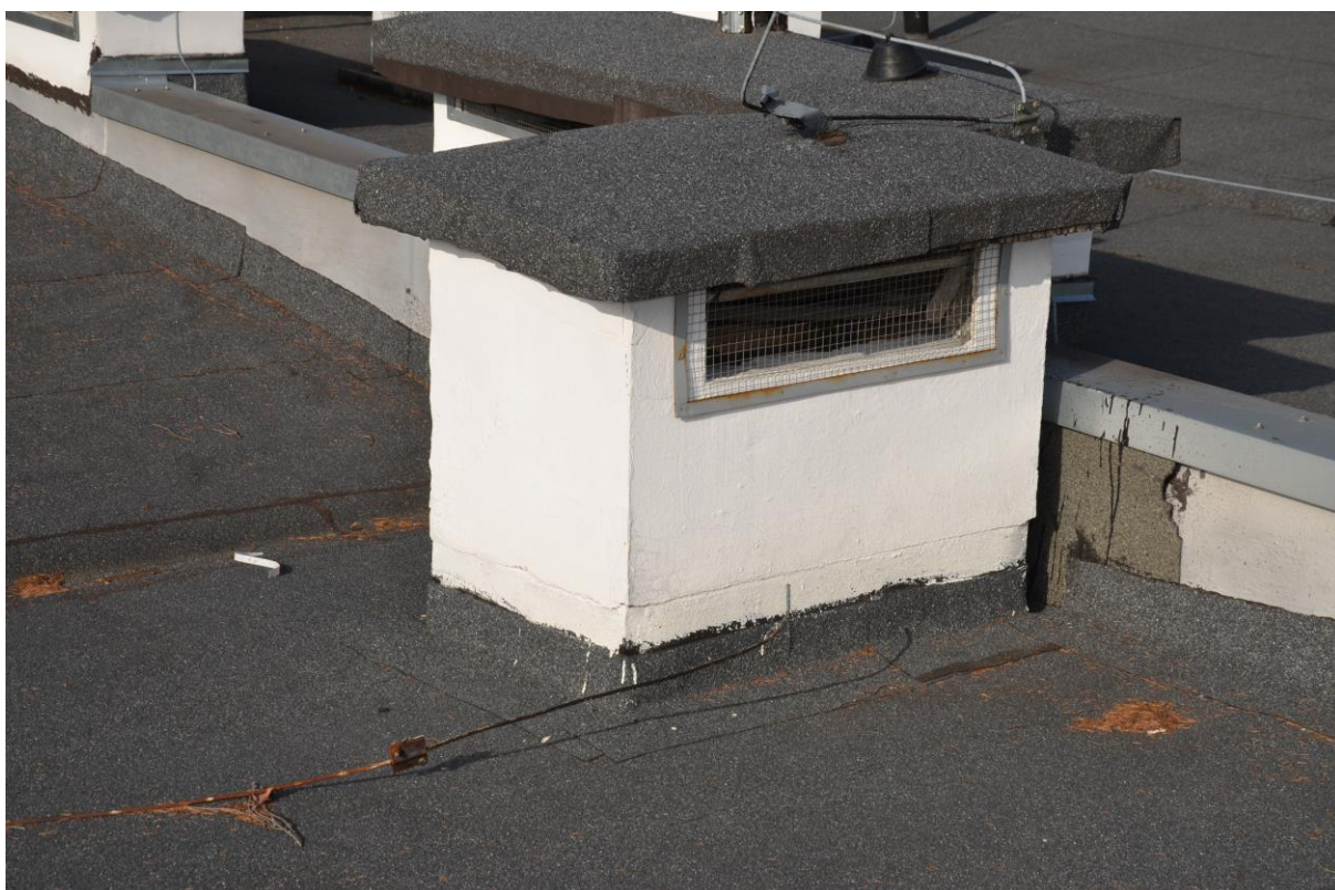
Zdjęcie 32. Budynek C rozpięta instalacja odgromowa.
