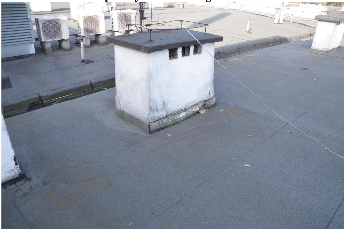
Zdjęcie 35. Budynek F uszkodzona wydra komina.
