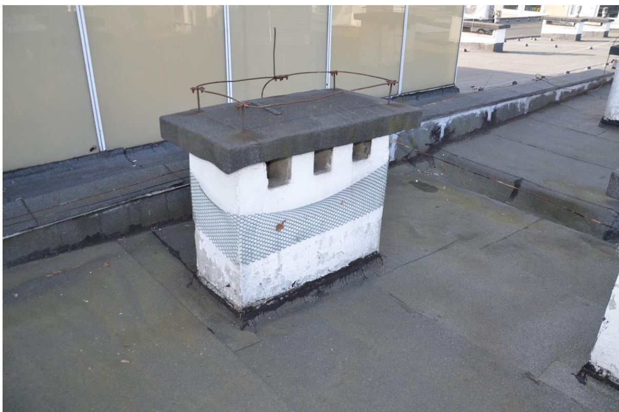
Zdjęcie 36. Budynek F nieskuteczna ochrona otworu wentylacyjnego komina.
