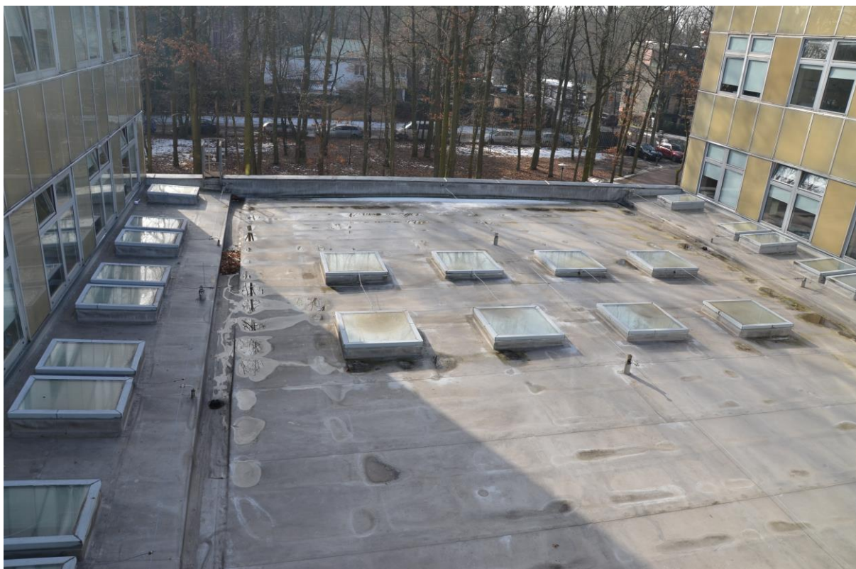
Zdjęcie 30. Budynek H6 pokryty membraną do oczyszczenia koryto z liści.
