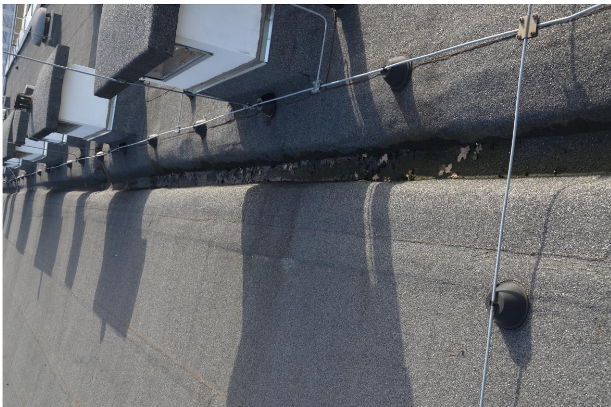
Zdjęcie 28. Budynek E1 oczyścić koryto ze żwirku papowego.
