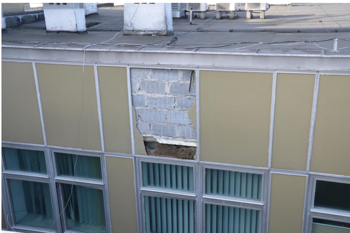
Zdjęcie 34. Budynek F brak płyty elewacyjnej.
