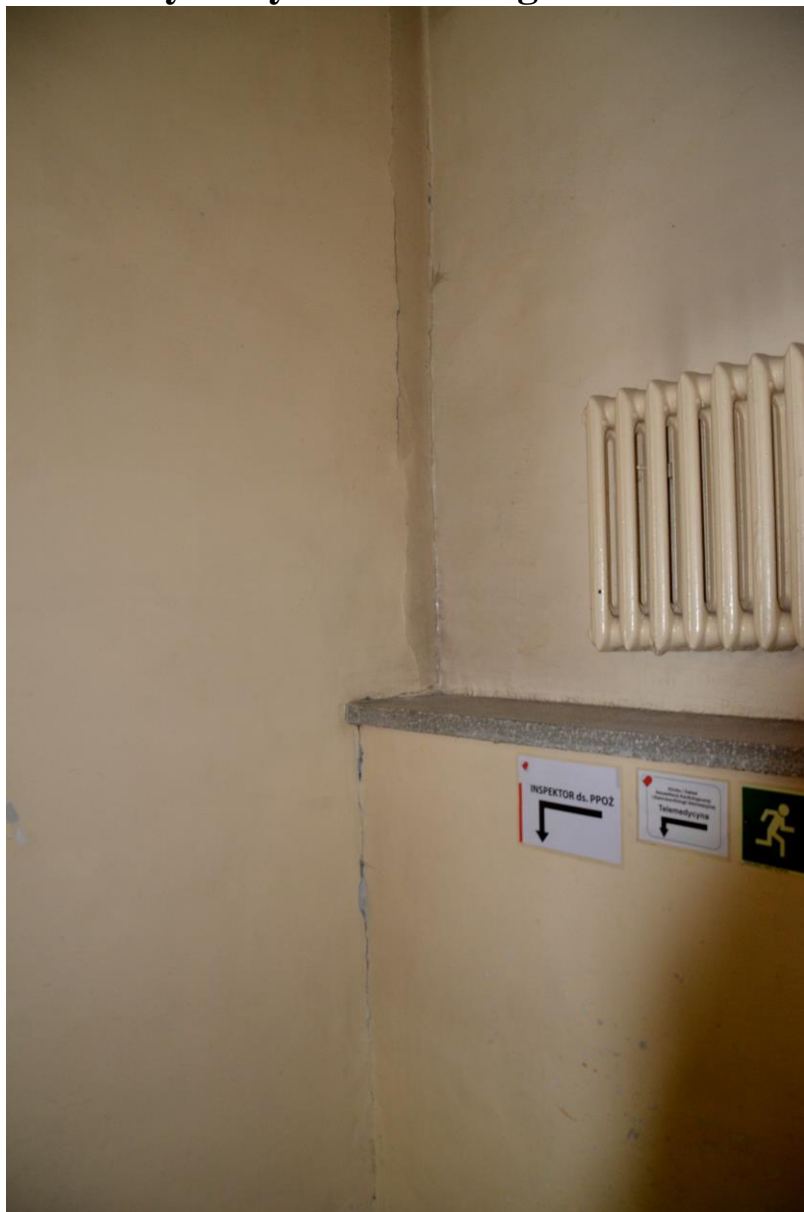
Zdjęcie 43. Pęknięcie ściany w zejściu do piwnicy CZG.
