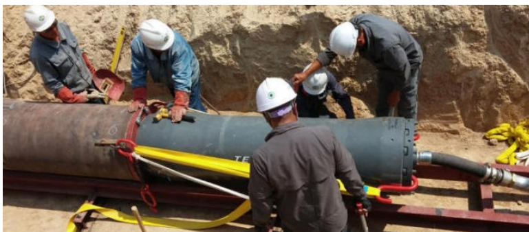
Rys. 28. Przecisk z ubijakiem umieszczonym za rurą stalową
