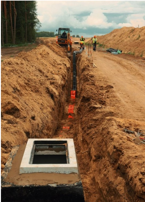
Rys. 34. Zamontowana studzienka kablowa
