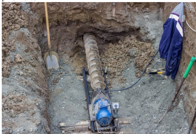
Rys. 30. Wykonywanie przewiertu
