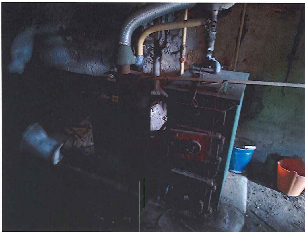
Zdj. Nr 9: Widok na dwa piece grzewcze - na gaz i na węgiel/drewno. Pomieszczenie kotłowni - pom. nr 0.4. Wszystkie instalacje w budynku należy wymienić w całości.
