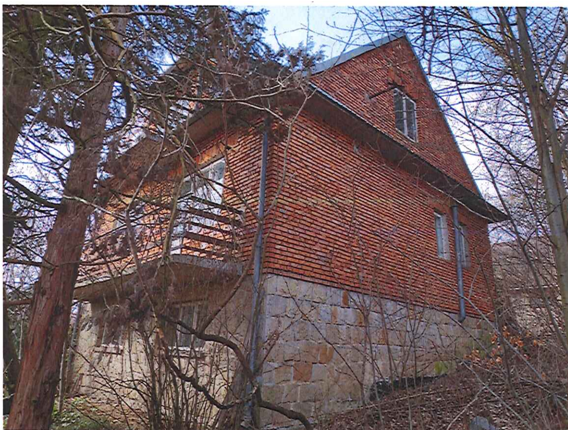
Zdj. Nr 2: Widok na narożnik elewacji północno-wschodni. Poziom przyziemia wykonany jest od zewnątrz kamieniem piaskowiec wypełniony spoinami.
