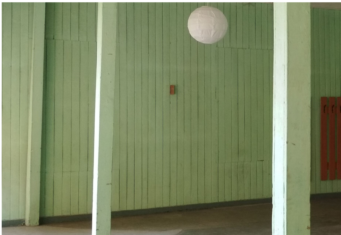
Ślady po zasklepionych oknach w ścianie od strony elewacji wschodniej.
